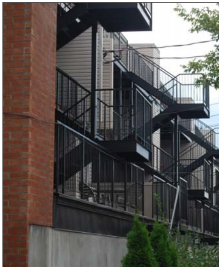
Bâtiment résidentiel Quartier Parc-Extension
