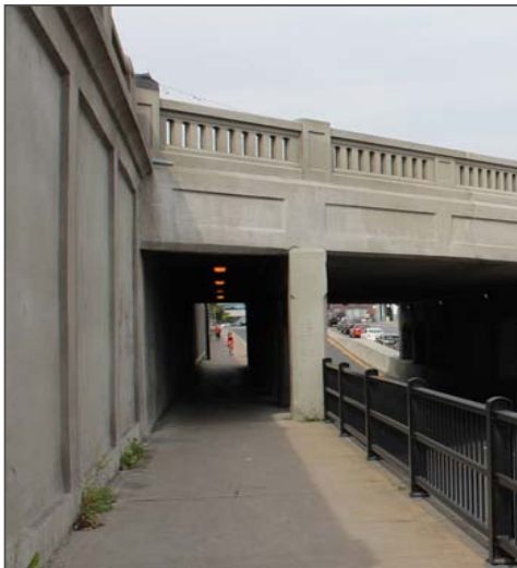
Passage au niveau de la rue Saint-Zotique
