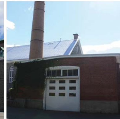
J.1 - Entrepôt à charbon et cheminée
