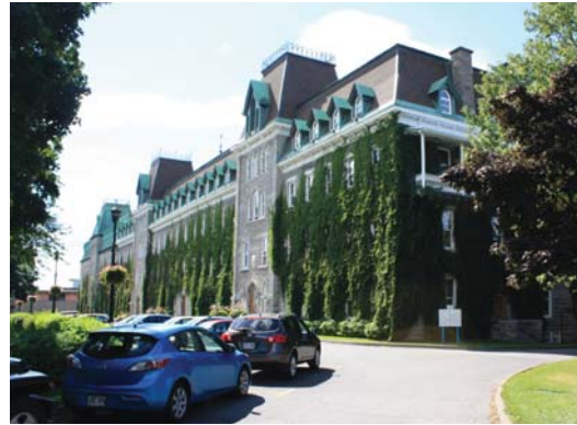
A - Bâtiments 1881-88 et 1929
