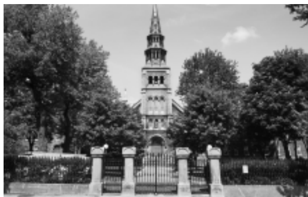
24.E.10 La chapelle de l'Invention-de-la-Sainte-Croix, érigée en 1874, fait partie intégrante du complexe de la maison mère des Sœurs Grises. Crédits photographiques : Réjean Martel
