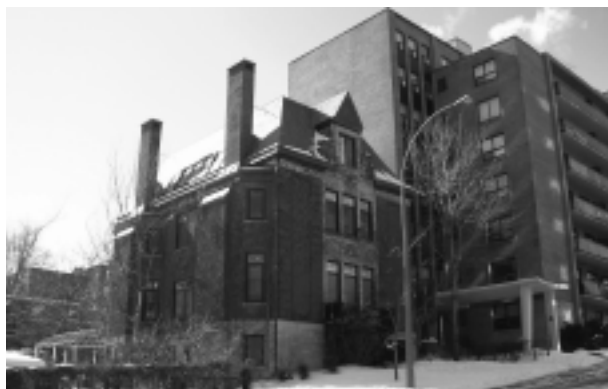
24.E.32 Maison Charles-Colquhoun-Ballantyne, 3480-3484, rue de la Montagne. Crédits photographiques : Patri-Arch Patrimoine et Architecture
