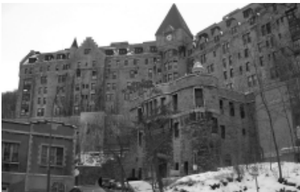
24.E.26 Hôpital Royal Victoria, 687, avenue des Pins Ouest. Crédits photographiques : Patri-Arch Patrimoine et Architecture
