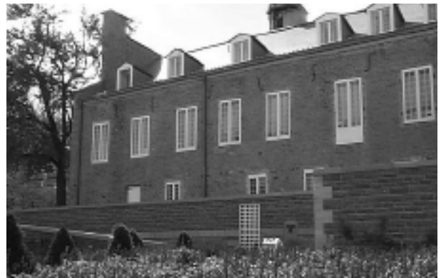
24.E.44 Le château Ramezay. Crédits photographiques : Société de développement de Montréal; photo, Denis Tremblay
