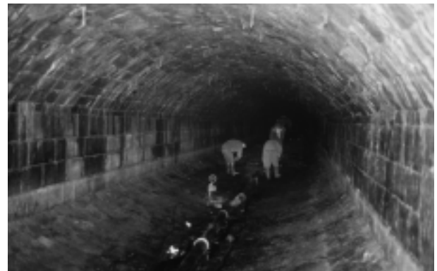
24.AP.3 et BjFj-004 Le collecteur William a été construit en 1832 pour canaliser la rivière Saint-Pierre ou Petite Rivière. Le collecteur est imbriqué au marché Sainte-Anne. Cet imposant ouvrage de maçonnerie de pierre est conservé intégralement sous la place d'Youville, il a été désaffecté en 1990.
