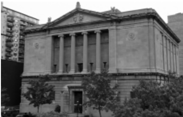
24.E.34 Masonic Memorial Temple, 1850, rue Sherbrooke Ouest. Crédits photographiques : Réjean Martel
