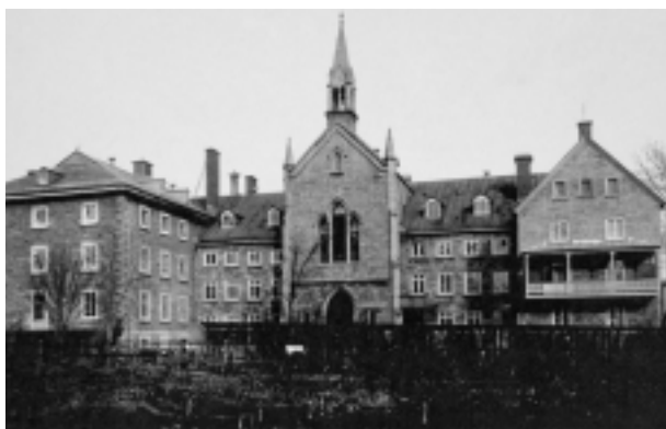
BjFj-062 Les vestiges de la maison de la Providence ont été conservés in situ lors de l'aménagement de la place Émilie-Gamelin. Centre Émilie-Gamelin.
