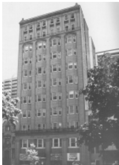
24.E.35 Appartements Maxwellton (1914), Edward Maxwell, architecte, 900, rue Sherbrooke Ouest. Crédits photographiques : Communauté urbaine de Montréal (1987)
