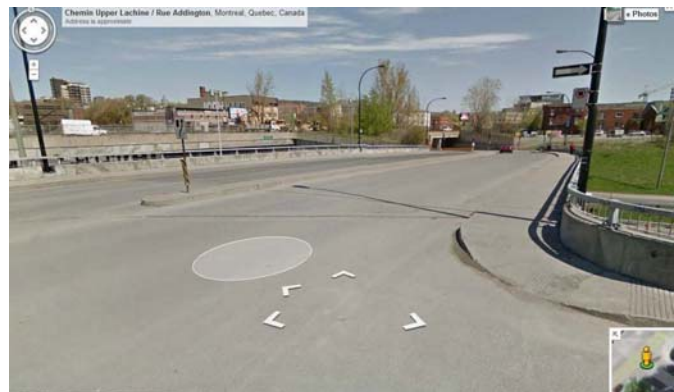
Figure 2 Chemin Upper Lachine vers l'Est, vue du viaduc
