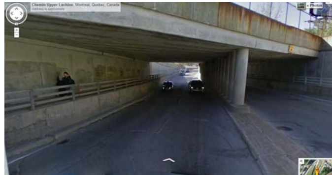
Figure 1-Viaduc Upper Lachine / Décarie, vue vers l'Ouest
