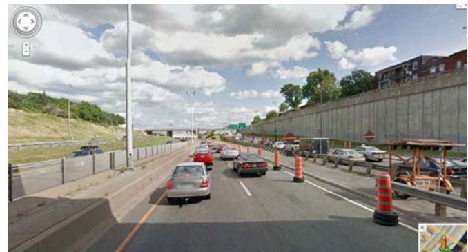
Figure 7 Canyon Décarie / Addington, vue du mur de béton
