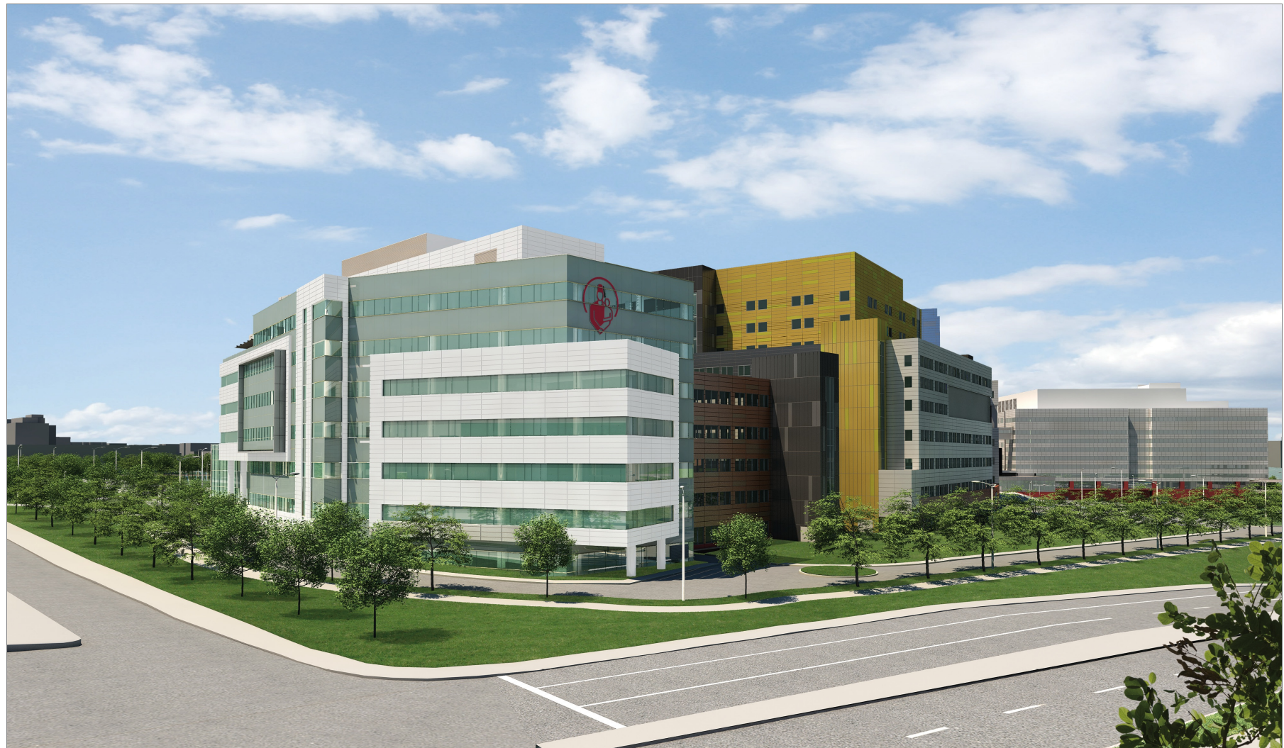
Vue depuis l'intersection de la rue Saint-Jacques et du boulevard Décarie
