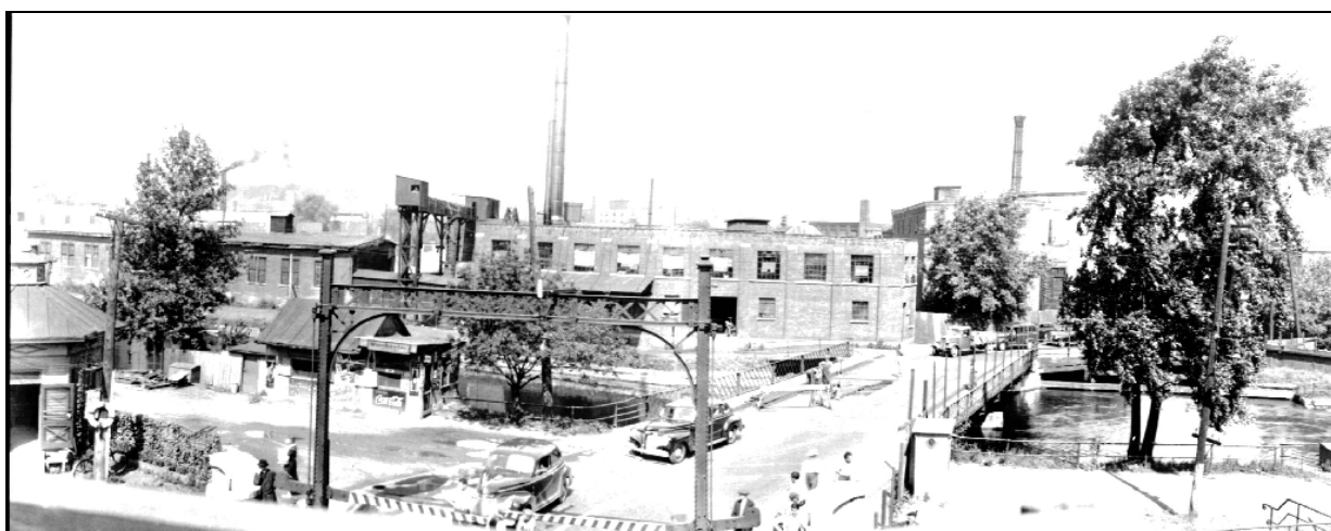
Complexe industriel au nord de l'écluse Saint-Gabriel (site de la Sonoco), Photo 1942, Bibliothèque et archives Canada
