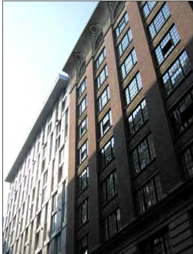
Corniche et travées similaires des deux parties de l'édifice Unity. Atelier Big City, 2003
