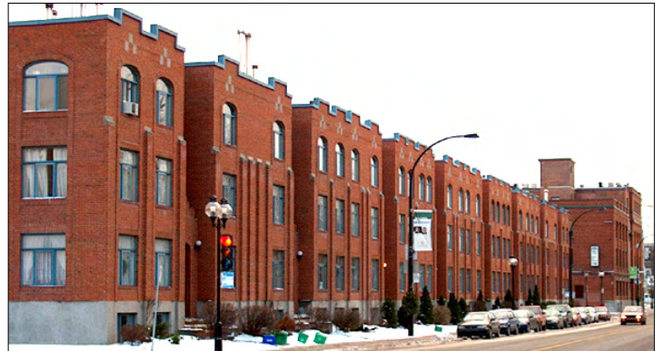
Cet ensemble s'intègre, par sa composition et son parement de brique d'argile, au contexte industriel de ce segment de la rue Notre-Dame.
