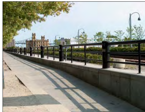
La promenade de la nouvelle rue de la Commune
