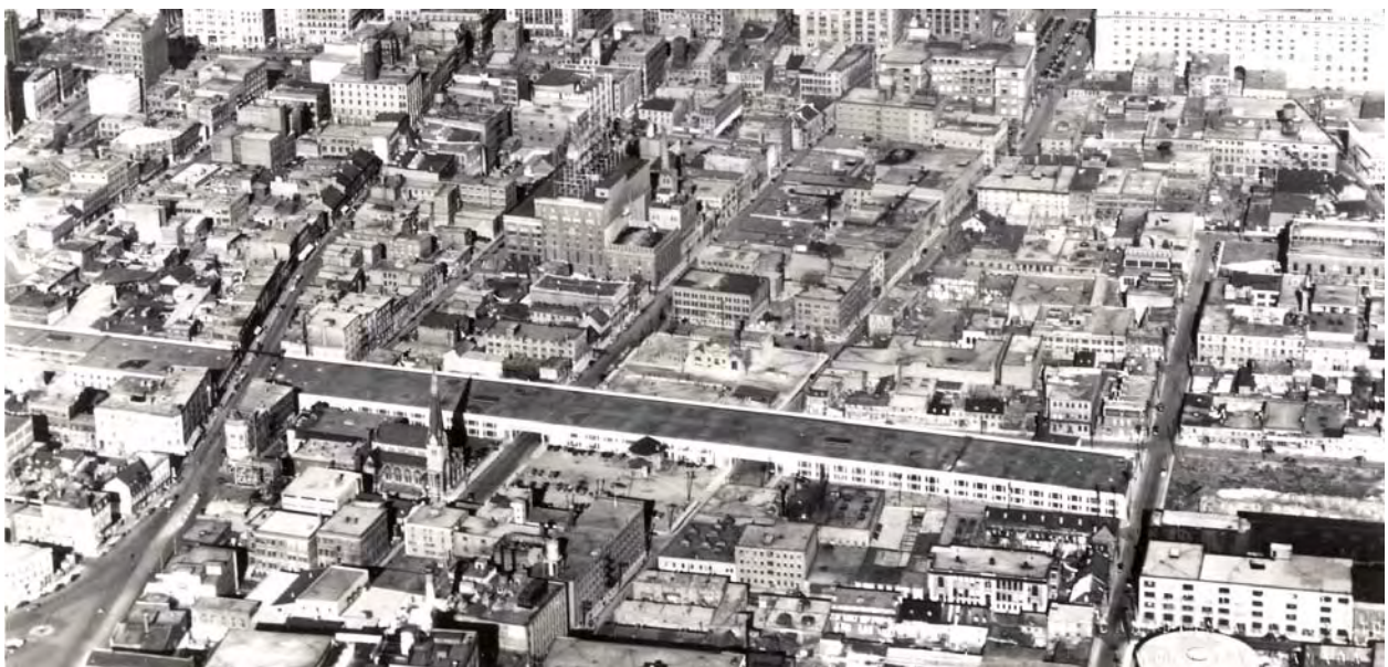
Photo aérienne montrant le viaduc ferroviaire, vers l'est, en construction au cours des années 1940 Canadian Airways Limited.
