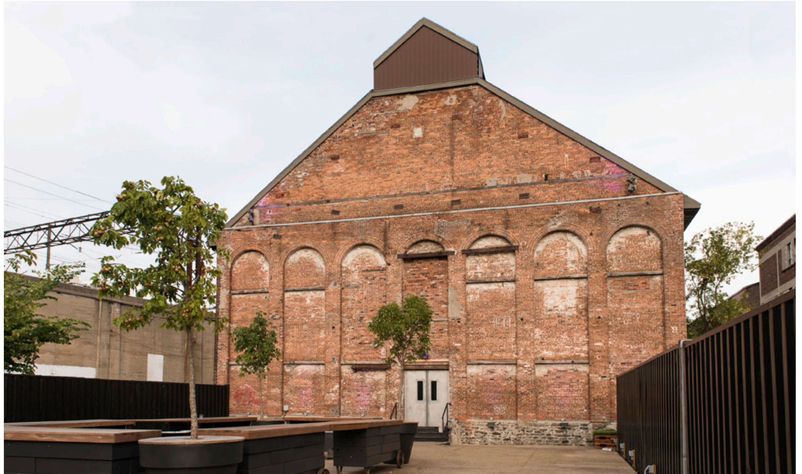
L'édifice de la New City Gas Co. vu depuis la rue Ottawa. VM, 2012
