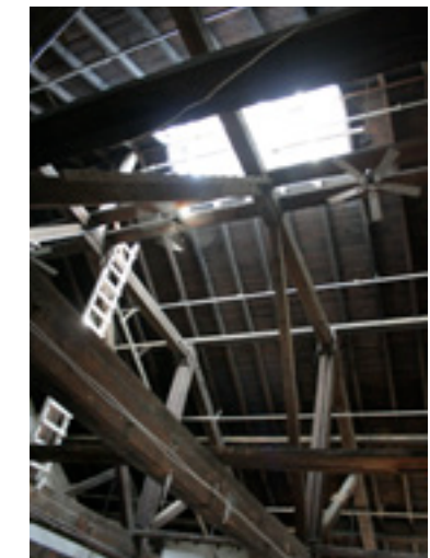
Les fermes de la toiture de l'édifice abritant les gazomètres datent de 1849 ont une portée de 80 pieds.
