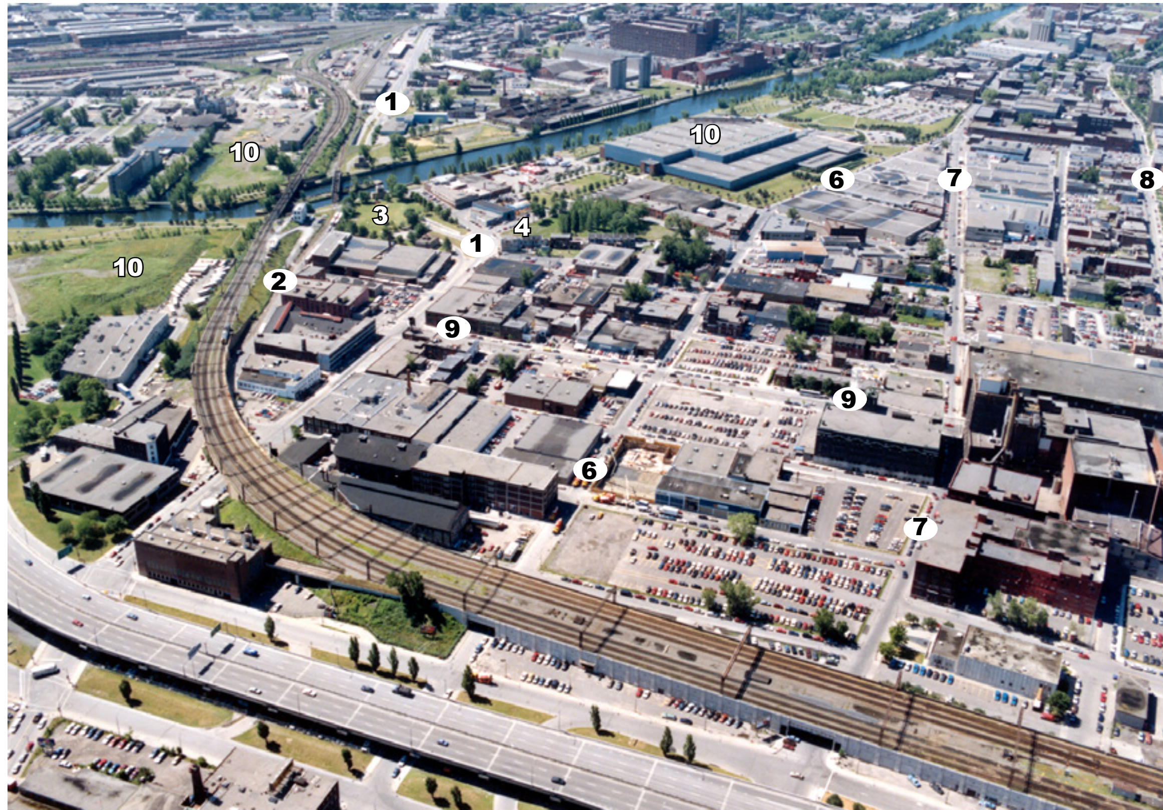
Cette photo du secteur de Griffintown, vers 1980, montre l'autoroute Bonaventure en premier plan, les nombreux terrains qui servent d'aires de stationnement et les bassins du canal qui ont été remblayés (le bassin Peel et les bassins Saint-Gabriel). Vers 1992.
