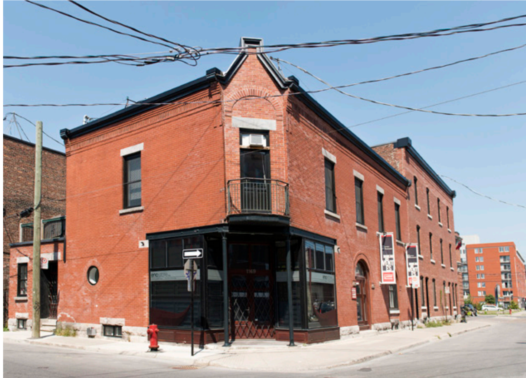
Bloc O'Conneil à l'angle des rues Murray et Ottawa. VM, 2012
