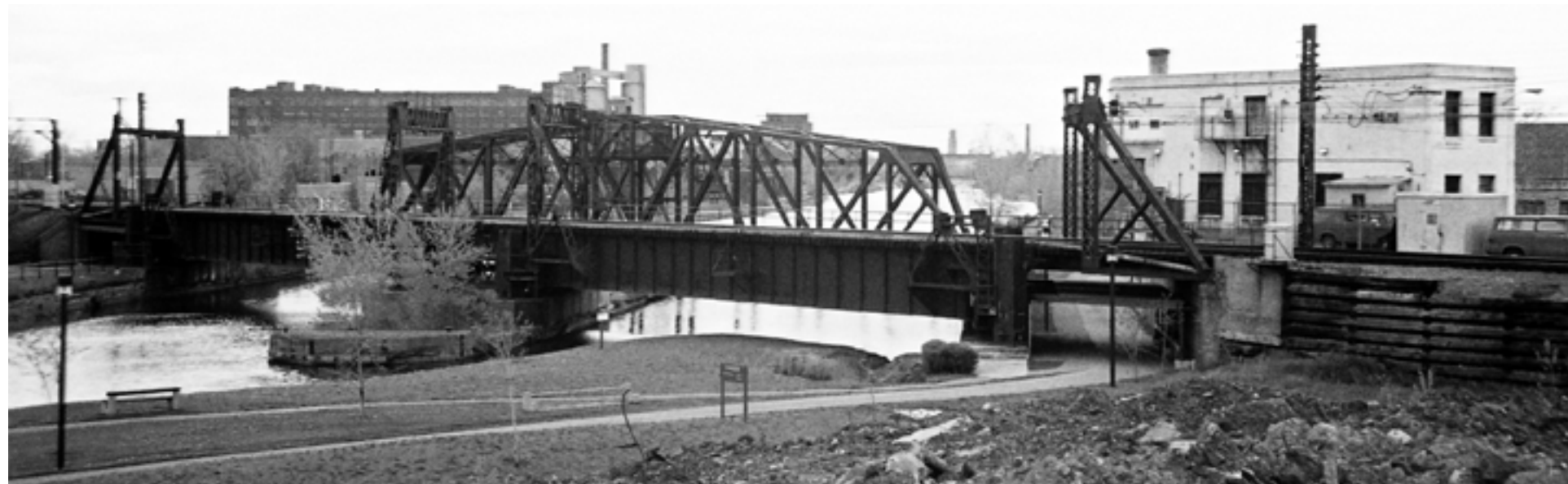
Les ponts ferroviaires du CN et de l'antenne Brennan ainsi que le poste de contrôle. 1984 (photo G. Bodson)
