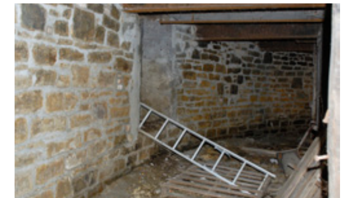
Intérieur de la base du gazomètre nord.
