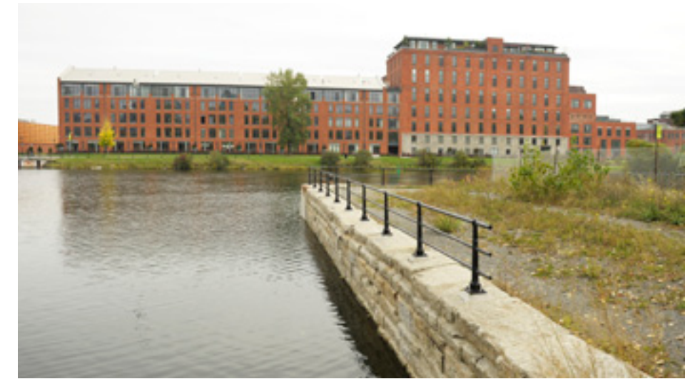
Une section du bassin No 4, dégagée par Parcs Canada en 2010, fait ressortir la monumentalité des quais et des bassins Saint-Gabriel. VM, 2012
