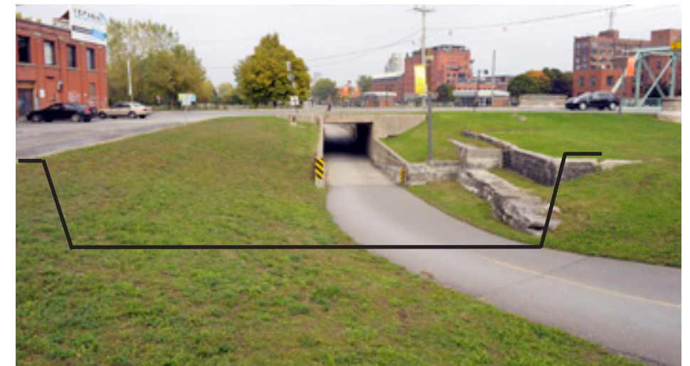
Emplacement approximatif du canal de 1825 (le trait noir en indique le profil) remblayé vers 1965 pour constituer un stationnement de camions. VM, 2012
