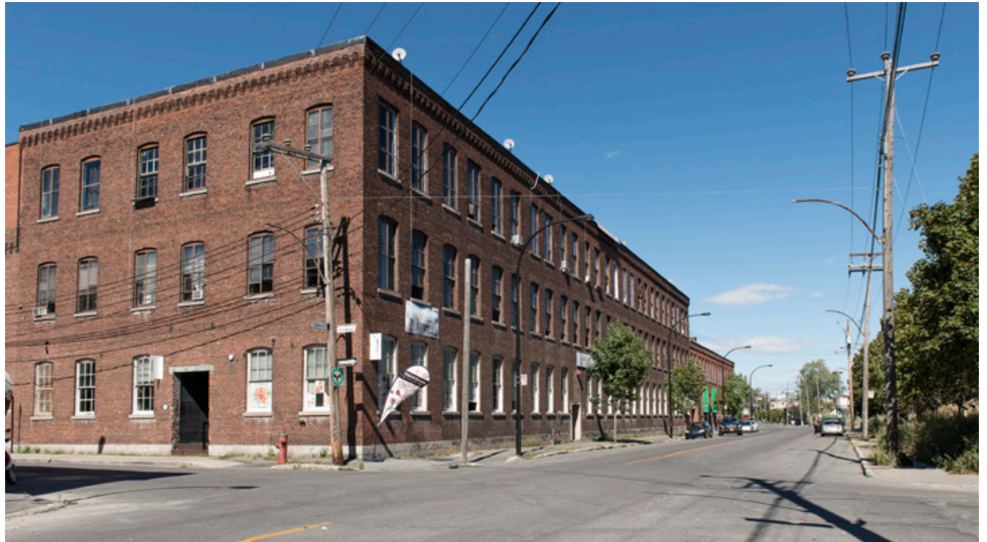
L'édifice de la Northern Electric and Manufacturing Co. à l'angle des rues Richmond et William. VM, 2012
