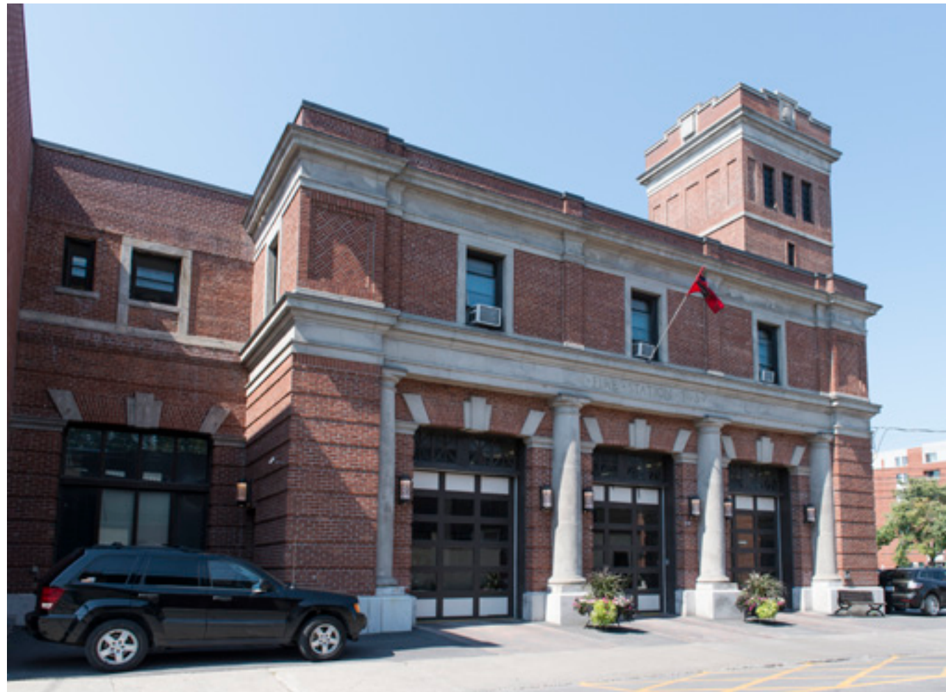
Poste d'incendie no 3 VM, 2012
