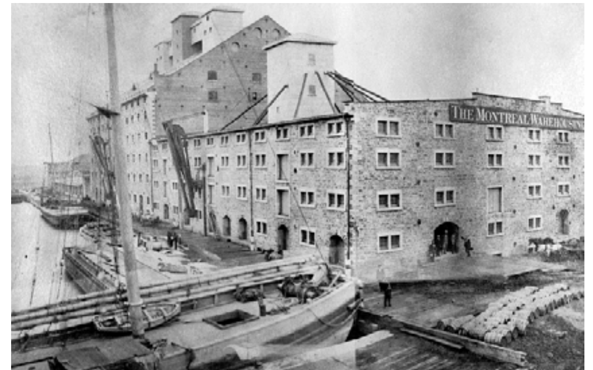
La Montreal Warehousing Co. montre l'envergure des édifices en bordure des quais vers 1875. MP-0000.11 Musée McCord.
