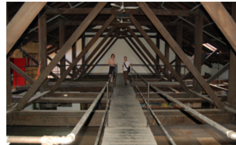
Les fermes de la toiture de l'édifice abritant les gazomètres datent de 1849 ont une portée de 80 pieds.
