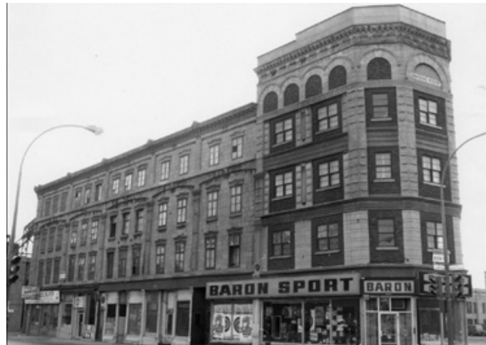
La désaffectation du secteur et l'hypertrophie du réseau viaire favorisent la fermeture du rez-de-chaussée de l'édifice Rodier. AVM, vers 1980
