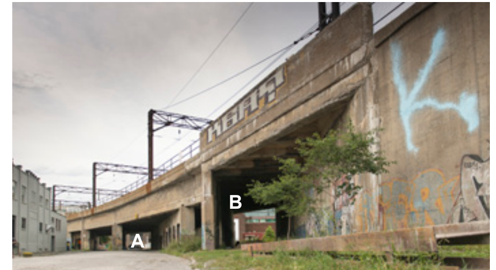
Le viaduc du CN vu depuis la convergence de la rue Smith (A) et du passage de l'antenne ferroviaire Brennan (B). VM, 2012
