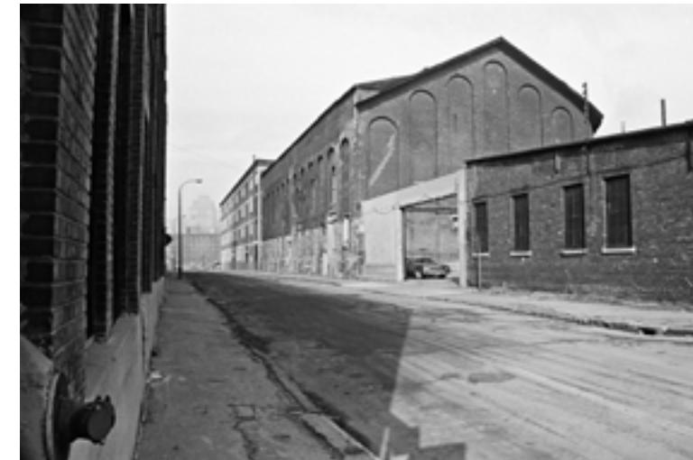
Rue Ann, la composition des murs de l'édifice des gazomètres est rythmée par pilastres et arcades porteurs, qui transmettent au sol les charges de la vaste toiture.
