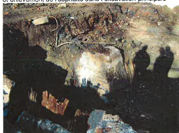
Photo 5 : Nombreuses structures des anciennes fondations
