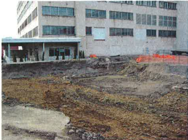
Photo 8 : Continuation de l'excavation principale janvier 2010
