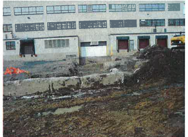
Photo 9 : Prolongement de l'excavation principale janvier 2010
