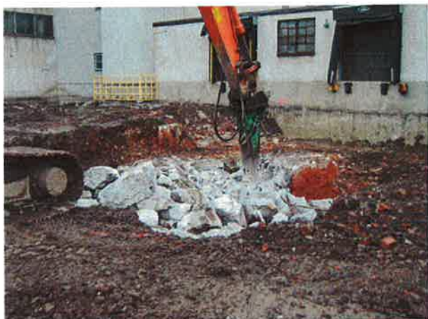
Photo 12 : Découverte des structures en béton de l'ancien bâtiment décembre 2009
