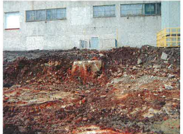
Photo 11 : Profil des sols de l'excavation avant ségrégations des matières résiduelles
