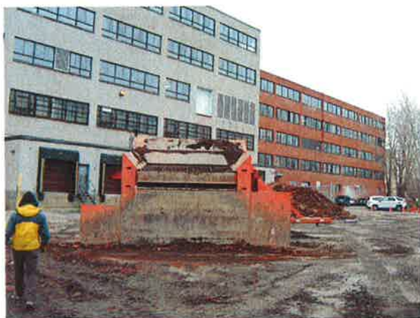
Photo 13 : Tamis pour séparer les matières résiduelles des sols contaminés
