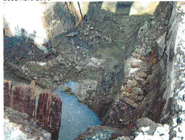
Photo 6 : Excavation principale – décembre 2009
