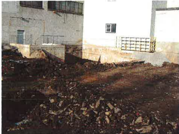
Photo 7 : Début de l'excavation principale dans le coin des deux bâtiments
