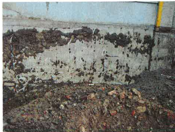
Photo 4 : Excavation principale au coin des deux bâtiments - décembre 2009
