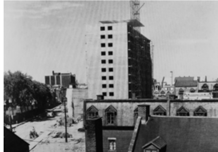
Les Habitations Jeanne-Mance en construction : une transformation radicale du faubourg Saint-Laurent
