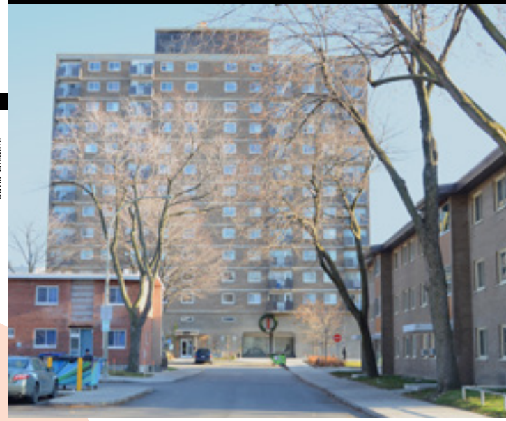
Passage piéton à réaménager sous le 200, rue Ontario Est
