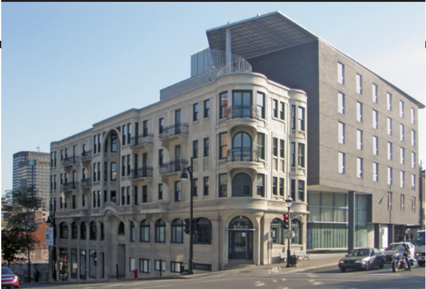
Édifice de l'architecte J.-A. Godin et extension de Dan Hanganu
