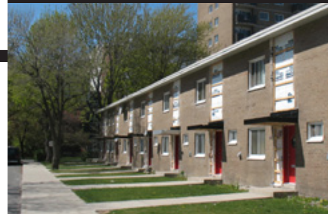
Maisons de ville en cours de restauration aux Habitations Jeanne-Mance
