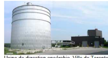
Usine de digestion anaérobie, Ville de Toronto
