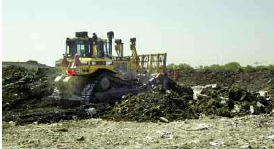
Travaux de réhabilitation sur le site du CESM
