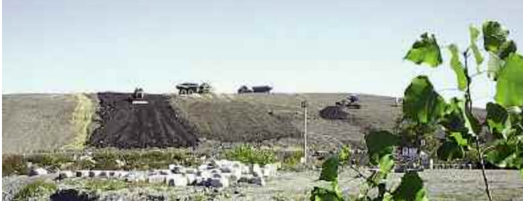
Vue du site d'enfouissement
