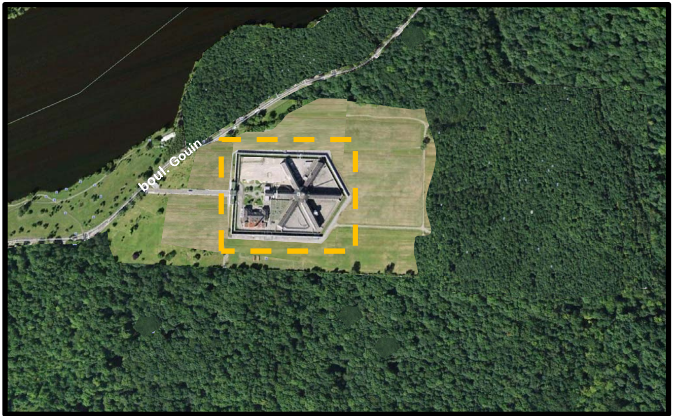
Figure 1 1912 – Construction de la prison de Bordeaux (montage).
