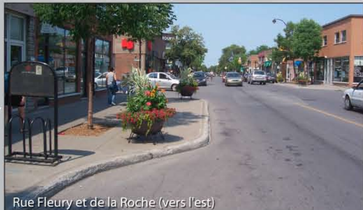
a) Avancée de trottoir
