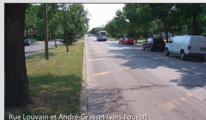
k) Marquage au sol
