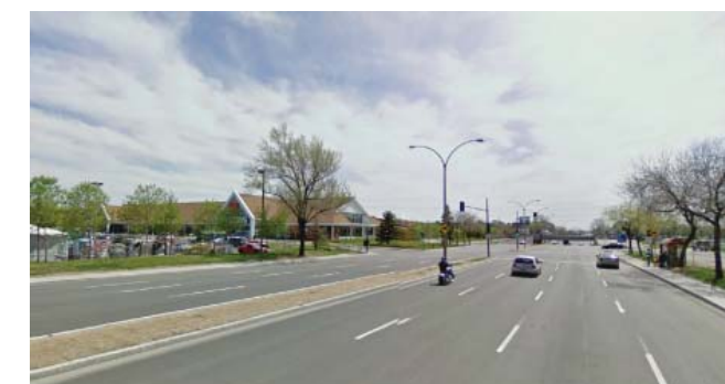
Vue du boulevard Henri-Bourassa, direction ouest, marché d'alimentation (Source : Google Street View, 2011)
