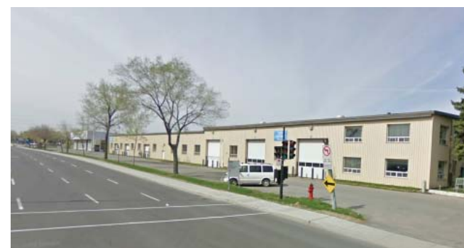
Vue du boulevard Henri-Bourassa, direction ouest, bâtiments SAAQ existants (Source : Google Street View, 2011)
