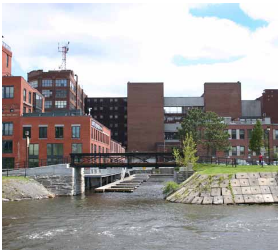
PHOTO DES CONDITIONS EXISTANTES DU CANAL
