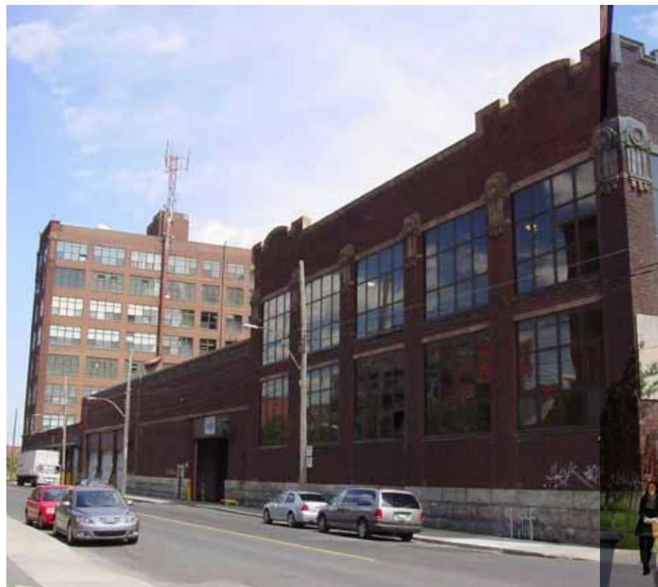
PHOTO DES CONDITIONS EXISTANTES RUE ST PATRICK
