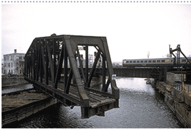
Pont du CN lors de sa mise hors service
