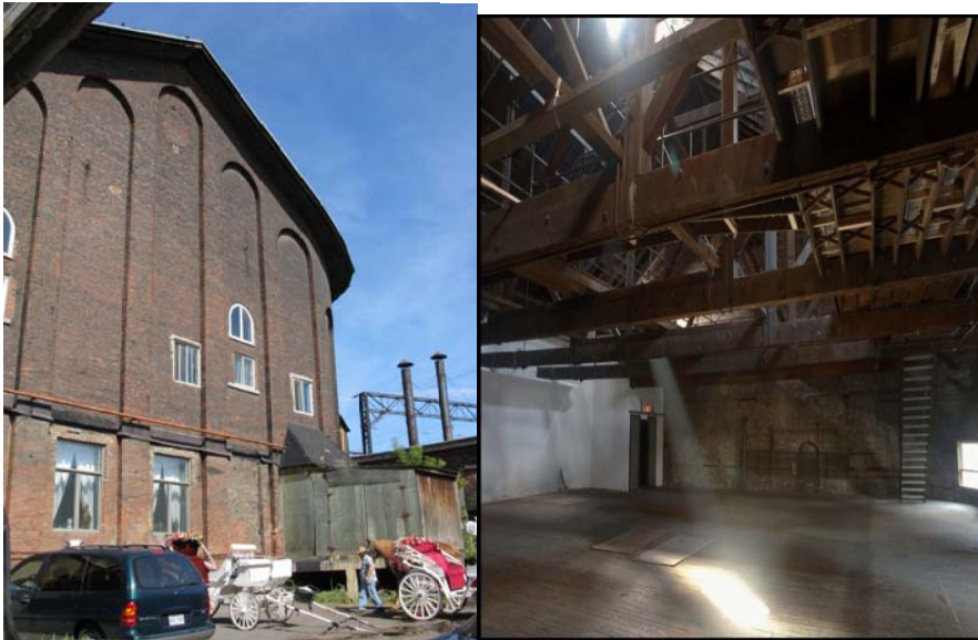
New City Gas, Gazomètre – 141 Ann - ben soo, photographe Interior
