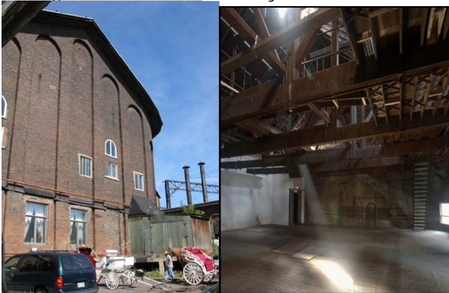
New City Gas, Gazomètre – 141 Ann - ben soo, photographe Interior
