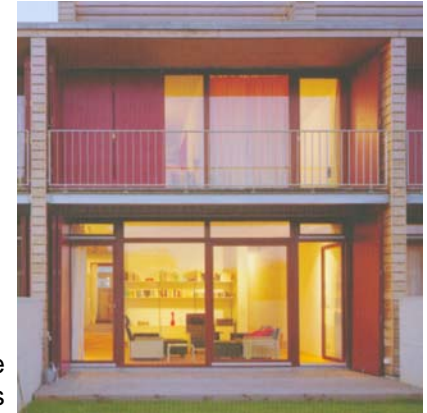
Darmstadt-Kranichstein, Allemagne Zimmermann Leber Feilberg, Architectes
