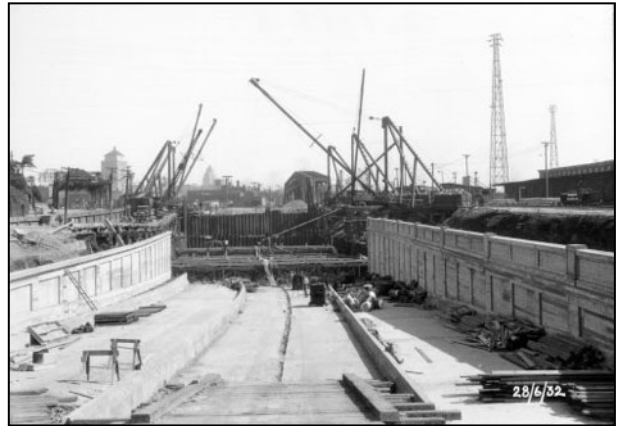
Construction du tunnel Wellington (entrée sud), 28 juin 1932. Photo : Archives de la Ville de Montréal, Z1497-8 [1].
