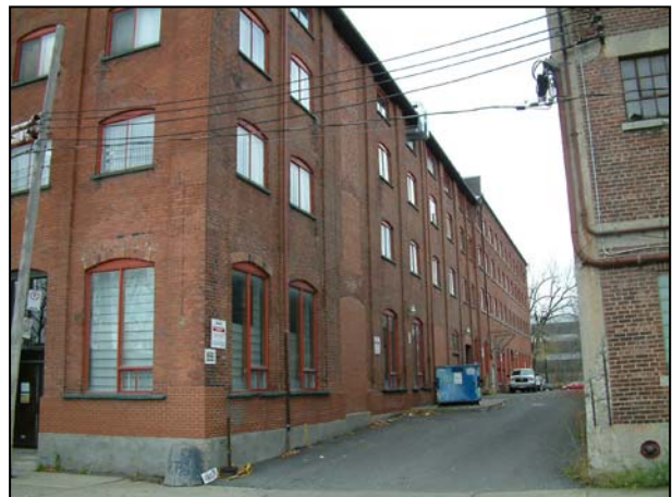
Façade latérale est. 2006.
