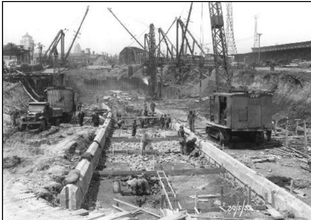
Construction du tunnel Wellington (entrée sud), 30 mai 1932. Photo : Archives de la Ville de Montréal, Z1497-14 [1].
