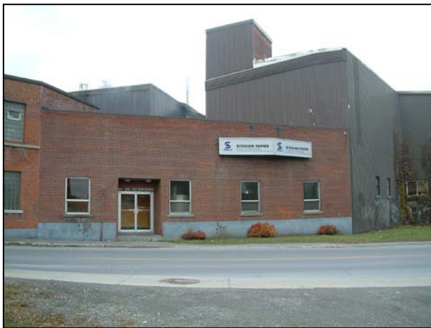
Le 50, rue des Seigneurs. Partie récente. 2006.
