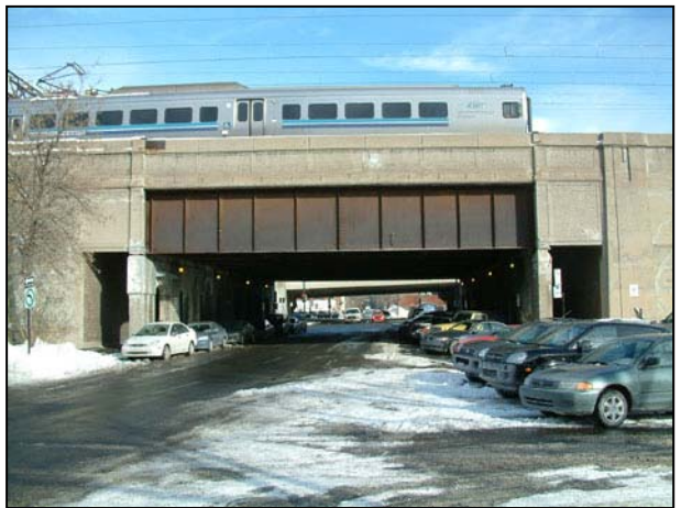
Viaduc du CN. La structure n'obstrue le passage d'aucune rue transversale. 2007.
