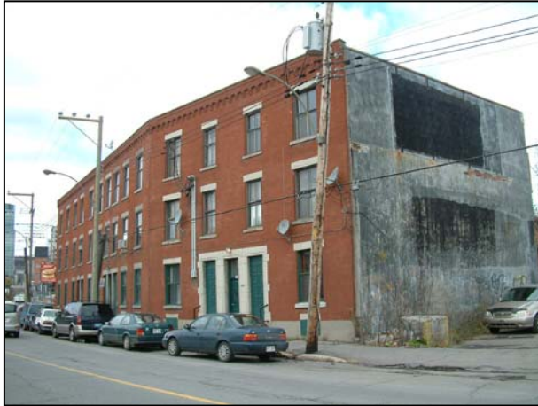
L'ensemble du 375-399, rue de la Montagne. 2006.
