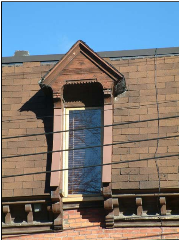
Détail d'une lucarne et de la corniche en bois ouvragé. 2006.
