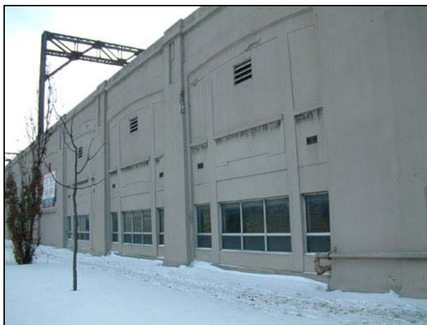
Viaduc du CN. Le mur a été recrépi du côté est. 2007.
