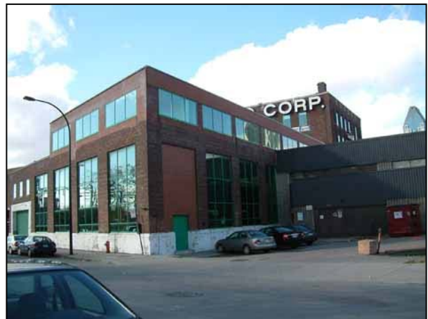
La façade sur la rue Brennan et l'agrandissement à droite. 2006.
