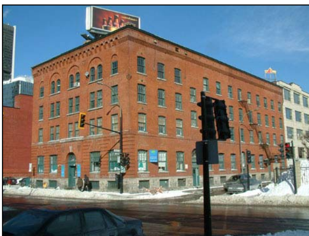
Immeuble qui lui fait face sur la rue Duke. 2007.
