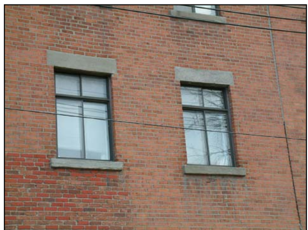
Détail de fenêtres avec linteaux et appuis en pierre. 2006.
