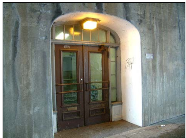
Viaduc du CN. Entrée sur la rue Notre-Dame Ouest. 2007.
