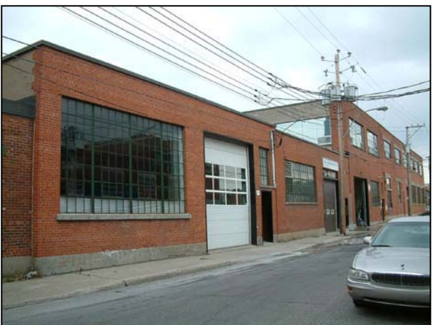
Façade de la rue Young. 2006.
