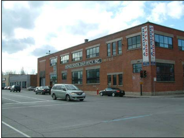
Façade de la rue Wellington. 2006.
