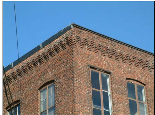
Détail de l'ornementation de brique au sommet de l'édifice. 2006.
