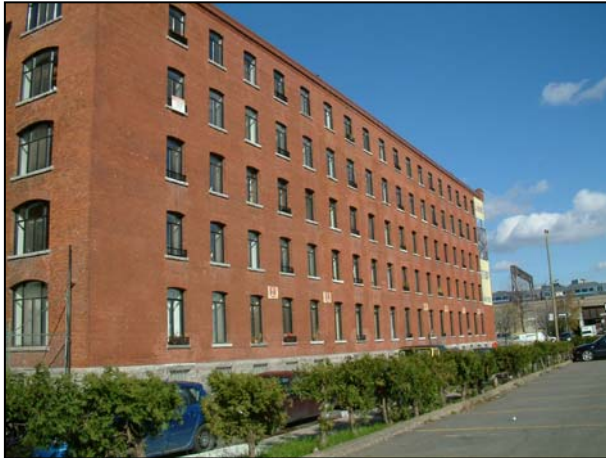
La façade de l'édifice longeant la rue William, 2006.
