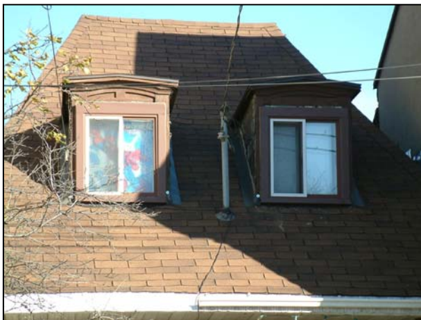
Détail de la toiture et des lucarnes. 2006.
