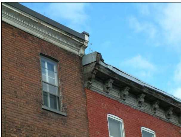
Détail des corniches du 1465-1467 et 1459-1461, rue Barré. 2006.
