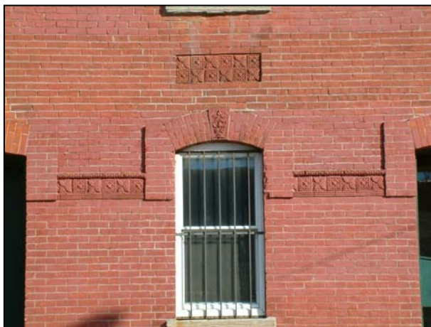
Détail d'une fenêtre cintrée et des éléments décoratifs en brique et en terre cuite du 287, rue Eleanor, 2006.
