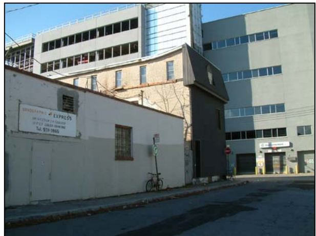
Façade de la rue Young où l'on perçoit la façade arrière en brique.
