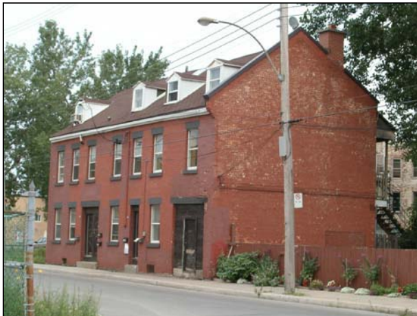
Le 1200-1206, rue Ottawa en 2004, avant les travaux de rénovation.
