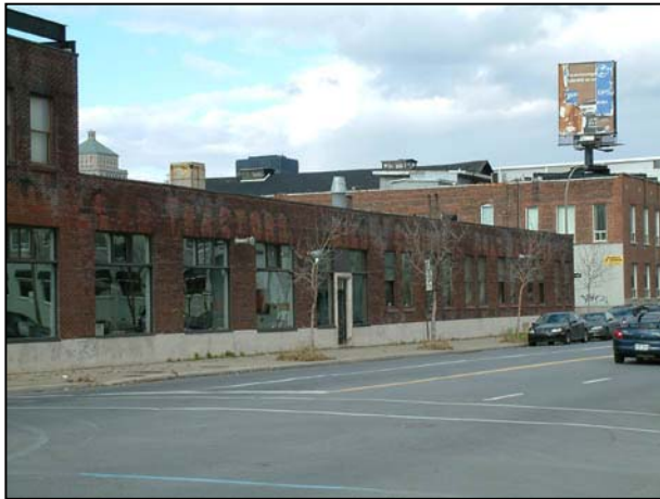
Façade de la rue Wellington. 2006
