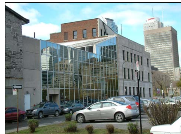
Le bâtiment et son annexe vus de la rue Montford. 2006.
