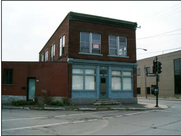
Le 248, rue de la Montagne en 2004, avant sa rénovation.
