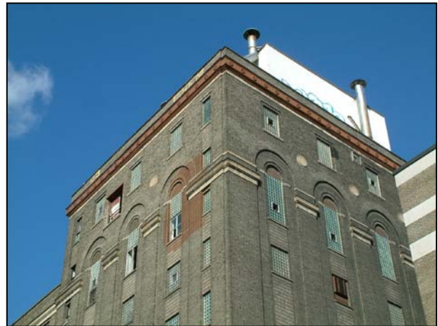
L'architecture de l'édifice de 1924-1925. 2006.
