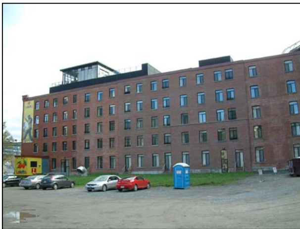
La façade donnant du côté nord. Des annexes occupaient autrefois la cour. 2006.
