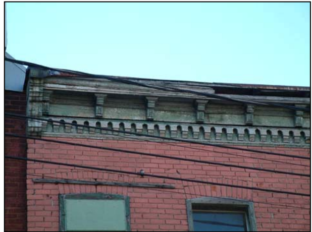
Détail de la corniche ouvragée en bois du 318-322, rue Murray, 2006.
