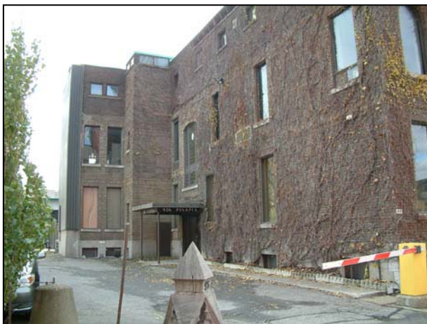
Façade latérale est. 2006.
