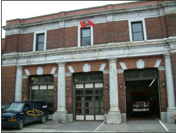
Façade principale du poste d'incendie. 2006.
