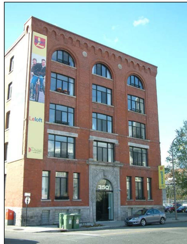
La façade actuelle sur la rue de l'Inspecteur. 2006.
