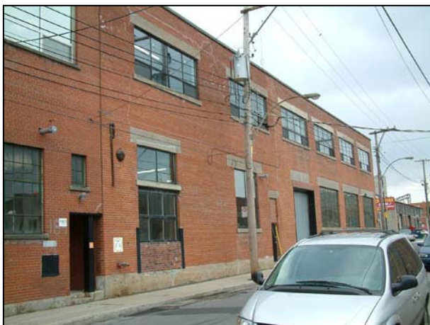
Façade de la rue Young. 2006.
