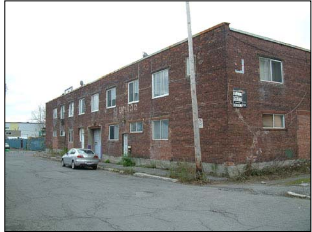
Façade de la rue Chatham. 2006.
