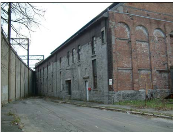
Mur en pierre du côté de la rue Dalhousie qui était autrefois la façade principale. Le viaduc du chemin de fer côtoie ce bâtiment. 2006.
