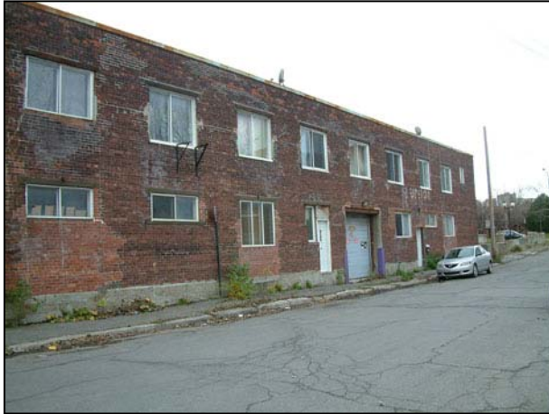
Façade de la rue Chatham. 2006.
