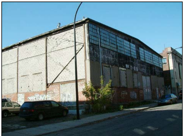
Façade de la rue Richmond (420) du 433, rue Saint-Martin. 2006.
