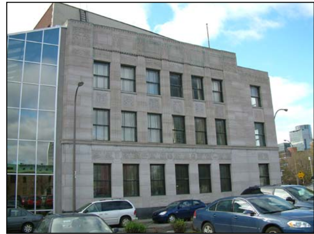
La façade latérale est donnant sur la rue Montford. 2006.
