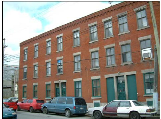
L'ensemble du 375-399, rue de la Montagne. 2006.
