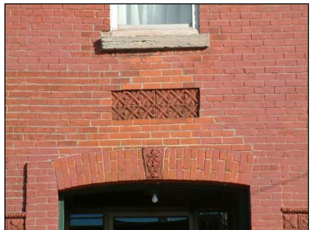
Détail d'éléments décoratifs en brique et en terre cuite du 287, rue Eleanor, 2006.
