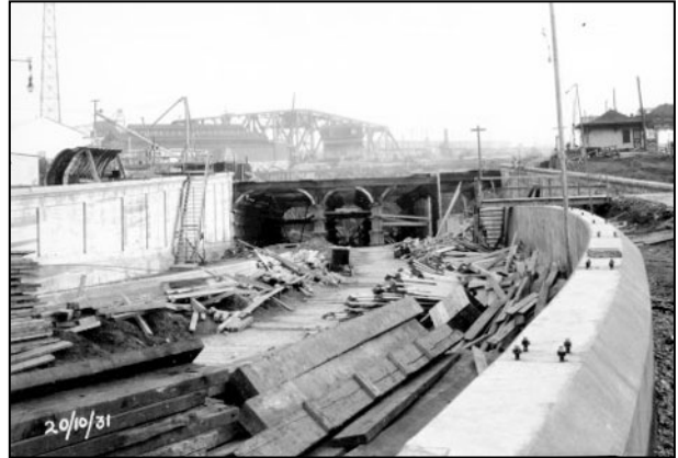
Construction du tunnel Wellington (entrée nord), 20 octobre 1931. Photo : Archives de la Ville de Montréal, Z1497-25 [1].
