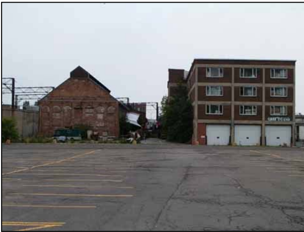
Complexe vu de la rue Ottawa. À droite, le bâtiment de la rue Dalhousie. 2006.
