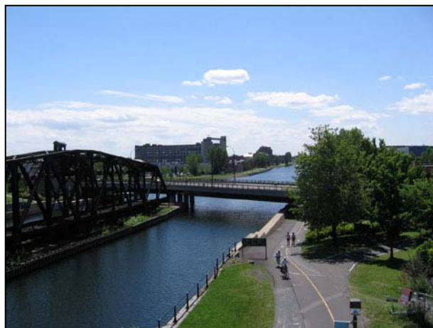
Vue vers l'ouest à partir du poste de contrôle. Photo : Stéphane Conant, 2005.
