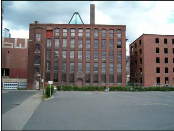
Le bâtiment tel qu'il se présentait en 2004, avant les travaux de recyclage et le remplacement des fenêtres.
