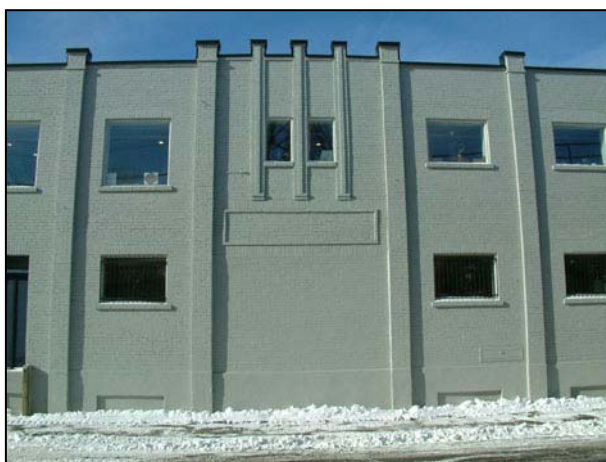
Façade de la rue Smith. L'entrée au centre a été murée. 2007.
