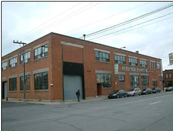
Façade de la rue Wellington. 2006.
