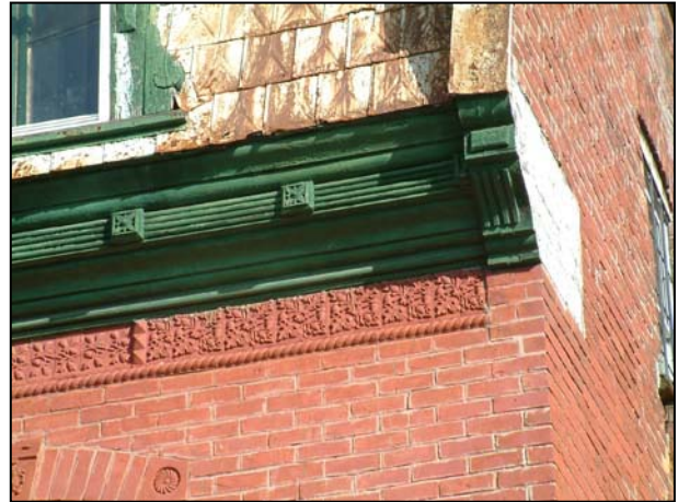
Détail de la corniche et d'un corbeau du 287, rue Eleanor, 2006.
