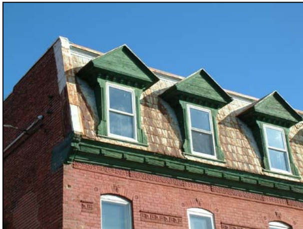
Détail de la fausse mansarde et des lucarnes du 287, rue Eleanor, 2006.
