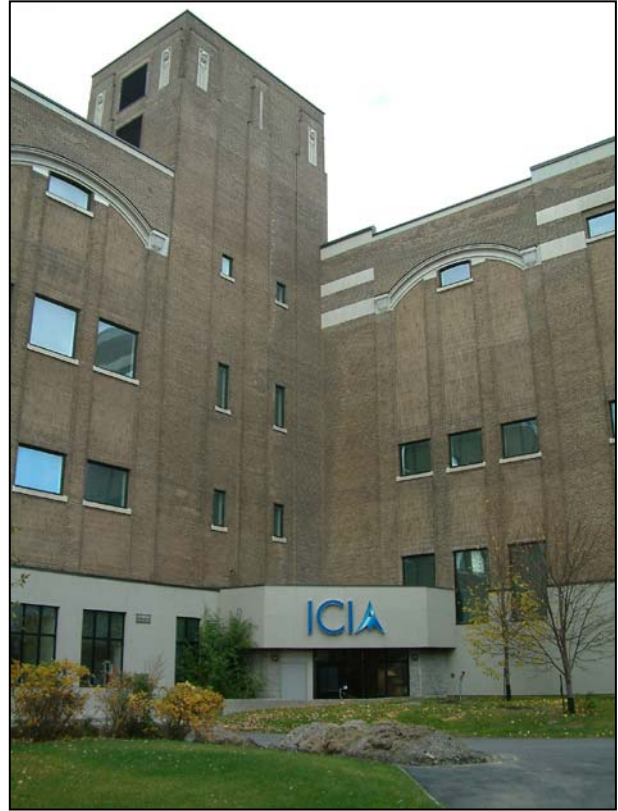
Entrée principale du bâtiment. 2006.
