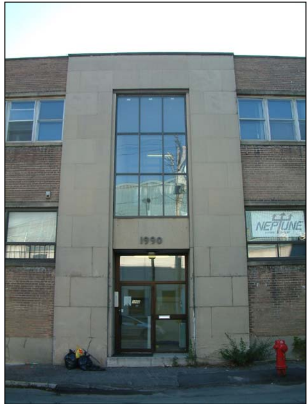
Travée centrale du 1990, rue William. 2006.
