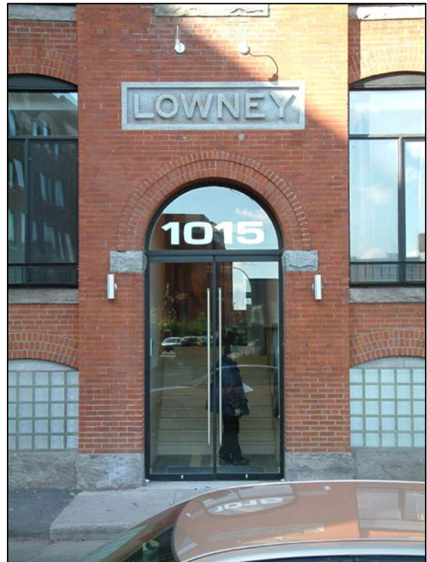
Détail de l'entrée du bâtiment. 2006.
