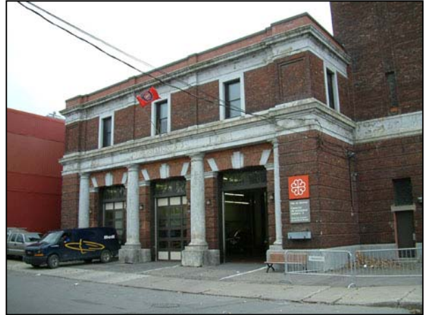
Façade principale du poste d'incendie. 2006.
