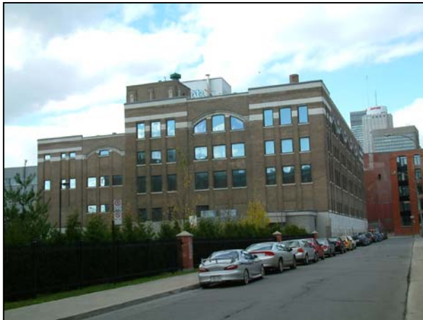
Façade sud, vue à partir de la rue de Shannon. 2006.
