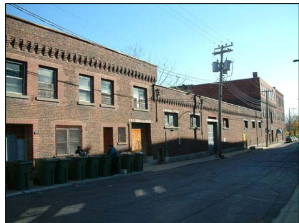
Façade de la rue Richmond. 2006.
