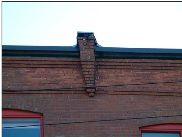
Détail de la corniche en brique sur la rue William. 2006.
