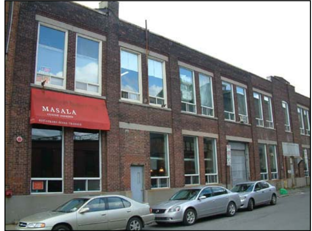
Façade de la rue Ann. 2006.
