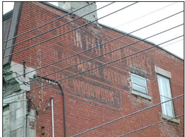
Inscriptions commerciales peintes sur la façade latérale sud. 2006.
