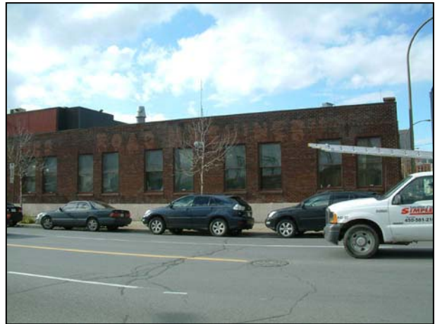
Façade de la rue Wellington. 2006
