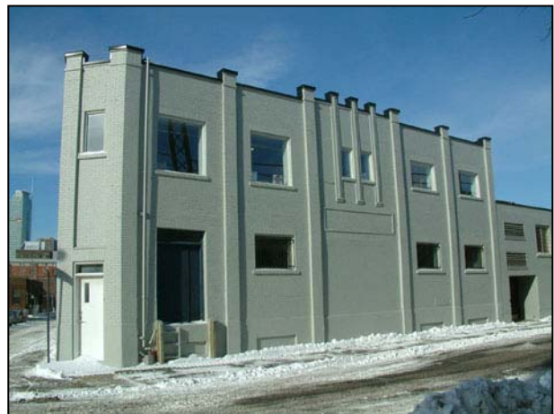
Façade de la rue Smith. Les pilastres et les amortissements ont été conservés. 2007.
