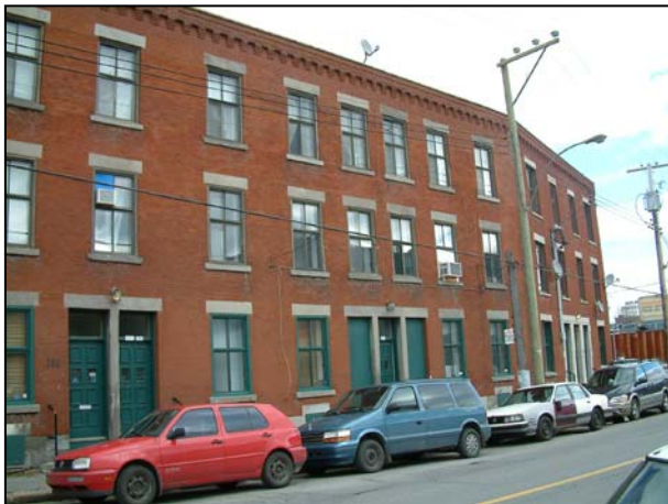
L'ensemble du 375-399, rue de la Montagne. 2006.
