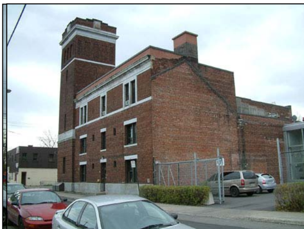
Façade arrière vue de la rue Young. L'empreinte d'un ancien bâtiment sur le mur démontre une ancienne mitoyenneté. 2006.
