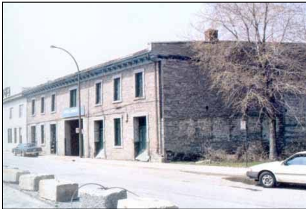
En 1991, la partie sud du bâtiment était toujours debout. Photo : Blouin et Associés.
