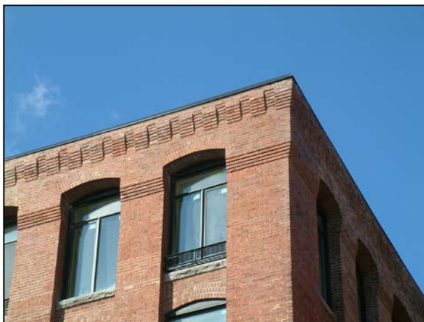
Détail de la corniche en brique au sommet du bâtiment. 2006.
