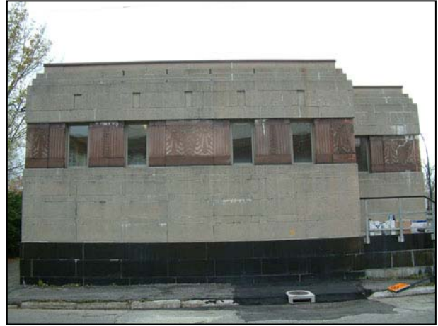
La façade latérale est donnant sur la rue Murray. 2006.
