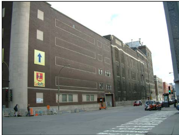
Les différentes parties du complexe, rue Peel. En avant-plan, l'entrepôt de maturation de 1954. 2006.
