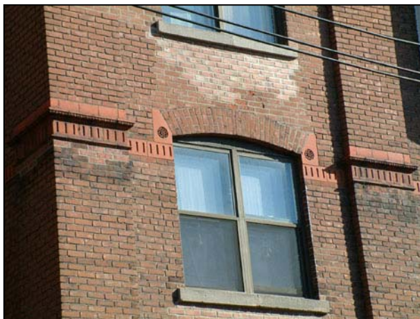
Détail d'une fenêtre cintrée et du bandeau décoratif en terre cuite. 2006.
