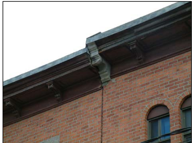
Détail de la corniche en bois ouvragé qui couronne l'ensemble de la façade. 2006.
