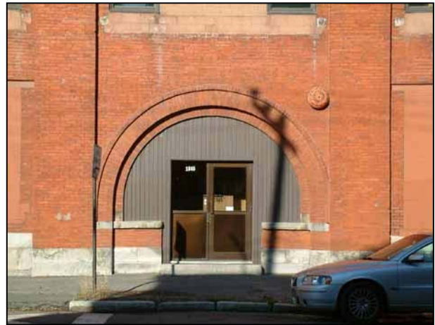
Arche de l'entrée principale avec les impostes et baies latérales condamnées. 2006.
