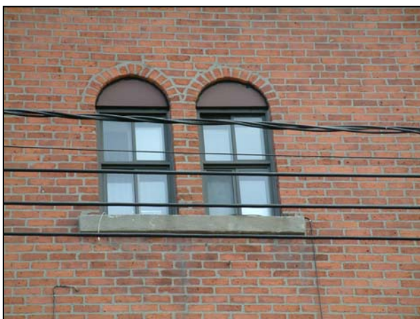
Détail des petites fenêtres cintrées dont les impostes ont été bouchées. 2006.
