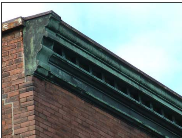
Détail de la corniche en cuivre. 2006.
