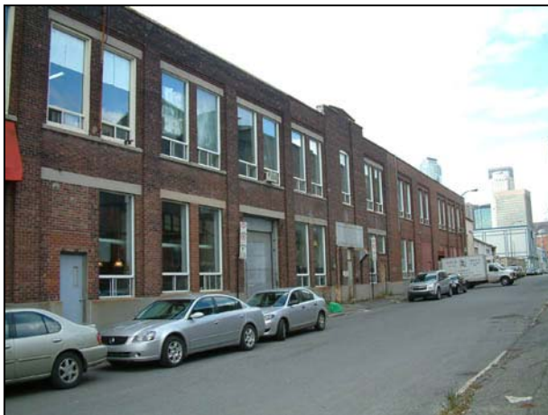
Façade de la rue Ann. 2006.
