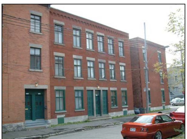
Le 1288-1290, rue Barré qui fait également partie de cet ensemble. 2006.
