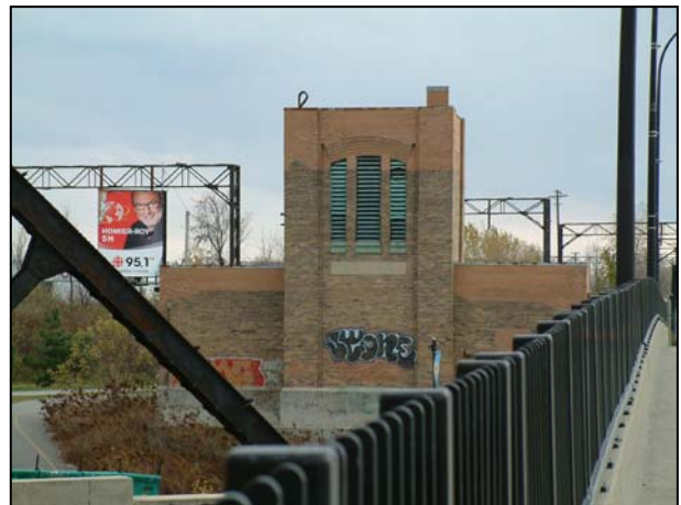
L'autre édicule identique, du côté sud du canal, à Pointe-Saint-Charles. 2006.
