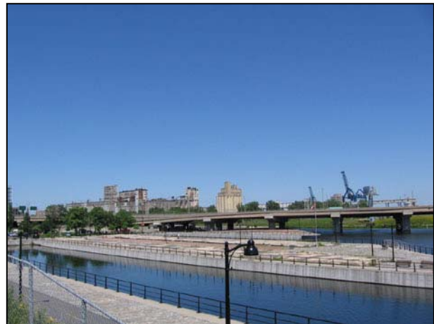
Vue vers l'est à partir du poste de contrôle. Photo : Stéphane Conant, 2005.
