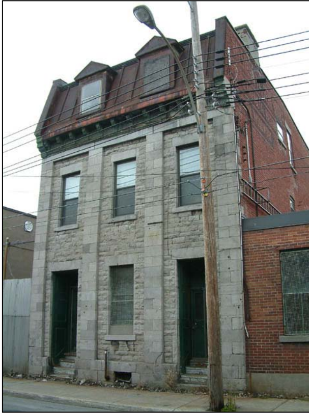
Façade de la rue Young. 2006.
