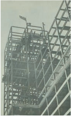
L'hôpital en construction
