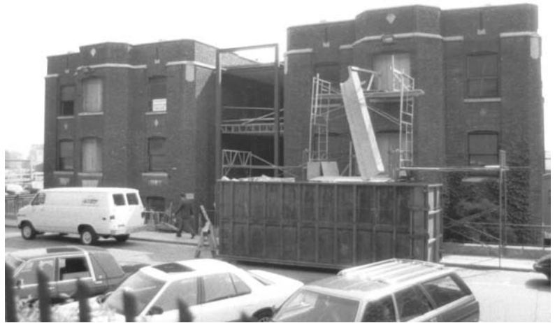
Travaux de construction visant à remplir la cour avant, en 1987-88
