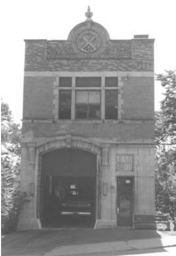
Le poste d'incendie n° 28
