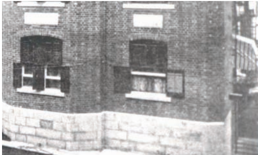
Photo d'origine des fenêtres avec volets
