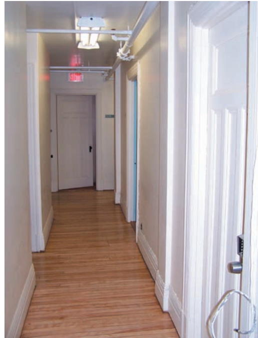
Finition assez intacte au sous-sol
