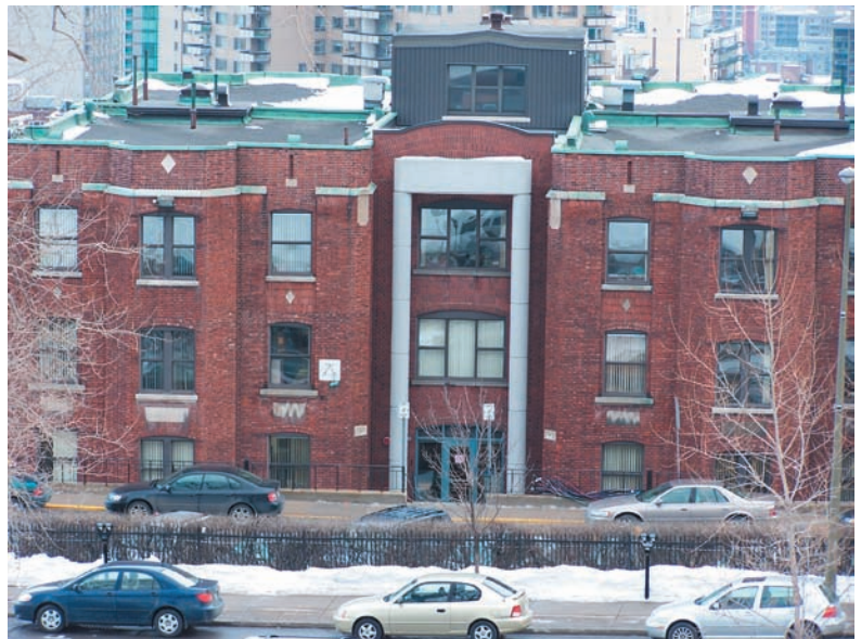
Vue frontale du Travancore
