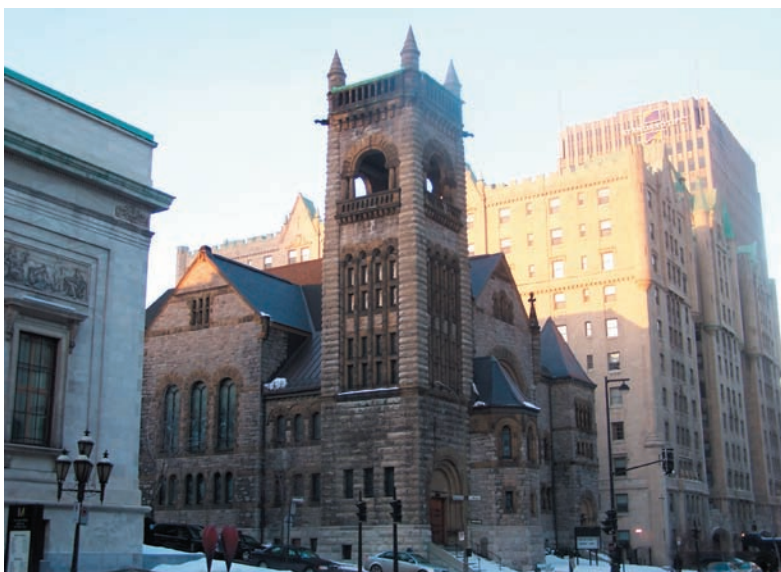
Erskine & American, oeuvre de A.C. Hutchison, 1894
