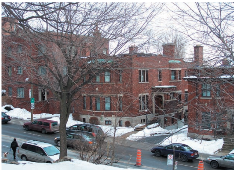
Maison sise sur l'avenue Cedar, à l'ouest de l'hôpital
