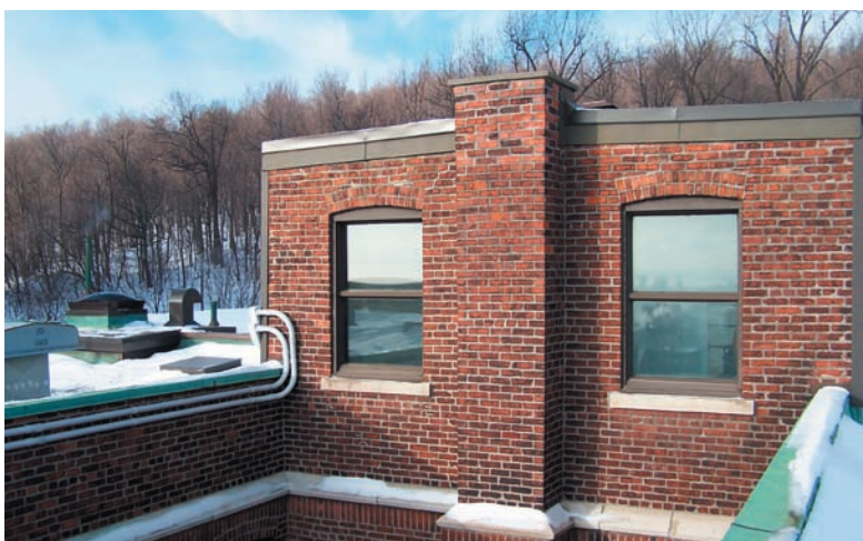
Édicule d'accès au toit
