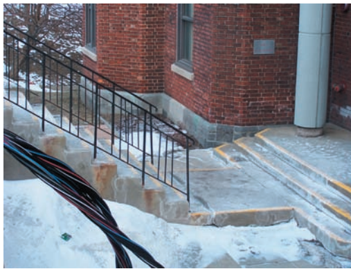
L'entrée du Travancore
