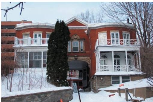
Maisons sises au 1559-69, avenue des Pins ouest
