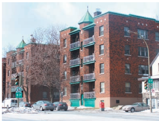
Les appartements Alta Vista, chemin de la Côte-des-Neiges
