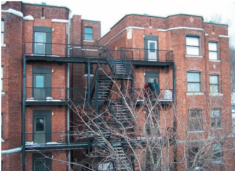
Fenêtres et portes arrière
