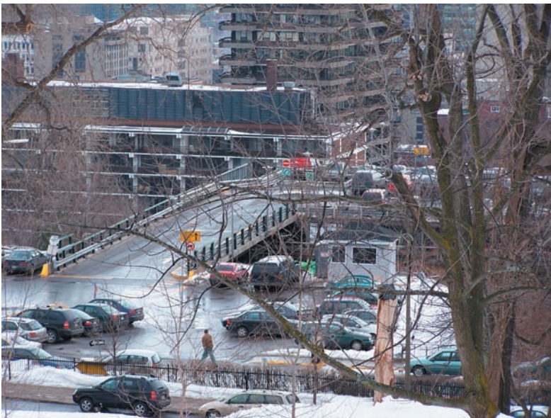
La voie d'accès au stationnement étagé
