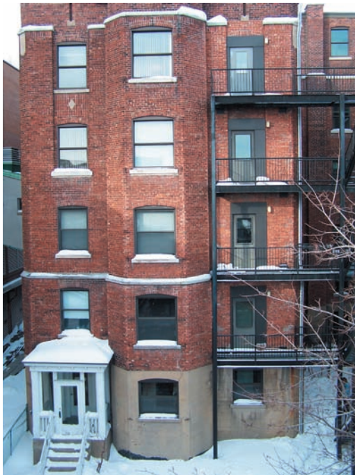
Façade arrière de l'immeuble
