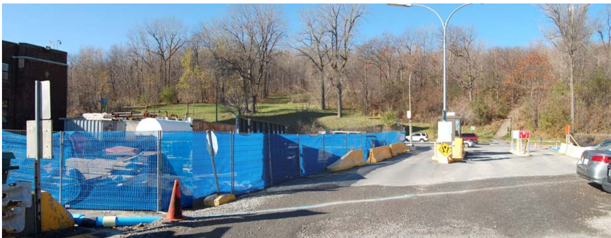
Figure 1. Vue vers la clairière et l'escalier du parc du Mont-Royal à partir du stationnement de l'hôpital. Source : CPM, 12 novembre 2010.
