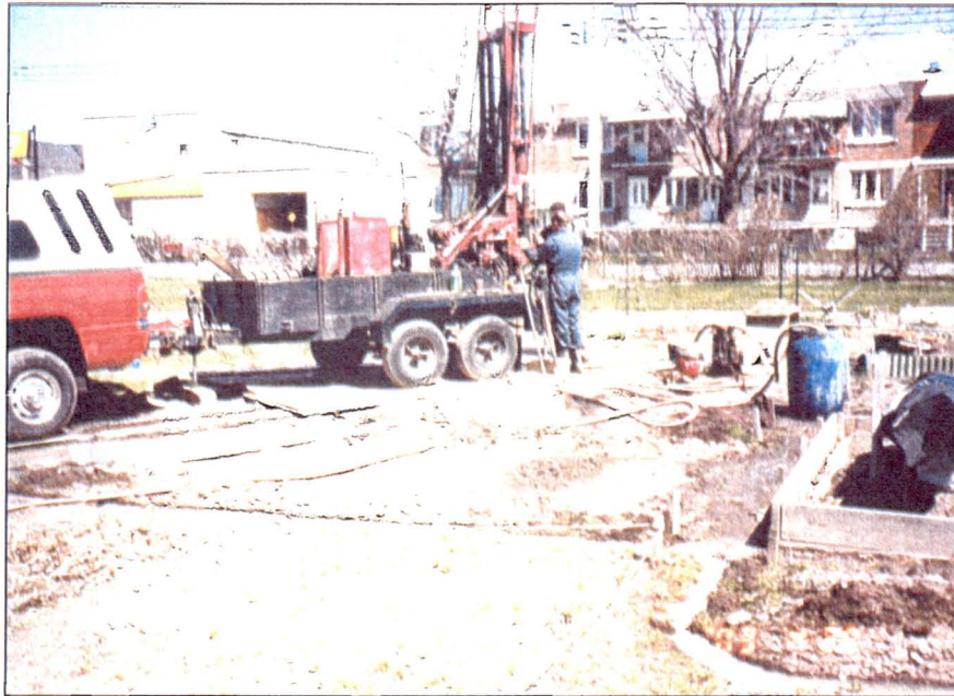
Photo 7 : Vue est de l'emplacement du forage 02F144-3.
