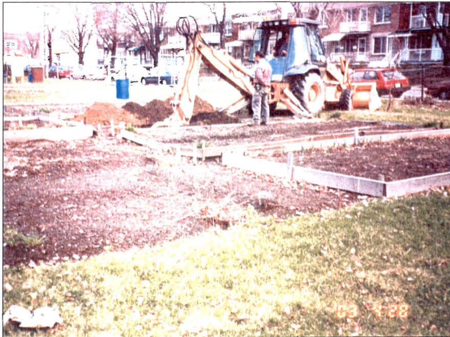
Photo 2 : Vue nord-est des travaux d'excavation du puits d'exploration 02F144-6. On observe des tas de matériaux excavés qui consistent en des sols organiques et du sable silteux.
