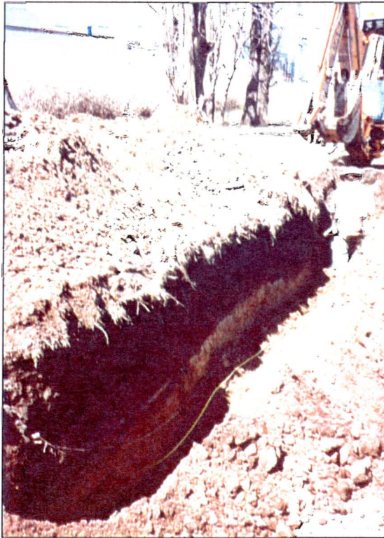
Photo 9 : Vue nord du puits d'exploration 02F144-26.
