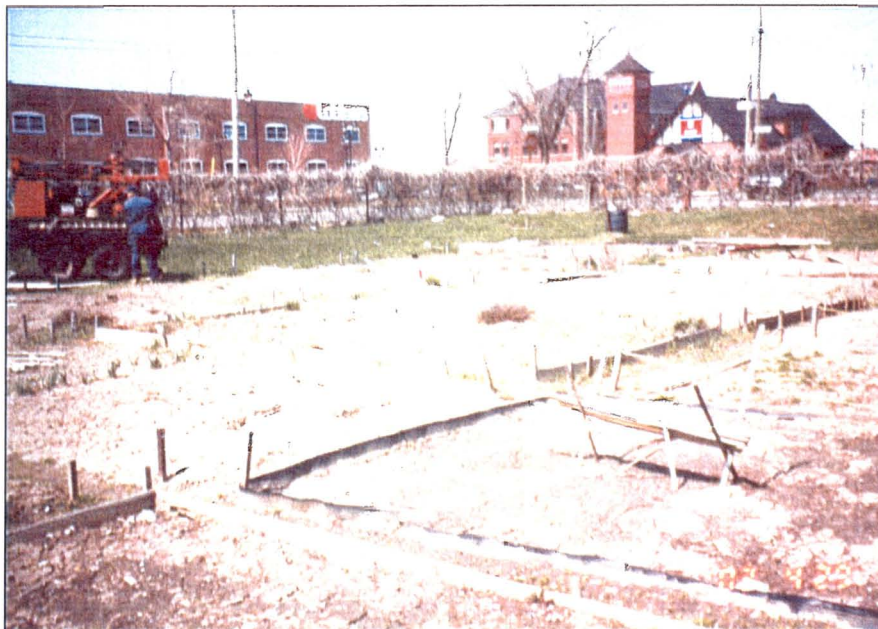
Photo 4 : Vue nord-est de l'emplacement du forage 02F144-1.
