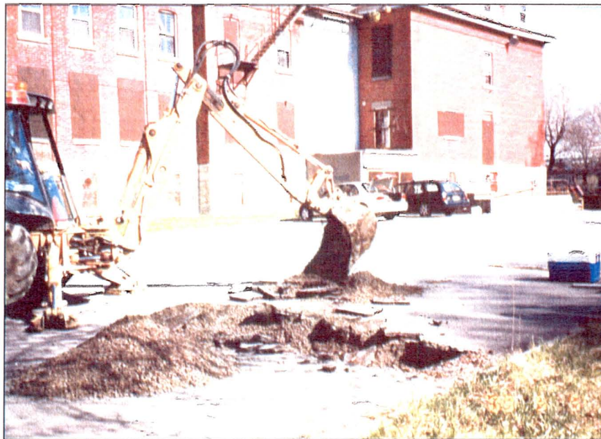
Photo 8 : Vue nord-est des travaux d'excavation du puits d'exploration 02F144-25.
