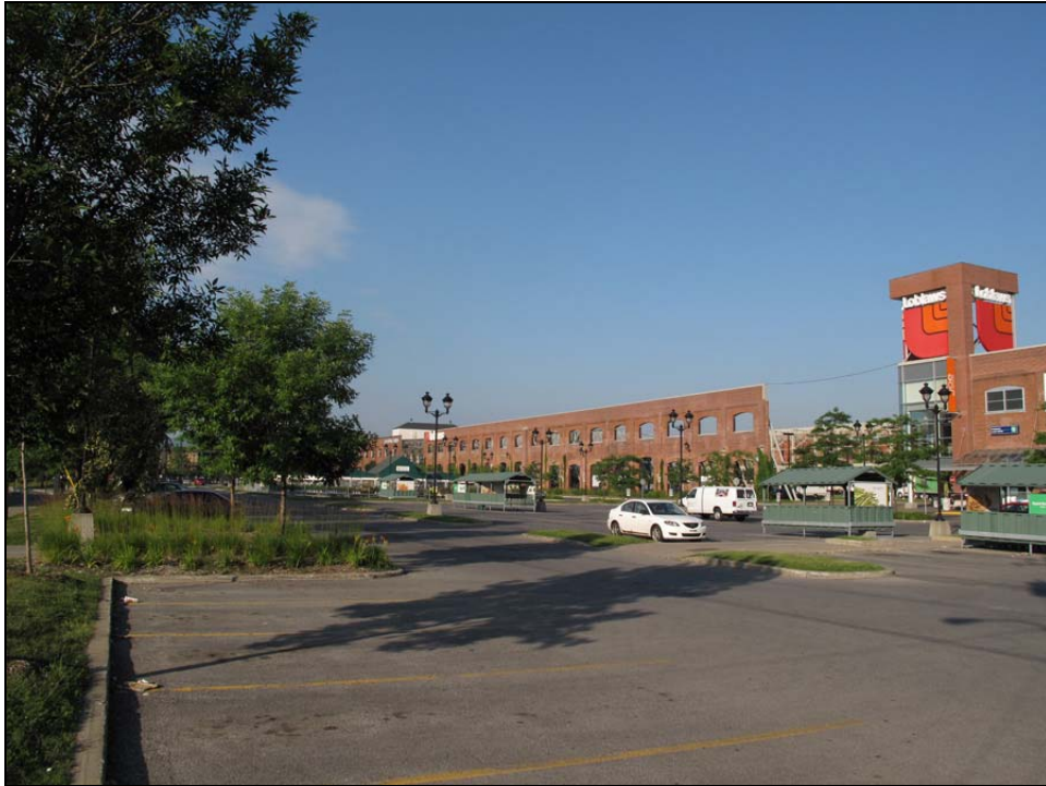
Photo 1 – Espaces commerciaux et stationnement extérieur à l’ouest du site
