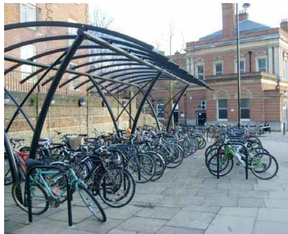
PHOTO 43 Aire de stationnement pour vélo couverte
