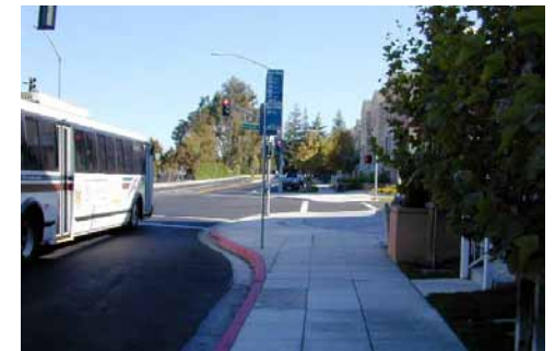
PHOTO 35 Avancée de trottoir à un arrêt d'autobus
