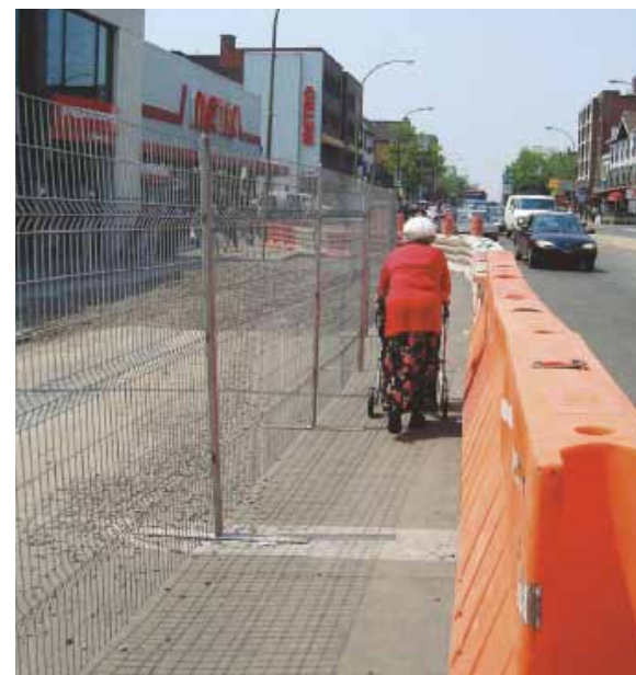
PHOTO 40 Passage piétonnier sécurisé à proximité d'un chantier de construction, Montréal
