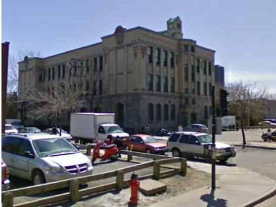
PHOTO 7 Centre Gédéon-Ouimet, vue de l'intersection de la rue Poupart et la rue Ontario.
