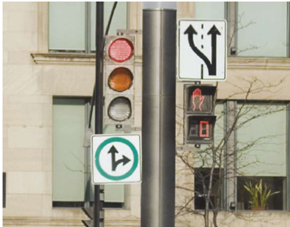
PHOTO 30 Feux piétons à décompte numérique.
