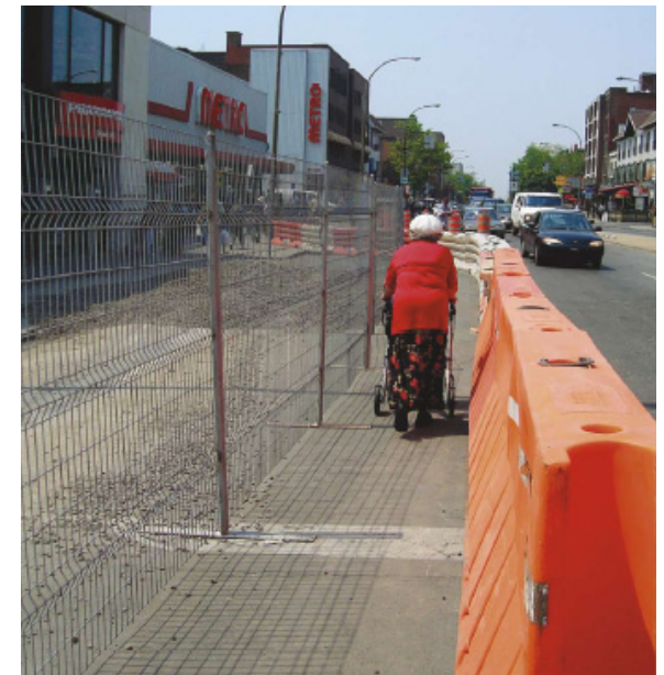
PHOTO 40 Passage piétonnier sécurisé à proximité d'un chantier de construction, Montréal
