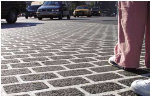
PHOTO 32-33 Marquage au sol jaune et encastré dans la chaussée
