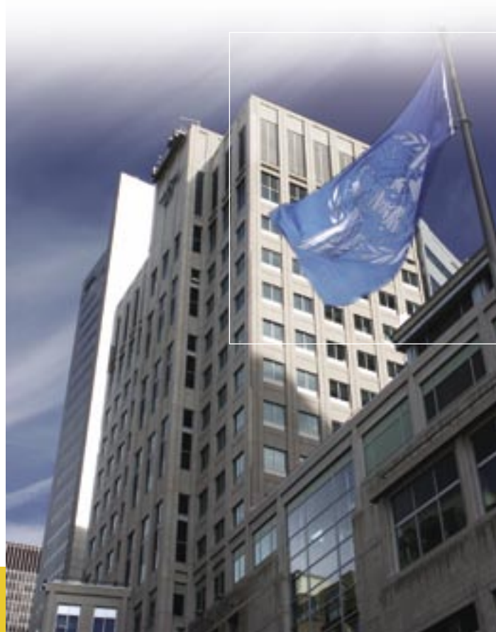
Siège social de l'Organisation de l'aviation civile internationale (OACI) Source : Service de mise en valeur du territoire et du patrimoine
