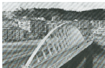
Pont Alameda par Santiago Calatrava, Valence, Espagne. Source : Frampton, K et Al, 1996.
