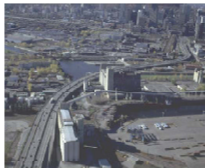
2000, Silos à grains. Source : Ministère des Transports du Québec
