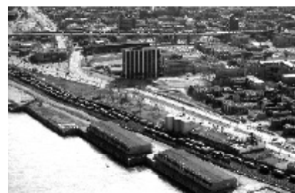
2000, Rampe du pont Jacques-Cartier au dessus du boulevard René-Lévesque et de la rue Notre-Dame. Source: Ministère des Transports du Québec
