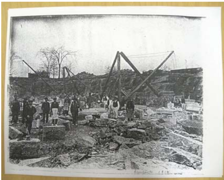
Extraction et taille de la pierre dans la carrière sur le site de l'Institution des Sourds-Muets, sans date. (Archives des Clercs de Saint-Viateur)
