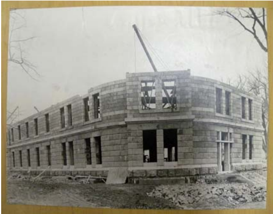
Construction du deuxième étage, corps principal, sans date. (Archives des Clercs de Saint-Viateur)
