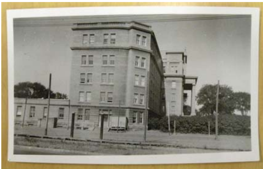
Côté sud du corps principal, sans date. (Archives des Clercs de Saint-Viateur)
