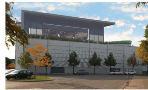
VUE DE L'AGRANDISSEMENT À PARTIR DE LA RUE FAILLON
