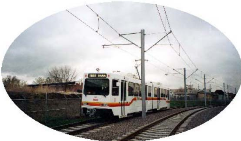
FIGURE 19 - Exemple de caténaire centrale
