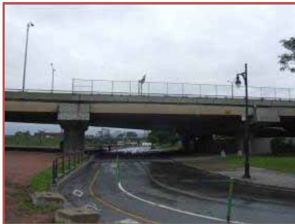
PHOTO 4.16 : RUE DE LA COMMUNE
