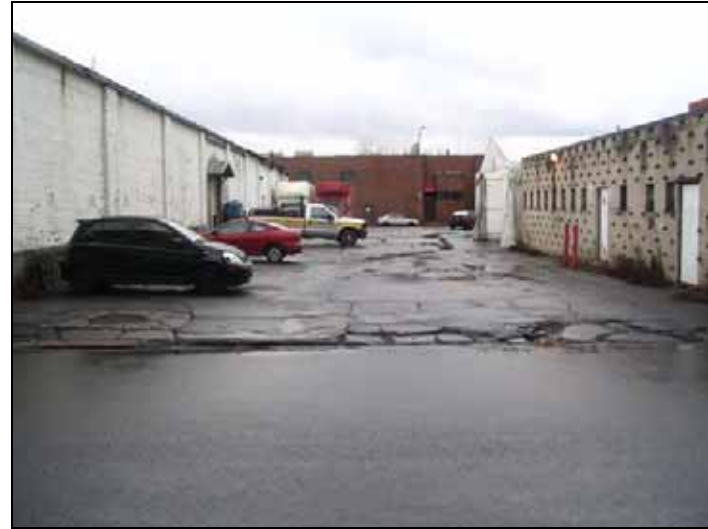
Cours de bâtiment entre Ottawa et Wellington – Vue ouest
