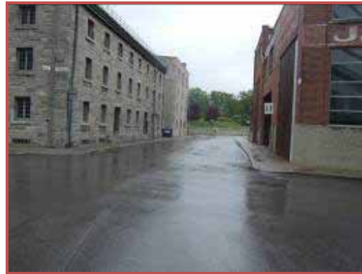
PHOTO 4.6 : RUE DUKE AU SUD DE LA RUE BRENNAN
