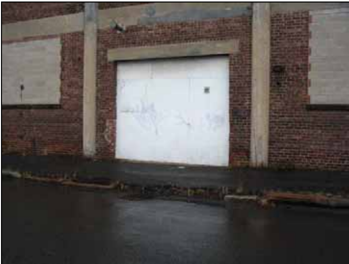
Entrée de bâtiment entre Ottawa et Wellington – Vue est
