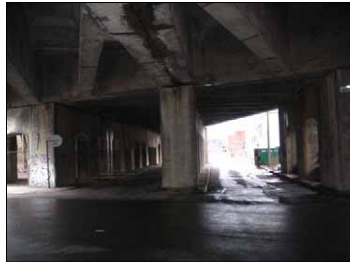
Vue ouest sous le viaduc ferroviaire CN, entre Wellington et Brennan
