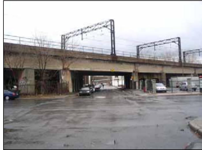
Rue Ann, entre Ottawa et Wellington (extrémité sud) – Vue sud
