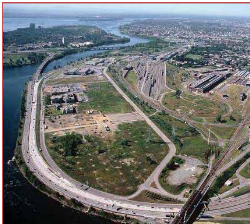
PHOTO 4.1 : AUTOROUTE BONAVENTURE ENTRE LES PONTS CHAMPLAIN ET VICTORIA
