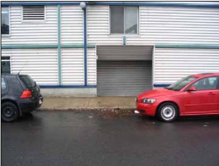
Entrée de bâtiment entre William et Ottawa (extrémité sud) – Vue ouest
