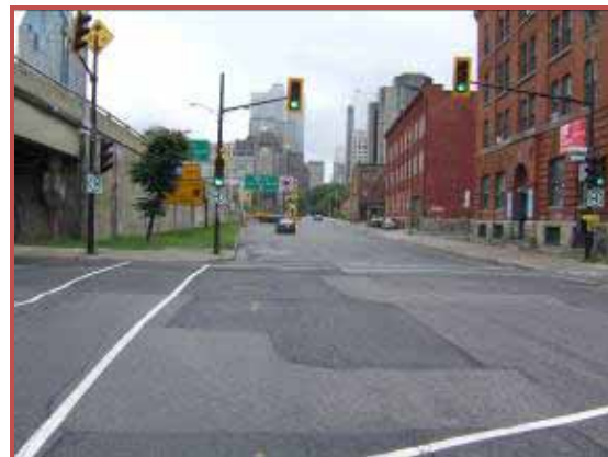
PHOTO 4.9 : RUE DUKE AU NORD DE LA RUE WILLIAM
