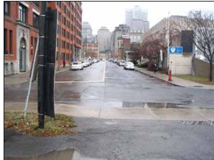
Rue de l'Inspecteur entre William et Saint-Paul – Vue nord
