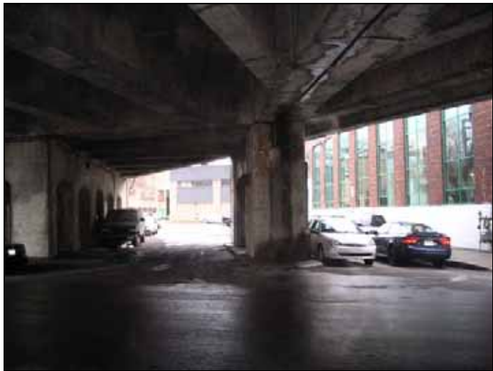
Vue est sous le viaduc ferroviaire CN, entre Wellington et Brennan
