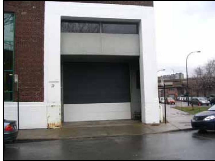
Entrée de bâtiment entre Wellington et Brennan – Vue est
