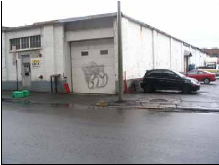
Entrée de bâtiment entre Ottawa et Wellington – Vue ouest
