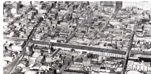
PHOTO AÉRIENNE MONTRANT LE VIADUC FERROVIAIRE DU CN EN CONSTRUCTION, VUE VERS L'EST AU COURS DES ANNÉES 1940, CANADIAN AIRWAYS LIMITED
