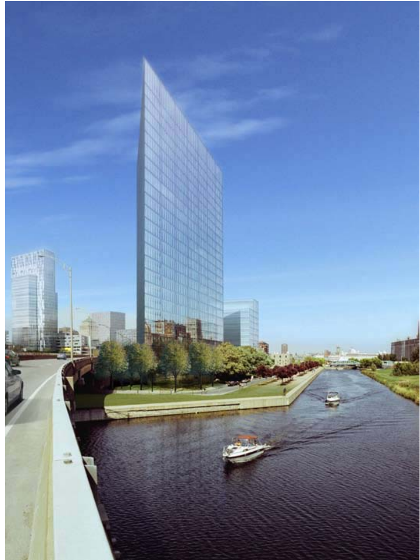
ÎLOT DE LA COMMUNE ATELIERS DE LA VOIRIE GCH, 2008
