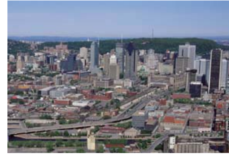
DE GAUCHE À DROITE VOIE FERRÉE AUX ABORDS DU BASSIN PEEEL, GCH, 2008 TRANSPORT ACTIF, PLAN DE TRANSPORT DE MONTREAL, 2008 PHOTO AÉRIENNE DU CENTRE-VILLE, SHM, 2005
