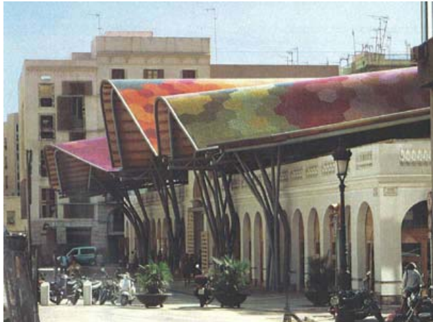
MARCHÉ DE SANTA CATARINA, BARCELONE, TECHNIQUES ET ARCHITECTURE AOUT / SEPTEMBRE, 2005, P. 84
