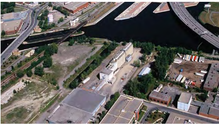
Le site remblayé des anciens bassins Tate et Wellington
