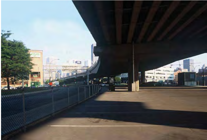
Vue vers le centre-ville, à l'intersection des rues Brennan et Nazareth, avant et après les travaux de réaménagement
