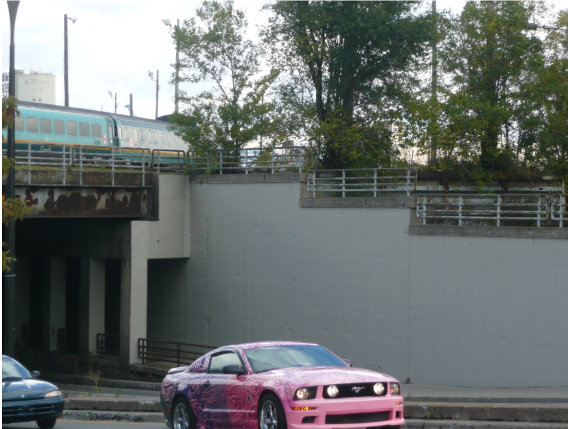
Un filtre à l'angle de la rue Wellington et de la voie ferrée
