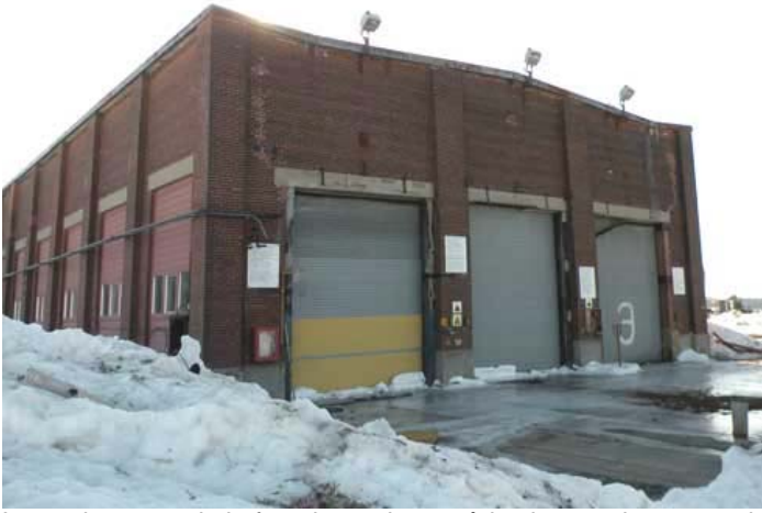
Les trois portes de la façade nord, par où les locomotives pouvaient entrer et sortir du bâtiment.
