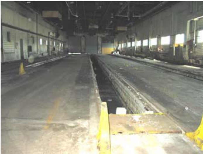
Des interventions semblent avoir modifié la configuration des puits de moteurs. Selon les plans consultés (voir en annexe le dessin AB 819-3.6-124.2), trois puits parallèles occupaient à l'origine toute la longueur du bâtiment. Les locomotives y entraient par les trois ouvertures visibles au fond.
