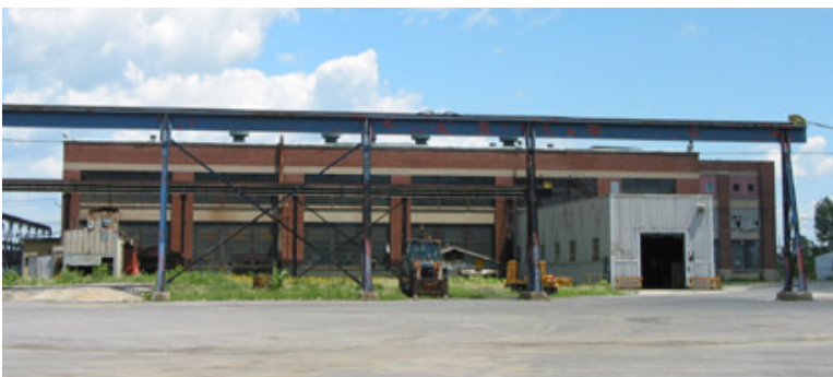
Façade ouest du « Wheel Shop » avec l'aire d'entreposage à droite.
