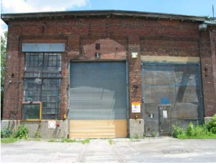
La façade ouest de la section la plus ancienne du bâtiment, qui était appelée l'atelier des châssis et des cylindres.
