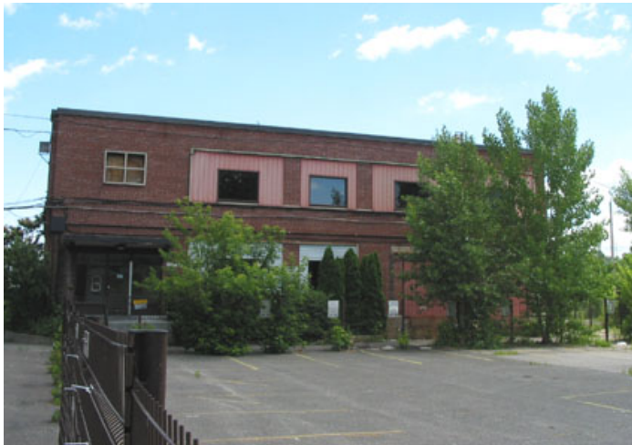
La façade ouest, sur laquelle on distingue que plusieurs ouvertures ont subi des modifications importantes, phénomène également observé en plusieurs autres endroits sur le bâtiment. Un ancien terrain de stationnement se trouve devant cette façade, donnant sur la rue Le Ber.
