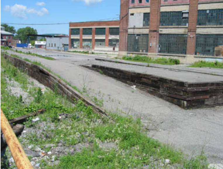
La façade sud de l'ensemble des structures formant le bâtiment D et le terrain la bordant, aménagé pour faciliter le camionnage.
