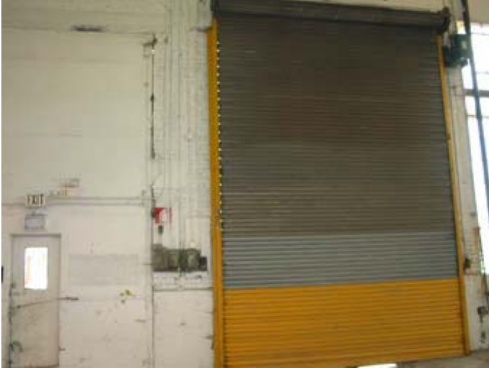
Vue de l'intérieur de la façade ouest de la première partie du bâtiment. Les portes ont été modifiées depuis la construction d'origine.
