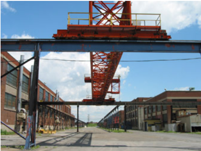
Le pont roulant extérieur se trouve entre l'atelier des locomotives et le bâtiment ayant abrité la fonderie, l'atelier des patrons et l'atelier des roues du côté sud (à droite) et, au nord, l'atelier des wagons (à gauche).
