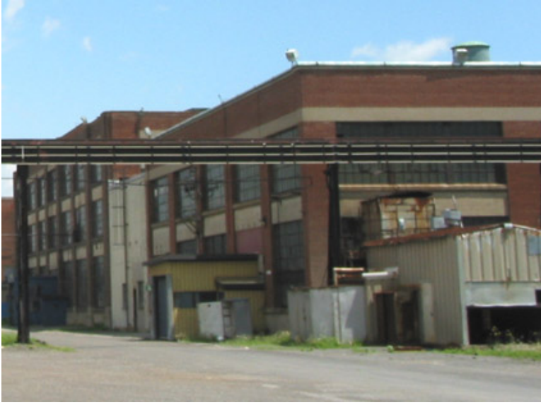
L'angle nord-ouest du bâtiment D laissant voir trois parties de quatre parties, de hauteur légèrement différente : à l'arrière, le « Foundry and Pattern Shop », à l'avant, le « Wheel Shop » et au centre, la partie de béton réunissant les deux précédentes. On aperçoit également de petits appentis métalliques adossés au bâtiment.
