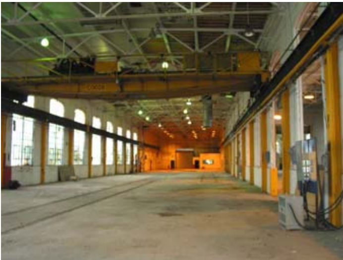
L'intérieur de la première partie du bâtiment. Le pont roulant appuyé aux murs est demeuré en place. On distingue la forme arquée du haut des fenêtres.
