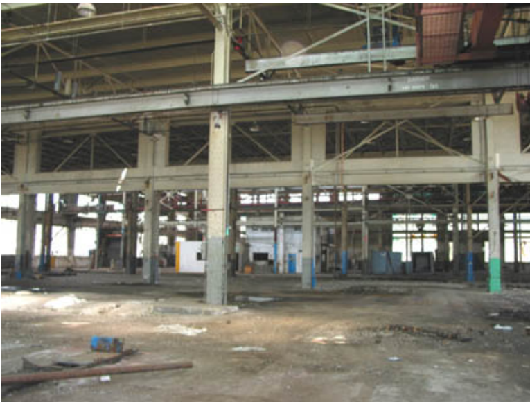
L'espace intérieur du bâtiment D, dénué de sa machinerie.
