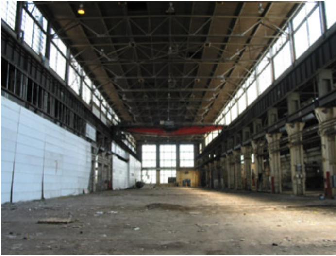
Des fenêtres en bandeaux permettent à la lumière naturelle de pénétrer à l'intérieur de la partie centrale des ateliers.
