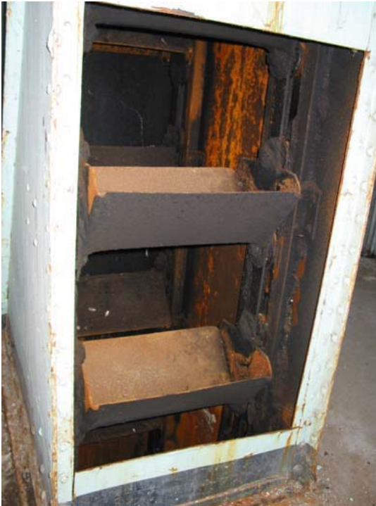
Convoyeur vertical servant à alimenter la bouilloire en charbon.
