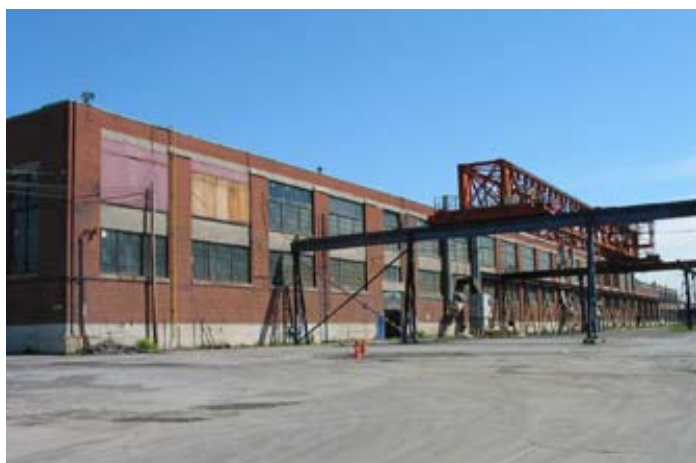
Le mur de la façade sud avant l'incendie, voisiné par le pont roulant extérieur se trouvant entre l'atelier des wagons et l'atelier des locomotives.
