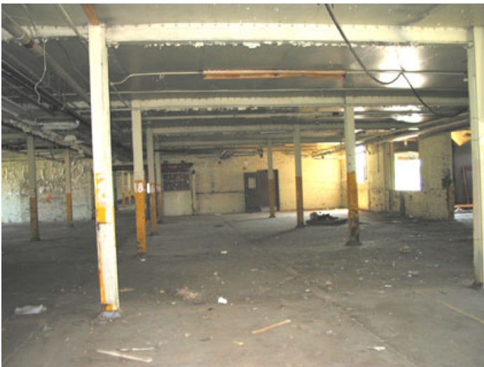
Vue intérieure des sections centrales des magasins, construites en 1924, sur laquelle on peut voir le plafond et le plancher en béton ainsi que la peinture écaillée sur les surfaces.
