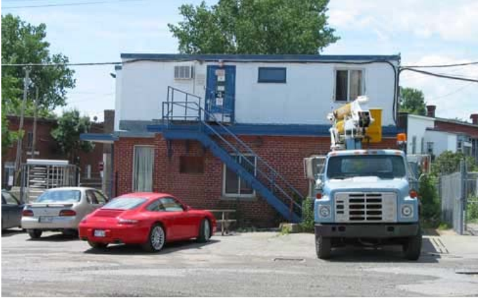
La façade est, donnant sur l'aire de circulation principale vers les différents bâtiments du site.
