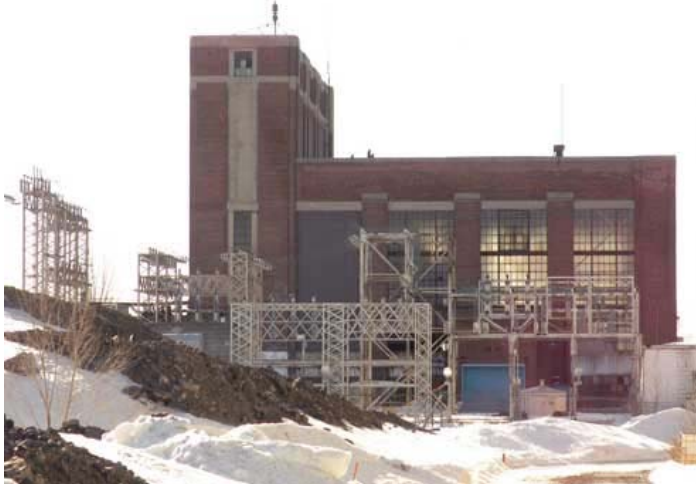
Les installations liées à la production d'électricité se trouvant derrière le bâtiment.
