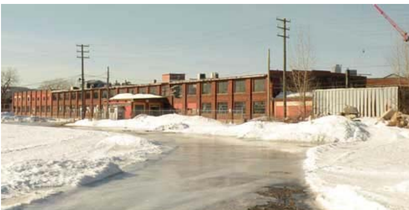
La façade sud des sections centrales des magasins.
