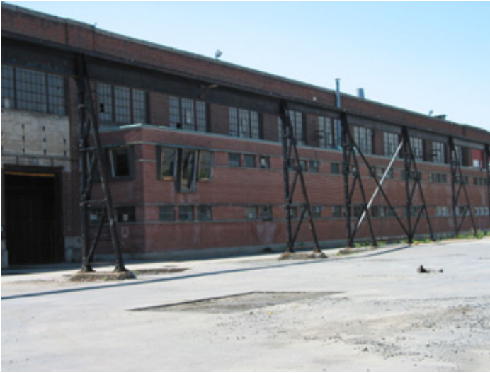
Une des sections latérales ajoutées vers 1943, celle-ci se trouvant sur la façade nord.
