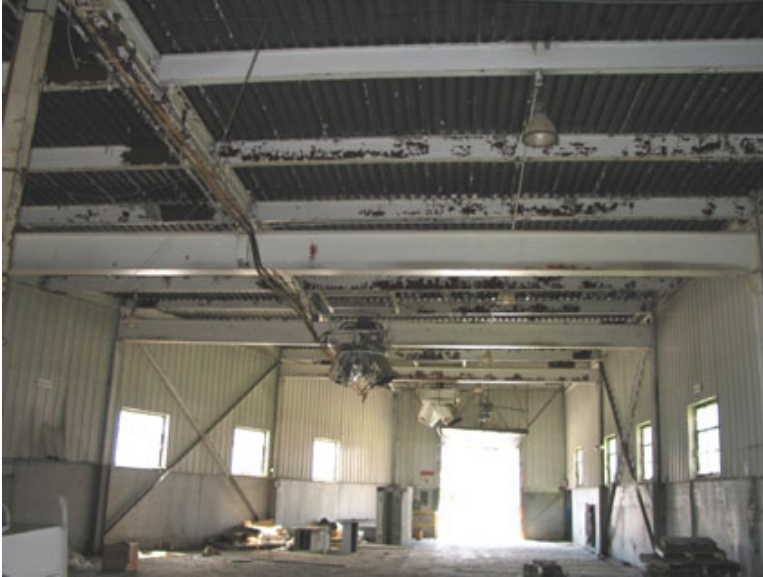
L'intérieur du hangar ayant servi d'aire d'entreposage.
