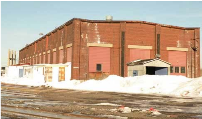
Cette photo de la façade sud, prise en février 2009, permet de constater que l'extrémité est du pont roulant a été démantelée. On aperçoit également les ouvertures murées de la façade latérale nord ainsi qu'une série d'appentis jouxtant la façade, dont la date de construction est inconnue.
