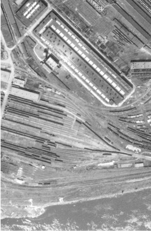
1950 – Cette vue aérienne laisse voir les nombreuses voies ferrées ajoutées au sud-est de l'atelier des locomotives, sur un large remblai effectué dans le fleuve Saint-Laurent. Source : Photothèque nationale de l'air, rouleau A12584, photo 45 (extrait), échelle 1:10 000.
