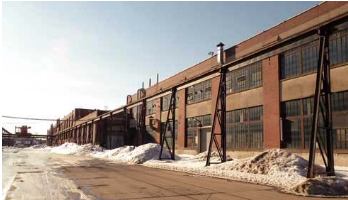
La façade sud du bâtiment vue en direction ouest, avec le pont roulant extérieur.
