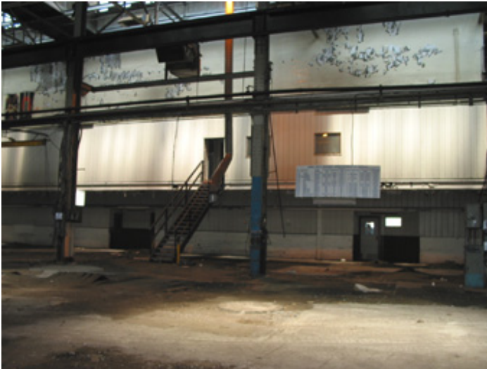
Des espaces de bureaux ont été aménagés à l'intérieur de l'atelier.
