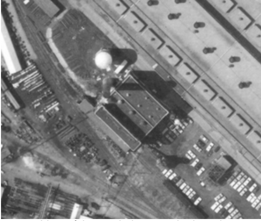
1965 – Vue aérienne de la centrale thermique et des structures annexes, ainsi que d'un espace de stationnement aménagée du côté est.
