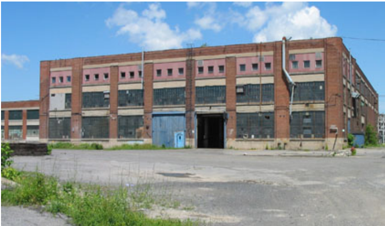
Façade sud du « Foundry and Pattern shop », soit le côté du bâtiment abritant les ateliers des patrons se déployant sur trois étages.
