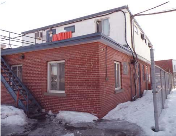
Vue de l'angle nord-est du poste de garde.
