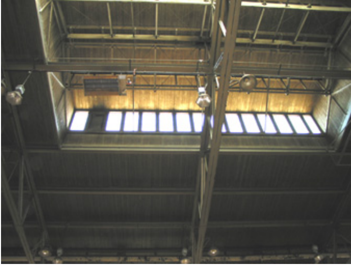
L'apparence de la structure et du plafond a conservé un haut niveau d'intégrité physique.
