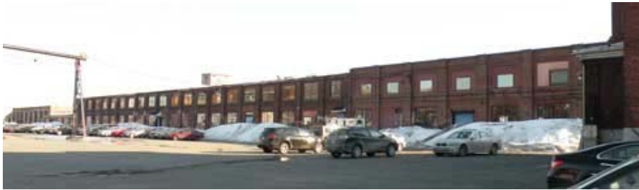
La façade nord du bâtiment des magasins.
