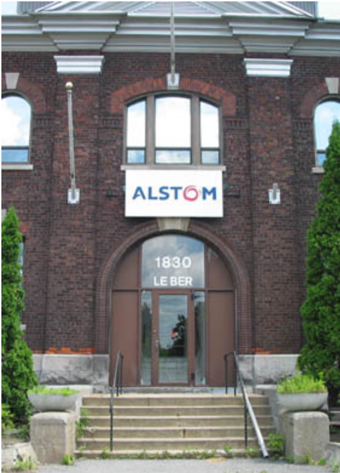
Vue de l'entrée principale du bâtiment administratif telle qu'elle se présentait lors de notre visite du site. La circulation s'effectue cependant plutôt par l'entrée secondaire, à l'arrière du bâtiment.
