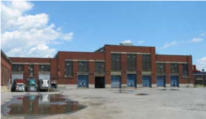
La partie droite du mur de la façade ouest, quelques mois avant l'incendie.
