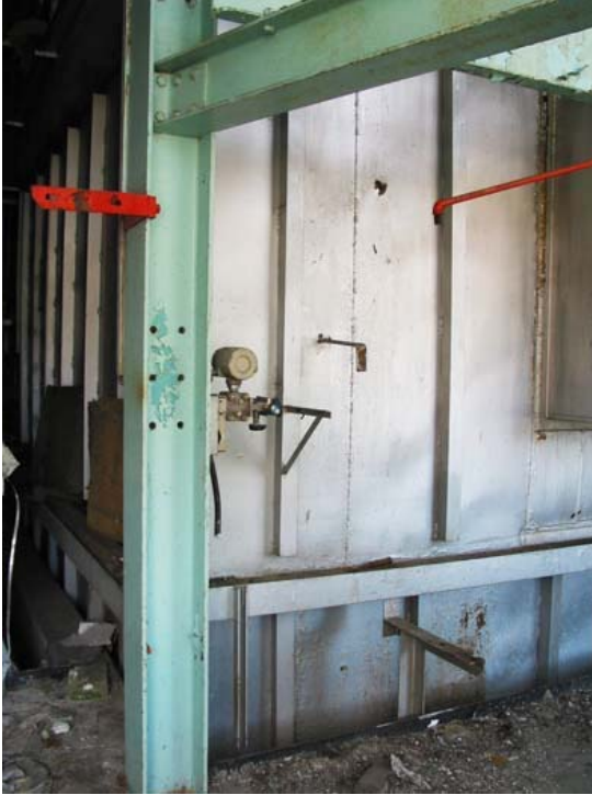
La bouilloire est construite à l'intérieur de la structure d'acier du bâtiment.
