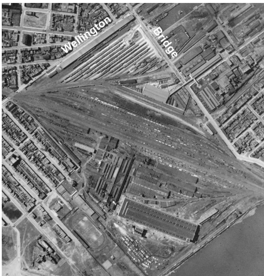
1929 – Extrait d'une photographie aérienne du site pendant son réaménagement par le Canadien National. À l'époque, il est toujours délimité par les rues Wellington à l'ouest et Bridge au nord. On y aperçoit le long hangar construit sur la rue Wellington quelques années auparavant ainsi que l'immense atelier des locomotives venant tout juste d'être érigé, au bas de la photo. Plus de 1100 personnes y seront employées au début des années 1930.
