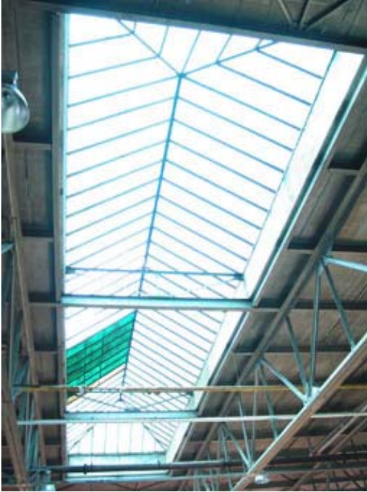
Le puits de lumière surplombant la table de transfert.
