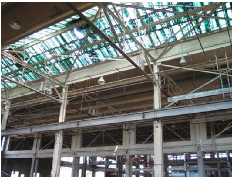
La structure d'acier à l'intérieur du « Wheel Shop ».
