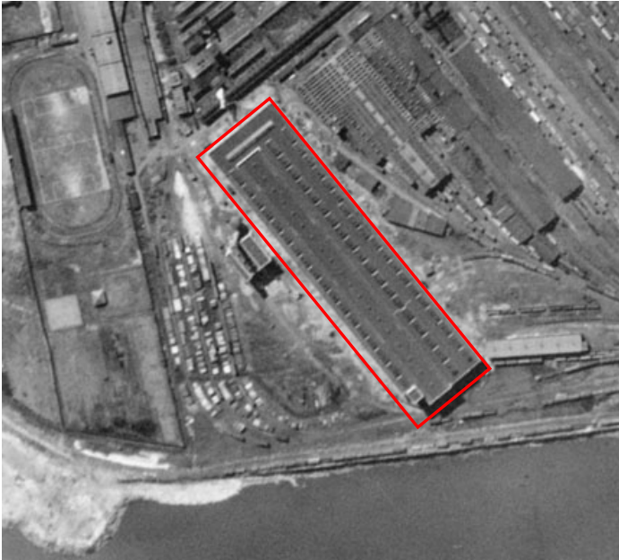
1929 – Le nouvel atelier des locomotives vient tout juste d'être érigé au moment où cette photographie est prise. Son extrémité du côté est se trouve alors à quelques mètres du fleuve.
