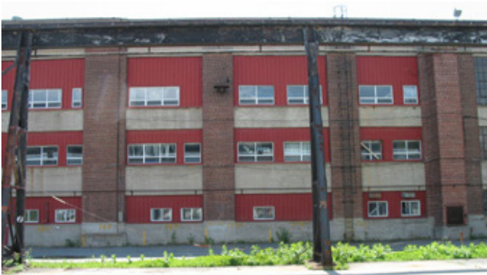
Des fenêtres obturées sur la façade nord du bâtiment.
