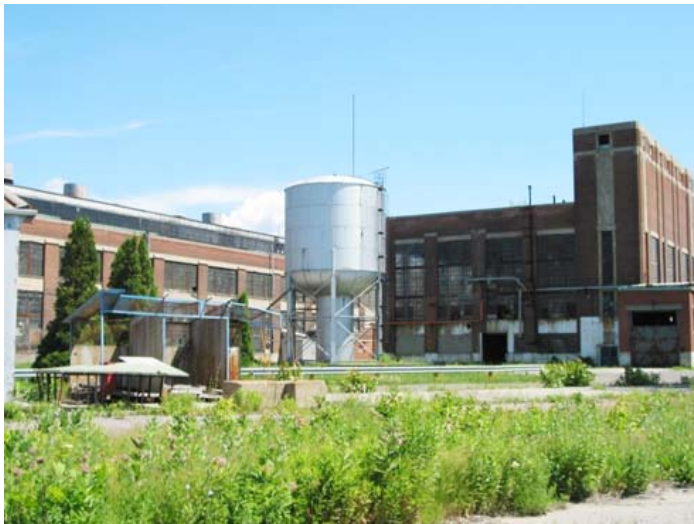
La façade principale de la centrale thermique, avec une tour d'eau devant et, à gauche, l'atelier des locomotives. Des plantes ont poussé de façon sauvage sur le terrain.
