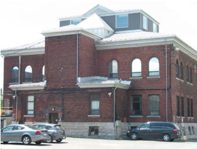
Vue de la façade arrière du bâtiment administratif, avec sa volumétrie d'origine.
