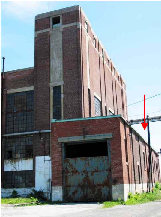
La section attenante à l'aile de déchargement du charbon a été ajoutée à une date inconnue.
