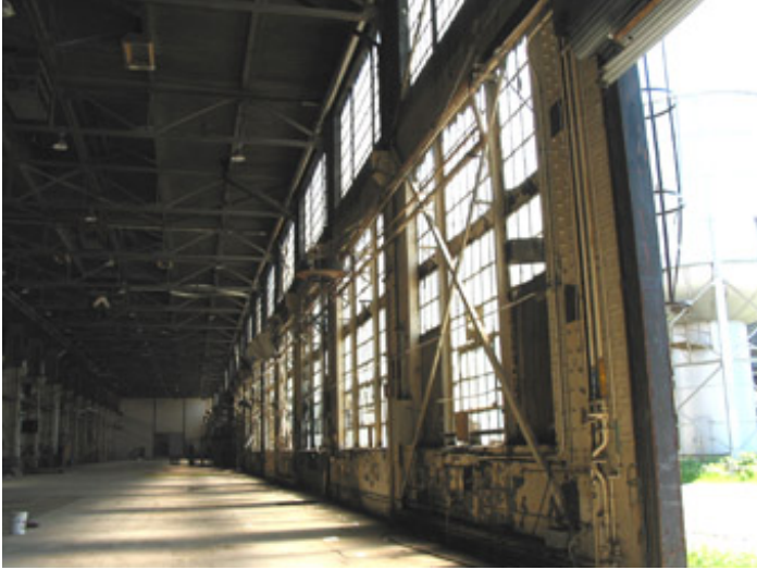
Un abondant fenêtrage sur les façades latérales permet à la lumière naturelle d'envahir l'intérieur de l'atelier.
