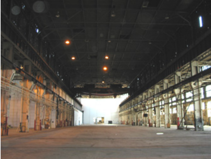
Une cloison temporaire a été érigée afin de subdiviser l'espace intérieur pour la tenue d'un tournage cinématographique.
