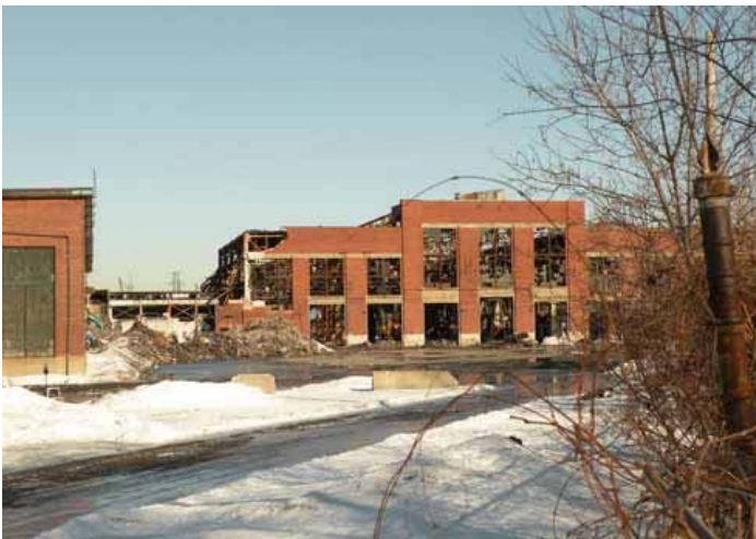
La même vue du bâtiment après l'incendie.
