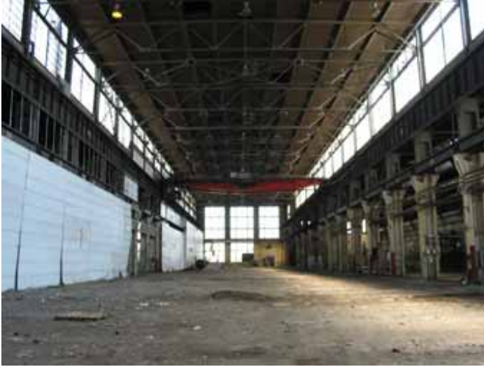
Des fenêtres en bandeaux permettent à la lumière naturelle de pénétrer à l'intérieur de la partie centrale des ateliers.
