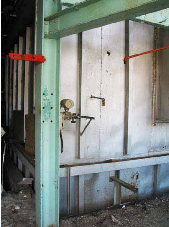
La bouilloire est construite à l'intérieur de la structure d'acier du bâtiment.
