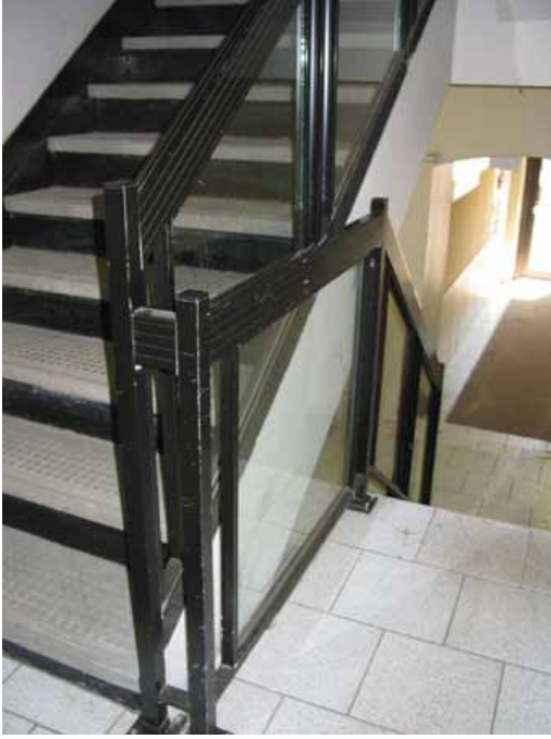
L'escalier central a été complètement refait, mais semble demeuré au même emplacement.
