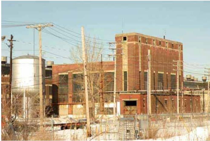
Vue des façades ouest et sud de la centrale thermique. On aperçoit l'aile de déchargement à droite.
