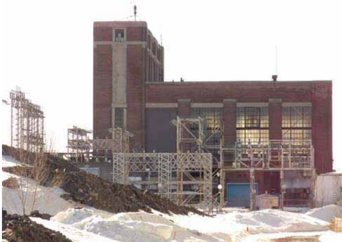
Les installations liées à la production d'électricité se trouvant derrière le bâtiment.
