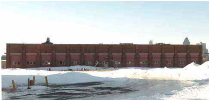
La façade est du bâtiment, dont toutes les ouvertures ont été partiellement murées.
