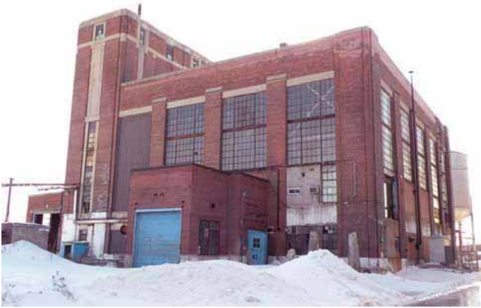
Vue de la façade est de la centrale thermique.
