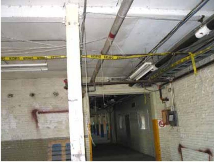
Passage de la première section du bâtiment à la seconde. Celle-ci, une structure de murs de brique massifs et de poutres et piliers d'acier, fait partie de la série de trois sections érigées en première phase de construction du bâtiment.
