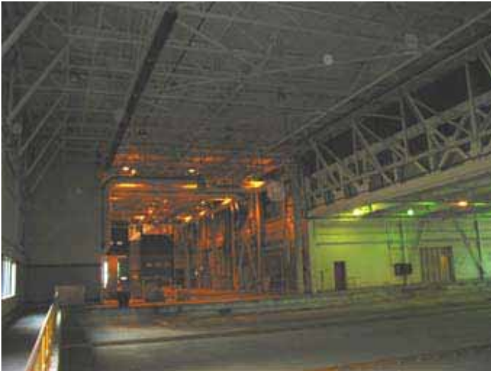
Vue de la table de transfert vers la section ouest du bâtiment.
