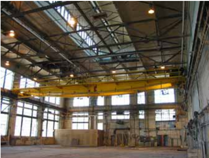
Les puits de lumière ainsi que les ponts roulants sont toujours en place.
