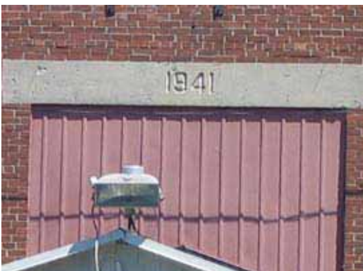
L’année de construction de l’atelier des essais, gravée sur le linteau de la porte centrale.
