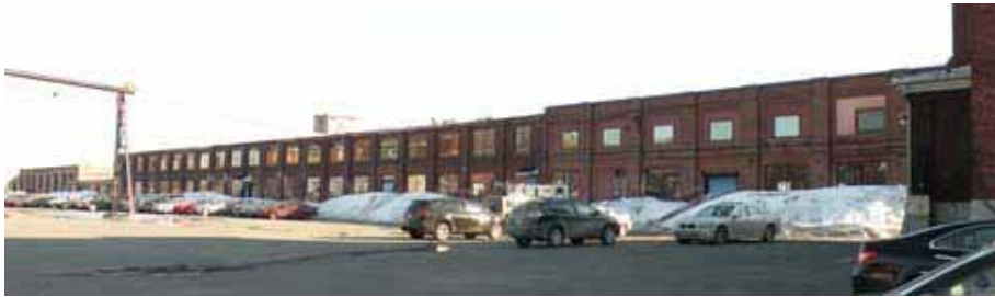
La façade nord du bâtiment des magasins.
