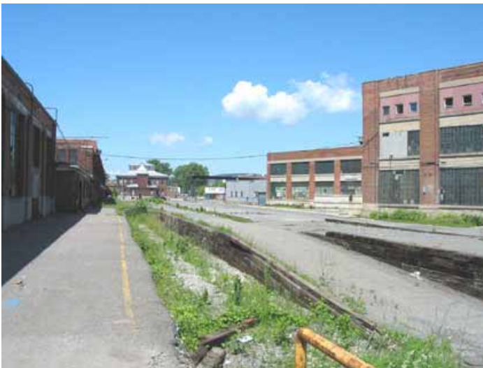
Le terrain situé entre le bâtiment des magasins (à gauche) et l'atelier des roues, la fonderie et l'atelier des patrons (à droite), où se trouvaient autrefois une voie ferrée et un entrepôt.
