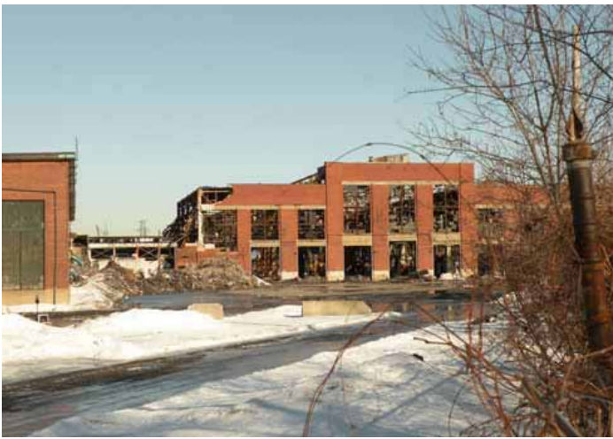
La même vue du bâtiment après l'incendie.
