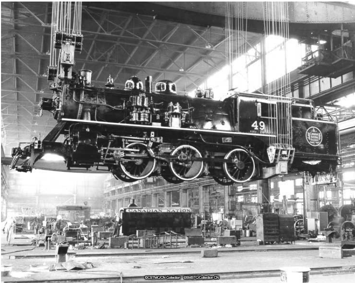
1957 – Une locomotive sur le pont roulant dans l'atelier des locomotives de Pointe-Saint-Charles. Source : BAC, Collection CN, CN000342.
