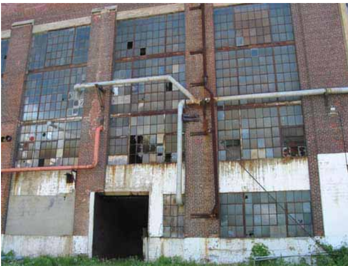
Le mur de la façade principale (façade ouest). On y remarque l'intervention effectuée sur un pilier de brique pour agrandir l'ouverture.
