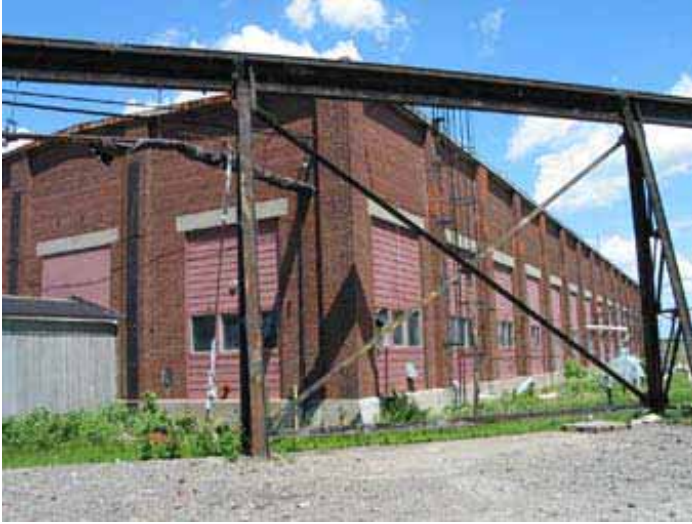
Des interventions similaires ont été réalisées aux ouvertures latérales du bâtiment.
