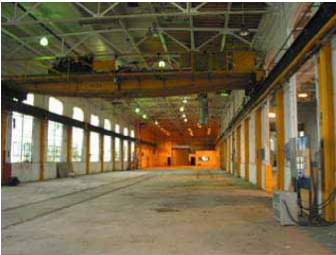
L'intérieur de la première partie du bâtiment. Le pont roulant appuyé aux murs est demeuré en place. On distingue la forme arquée du haut des fenêtres.
