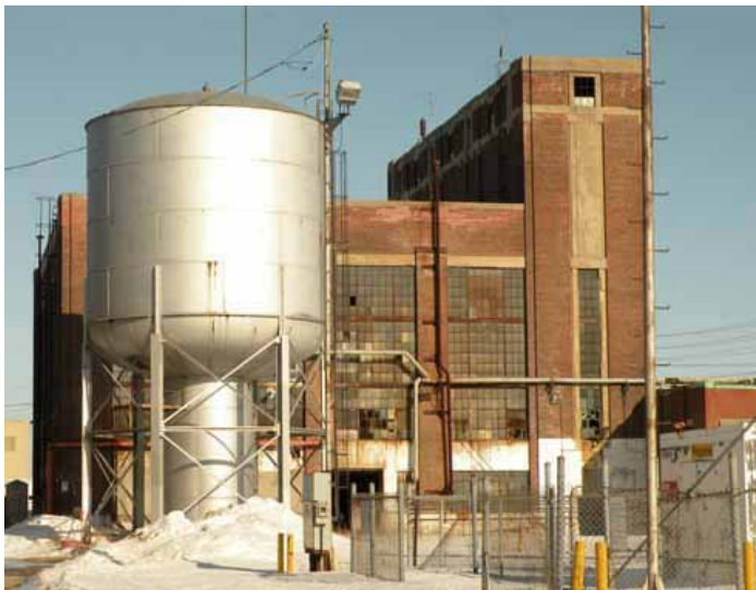
La façade ouest et la tour d'eau qui se trouve devant.
