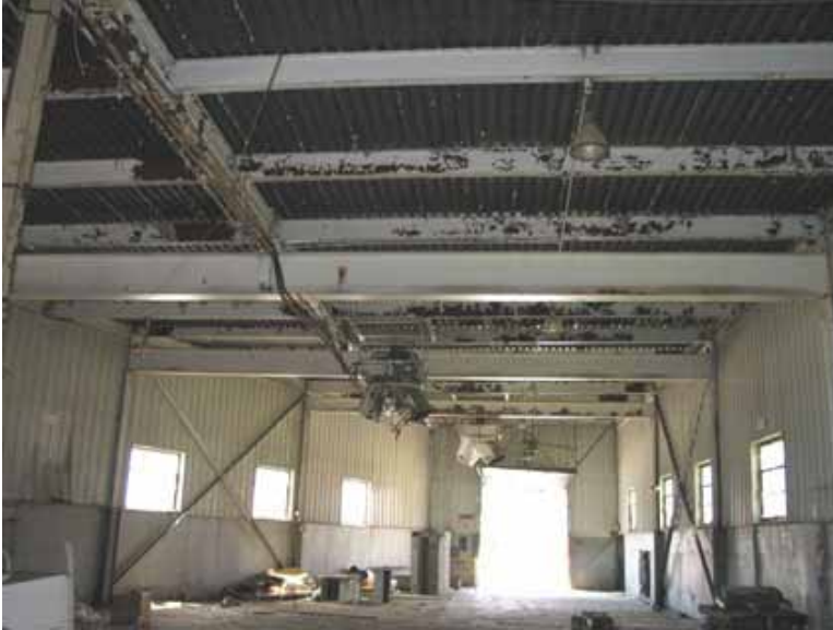
L'intérieur du hangar ayant servi d'aire d'entreposage.
