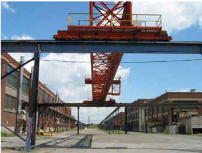
Le pont roulant extérieur se trouve entre l'atelier des locomotives et le bâtiment ayant abrité la fonderie, l'atelier des patrons et l'atelier des roues du côté sud (à droite) et, au nord, l'atelier des wagons (à gauche).
