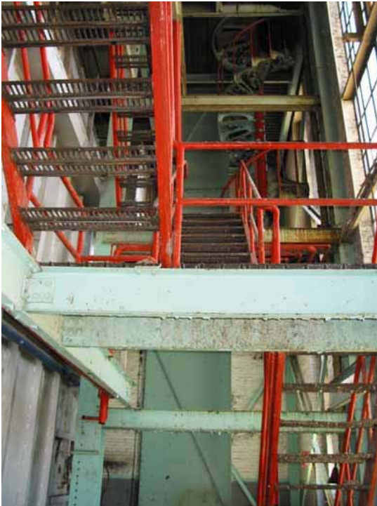
L'escalier métallique intérieur entre le mur de la façade principale et la bouilloire. On aperçoit également la structure d'acier qui se rattache au mur.
