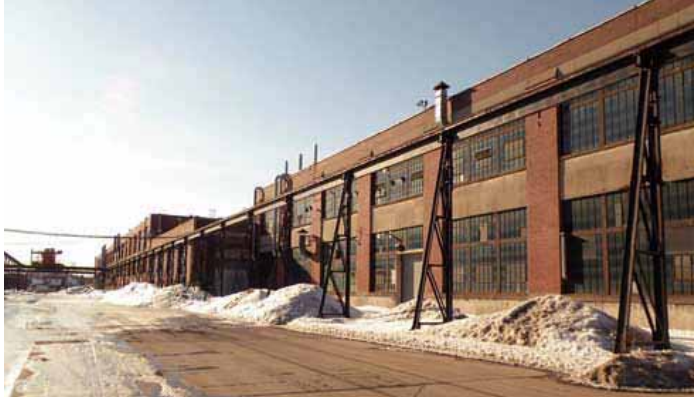
La façade sud du bâtiment vue en direction ouest, avec le pont roulant extérieur.
