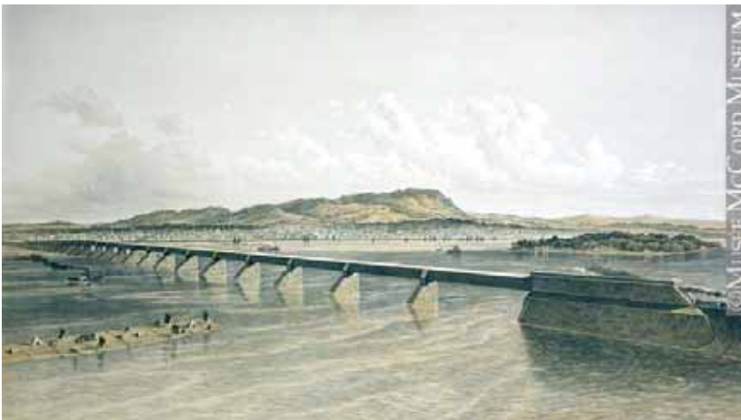
1860 – Le pont Victoria peu après son ouverture. Sa structure tubulaire initiale permettait uniquement le passage de trains. Source : Musée McCord, peintures, estampes et dessins, S. Russell, M15934.1.
