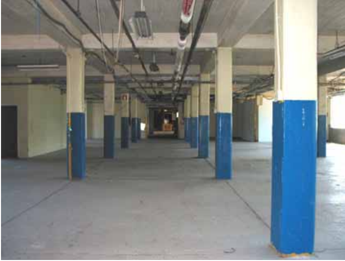
Une autre vue intérieure laissant bien voir la structure de poutres et de piliers en béton.
