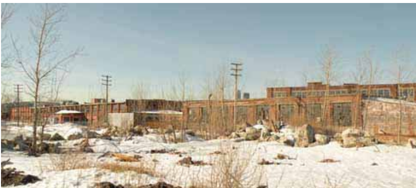
Vue de la façade sud du bâtiment des magasins, donnant actuellement sur un terrain vacant.
