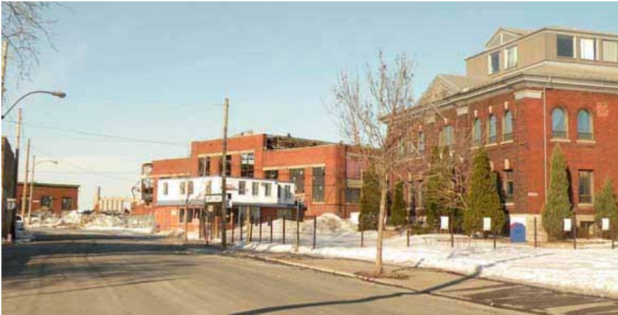
Vue de la rue Le Ber en direction nord, montrant l'entrée du site avec le poste de garde, le bâtiment administratif (en avant plan) et l'atelier des wagons, derrière le poste de garde. On entrevoit au loin les silos à grain situés dans le Vieux-Port de Montréal, par la brèche causée par la destruction partielle de l'atelier des wagons suite à son incendie.
