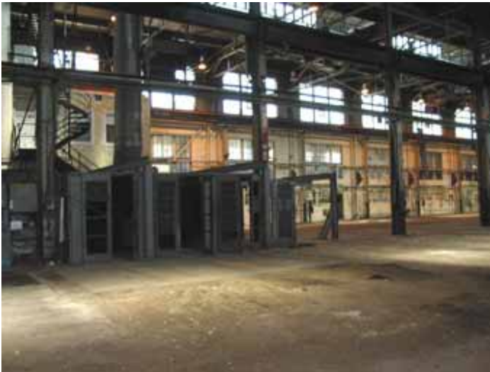
D'anciennes chambres à peinture en acier sont toujours en place dans l'atelier.
