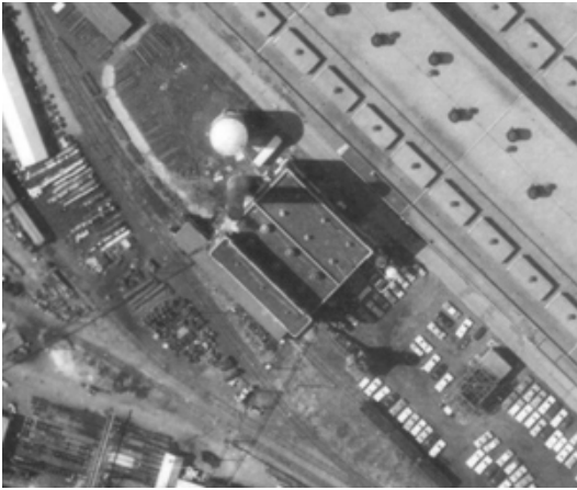
1965 – Vue aérienne de la centrale thermique et des structures annexes, ainsi que d'un espace de stationnement aménagée du côté est.
