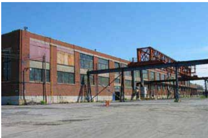
Le mur de la façade sud avant l'incendie, voisiné par le pont roulant extérieur se trouvant entre l'atelier des wagons et l'atelier des locomotives.
