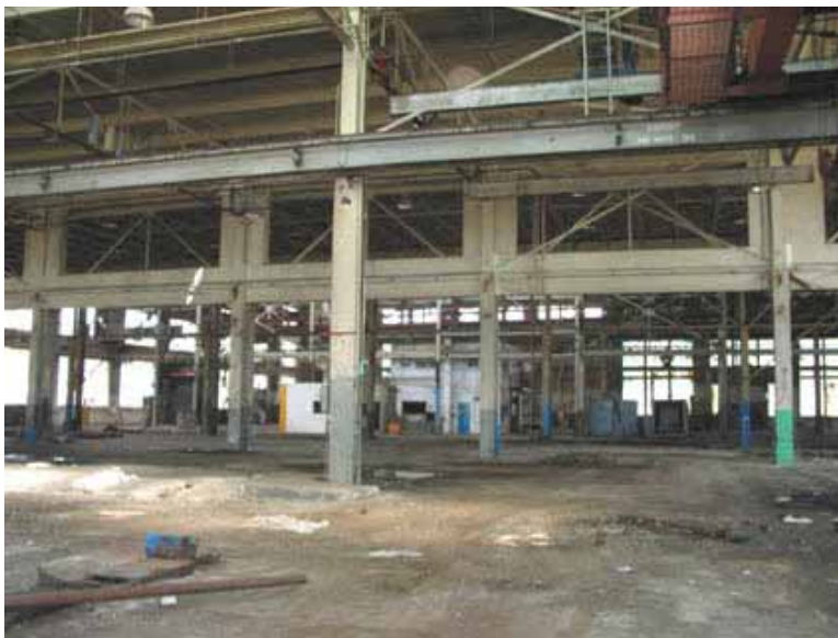
L'espace intérieur du bâtiment D, dénué de sa machinerie.
