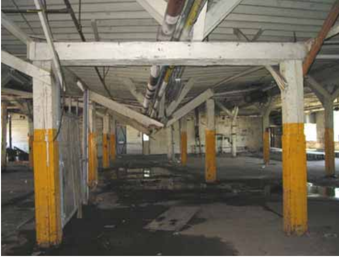
Vue intérieure de la section du bâtiment construite en deuxième phase. Cette section, moins élevée que les autres, comporte une hauteur de plafond équivalant à un seul étage. Elle est la seule section soutenue par une structure en bois, qui a d'ailleurs partiellement cédé sous la charge de la neige accumulée sur le toit.
