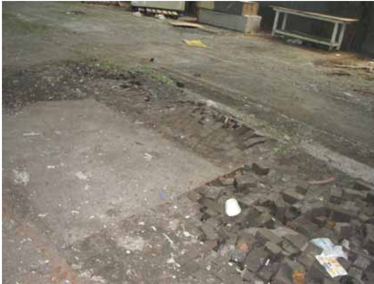
Certaines sections du bâtiment D ont des planchers faits de blocs de bois debout.
