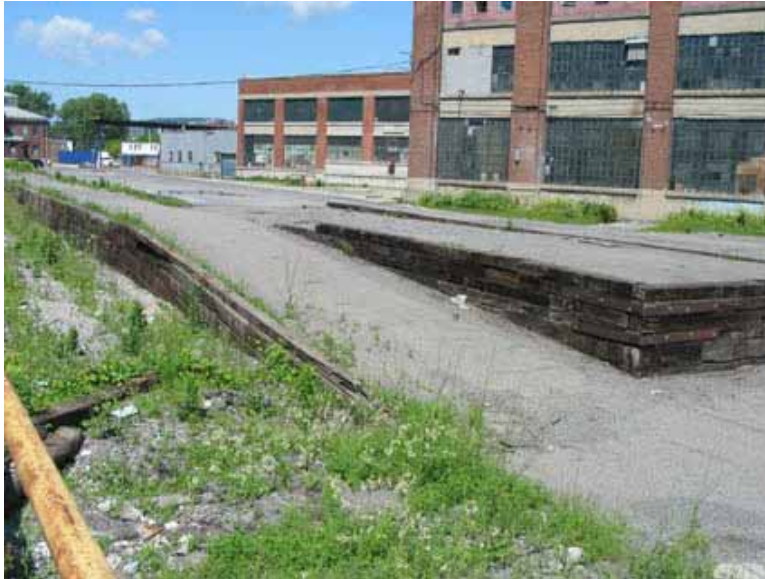
La façade sud de l'ensemble des structures formant le bâtiment D et le terrain la bordant, aménagé pour faciliter le camionnage.
