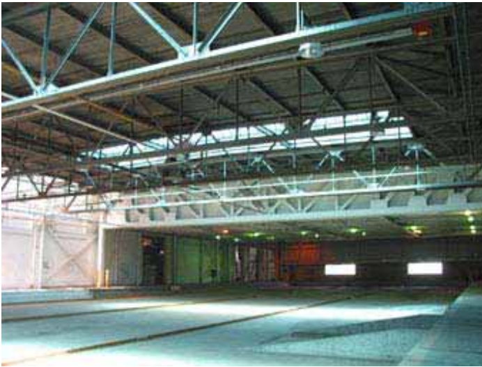
La table de transfert, reliant les deux parties principales de l'atelier des wagons.
