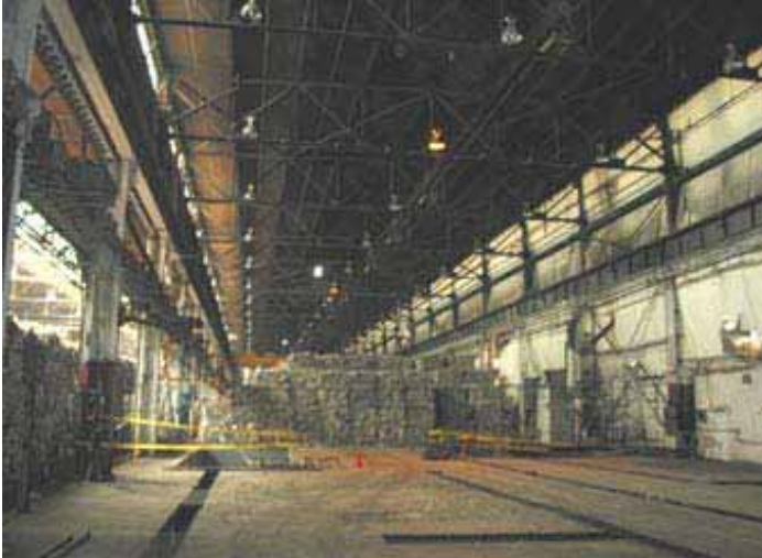
L'entreposage de papier dans la section ouest, avant l'incendie.
