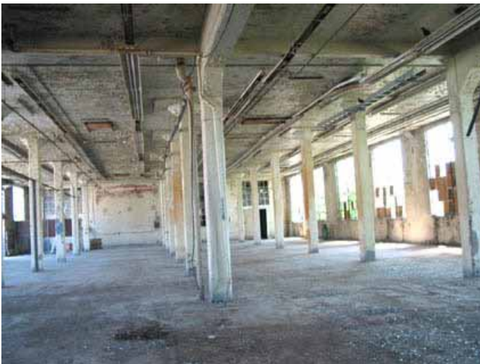
Intérieur de la section ouest du bâtiment, érigée vers 1931 lors d'une troisième phase de construction des magasins, comporte une structure de béton.
