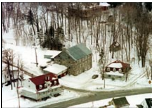
Site du Manoir Dionne, Saint-Roch des Aulnaies aire de protection décrétée en 1975
