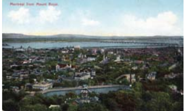
Carte postale illustrant le réservoir McTavish avant son recouvrement par une dalle de béton en 1947
