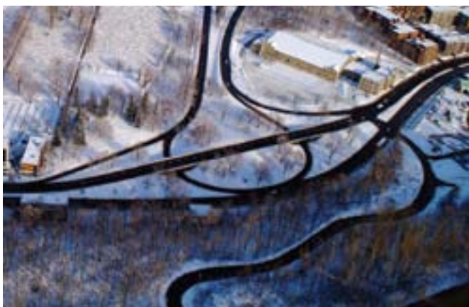
Le réaménagement de l'échangeur Côte-des-Neiges – Remembrance facilitera l'accès au parc du Mont-Royal.
