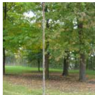
L3 Poteau électrique isolé. Fût en acier. À enlever.
