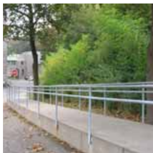
E1B Rampe d'accès à l'escalier de bois. La rampe en béton et les mains courantes sont en acier peint, en assez bon état. Elle permet d'offrir un trottoir protégé des autos. Elle n'est pas conforme et inutilisable comme accès universel, et peu intégrée à l'environnement.
