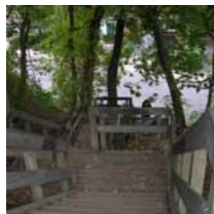
E3 Escalier en bois à plusieurs volées. Un des deux escaliers localisés au sud-est. Il rejoint le chemin Saint-Sulpice en contrebas. Il possède une forte dénivellation et parcours intéressant du piéton sous un épais couvert végétal. Il est en bon état général. Il mérite d'être davantage intégré au talus et à l'ensemble des aménagements.
