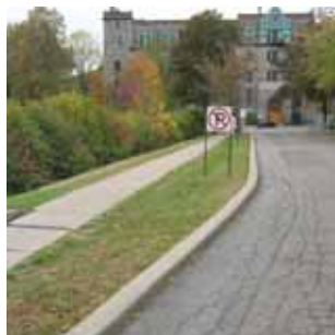
S2B Panneaux de signalisation avec l'inscription «stationnement interdit». Ils sont situés sur le terre-plein engazonné.
