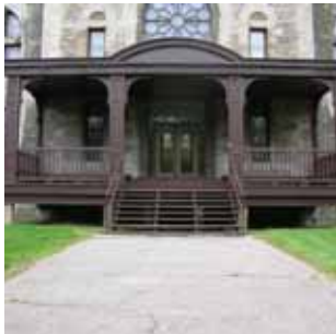
P7 Escalier d'accès principal au bâtiment. Il fait partie de la composition d'ensemble du portique d'entrée. En bois peint il a 7 contremarches et une main-courante en acier peint. Il offre une bonne largeur et contribue à l'ornementation de l'entrée. Il est en état moyen, à restaurer.
