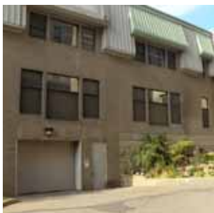
P16 Porte de garage du gymnase. Elle est de plein-pied avec le sol adjacent.
