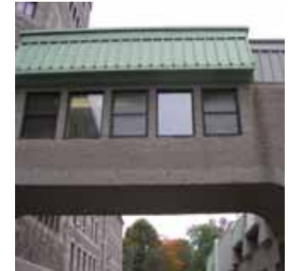
P12 Porche avec passage aérien reliant le nouveau bâtiment et l'ancien.
