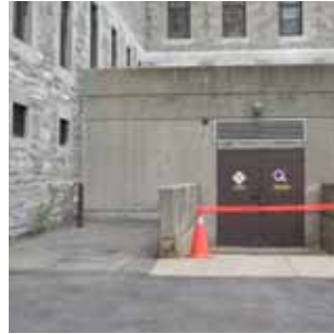
P3 Accès à la chambre électrique d'Hydro-Québec par une rampe en béton coulé. L'espace pourrait avoir un aménagement mieux intégré à son contexte.
