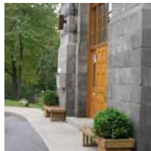
L5C Appliques murales rectangulaires en aluminium et de couleur marron foncé. Situées de part et d'autre de l'entrée du bâtiment donnant sur le chemin de la Côte-des-Neiges, elles identifient l'accès et éclairent les bancs. En bon état.
