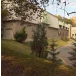
T1 Talus engazonné longeant le bâtiment arrière. Il permet de cacher une partie de la fondation du bâtiment et d'offrir un peu de verdure à côté de la voirie asphaltée. En avant-plan, on remarque le talus qui suit le contour de la voirie dont la dénivellation est assez forte. Ce talus est le seul talus engazonné dans lequel on retrouve quelques conifères matures.
