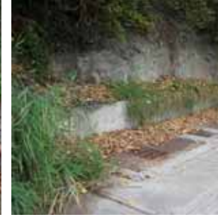
M8 Petit muret en béton coulé qui permet l'accès aux puits électriques de la ville et contrôle les éventuelles chutes de pierres. Muret en bon état et possédant un aspect visuel moyen.
