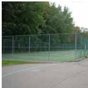
C3 Clôture périmétrique des courts de tennis, en mailles de chaîne. Elle est en bon état et spécifique à la fonction.
