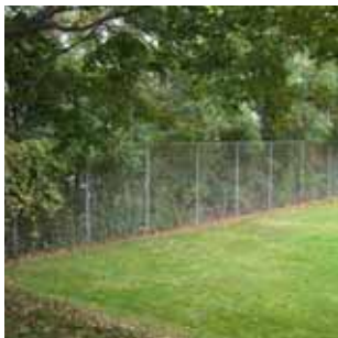
C1 Clôture à mailles de chaîne de +/- 3.0 m de haut. Elle ferme le côté sud du terrain de sport. Elle assure la sécurité des usagers puisqu'elle empêche l'accès à l'escarpement sud. La clôture C2 se trouve dans sa continuité. Elle est en bon état.
