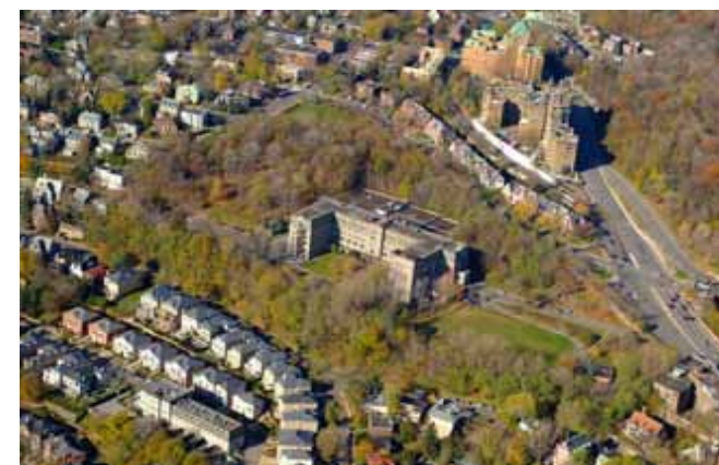
Figure 50 : vue aérienne actuelle, nov.2006, source : ville de Montréal
