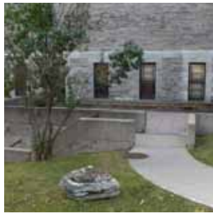
P2 Accès au niveau inférieur du terrain par un escalier de béton coulé. Le trottoir donne aussi sur une petite cour dallée aménagée sur un toit. En assez bon état mis à part les bancs en bois qui seraient à changer sous peu.
