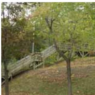
E1A Escalier d'accès à Côte-des-Neiges. Escalier en bois traité à volées multiples avec plusieurs paliers créant de petits belvédères. En assez bonne condition, il sert de lien aux joggers et autres usagers. Il contribue aussi à la compréhension de la topographie. Il mérite d'être davantage intégré au talus et à l'ensemble des aménagements.
