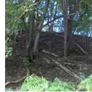
T5 Grand talus de l'escarpement sud, partie est. Il est planté d'arbres matures, mais les problèmes de bois morts et d'érosion des pentes ainsi que le manque d'entretien sont flagrants. En hiver, il permet des vues partielles vers le bâtiment. Un escalier de bois le traverse. Sa forte dénivellation en fait un élément marquant dans le paysage bien qu'infranchissable.
