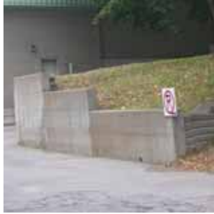
M2 Mur de soutènement en béton coulé et en escalier retenant le talus près de la zone des conteneurs. Muret en état moyen et auquel des murets de blocs de béton ont été ajoutés pour un contrôle probable de l'érosion. Intérêt visuel peu élevé.
