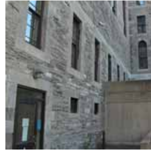
P4 Porte d'issue secondaire localisée sur la façade sud-est.
