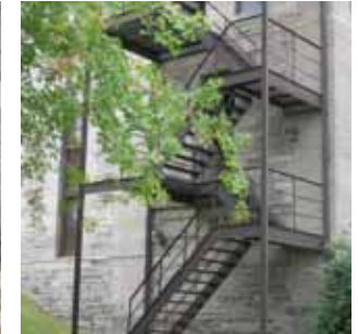
P6 Escalier de service et d'issue. Situé sur la façade sud-est du Séminaire, il dessert tous les étages. En acier peint, il est fixé sur plusieurs bases de béton. Il est en assez bon état, mais présente un intérêt visuel peu élevé. Il offre assez de transparence vers la façade.
