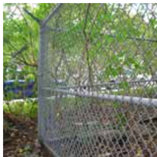
C7 Clôture à mailles de chaîne située à l'intérieur du site, le long de l'avenue Cedar et derrière le bâtiment. Elle est en bon état.
