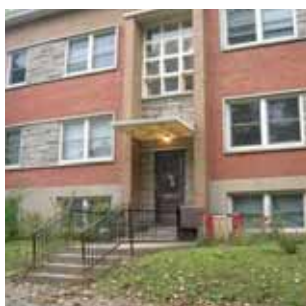
P19 Escalier de béton coulé en façade du bâtiment résidentiel. La main-courante est en acier peint. L'escalier est en bon état.
