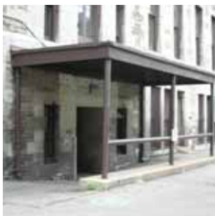
P13 Accès au sous-sol du bâtiment avec rampe d'accès en asphalte. L'accès est surplombé par une marquise de qualité moyenne.
