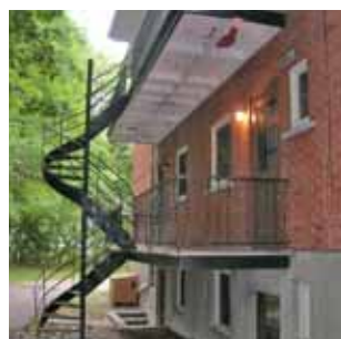
P18 Escalier de secours à l'arrière du petit bâtiment. Entièrement en acier peint, elle a une forme typique des escaliers d'issues. Elle est en bon état.
