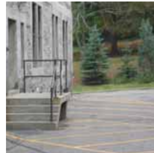
P11 Escalier de service, façade arrière du Séminaire. Il est décollé du sol, en béton coulé avec 3 contremarches et palier. Les mains-courantes et le garde-corps sont en acier peint. Il est en assez bon état.
