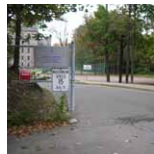
C9 Clôture à mailles de chaîne encadrant l'entrée ouest, place de Ramezay. D'une hauteur de 2.0 mètres, elle est en bonne condition.
