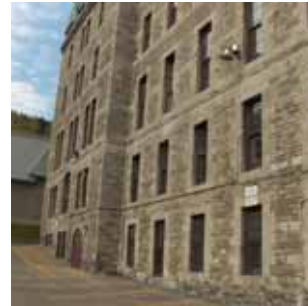
P10 Porte localisée sur la façade sud du bâtiment du Séminaire. La porte est de plein-pied avec le niveau du sol.
