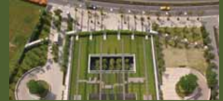
3 Toit-terrace-belvédère - Siège social de Lite-On-Electronic, Taipei, Taiwan
