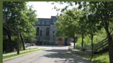
4 Face latérale de l'ancien Séminaire de philosophie
