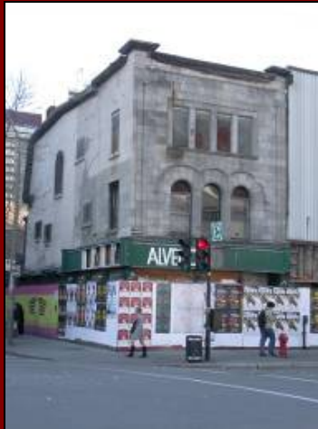
Façade avant Photo : C. Boucher, 2007
