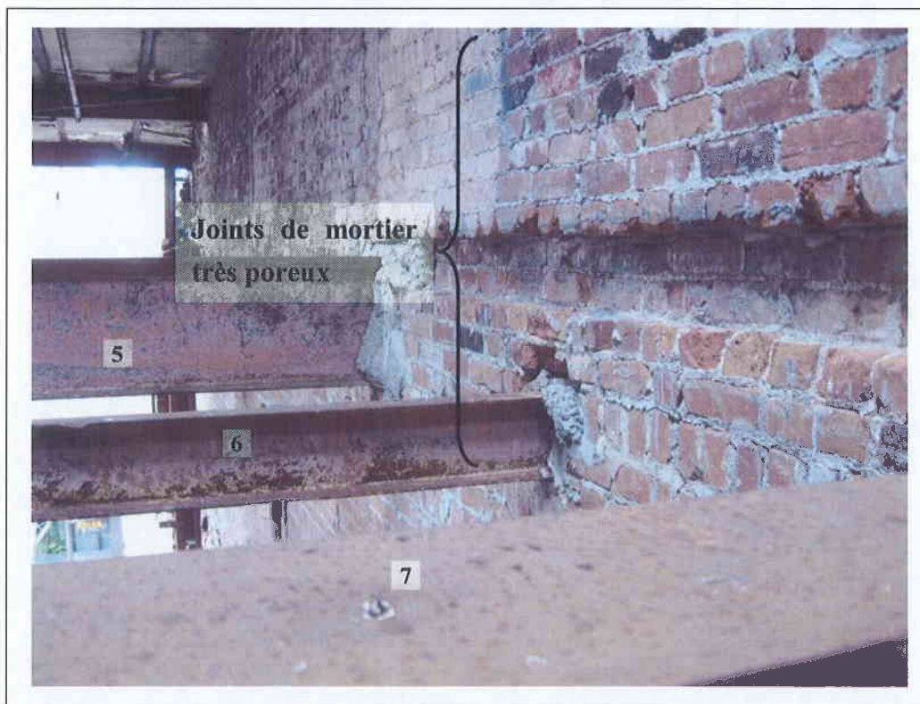
Photo No. 20 – Poutres No. 5, 6 et 7.
