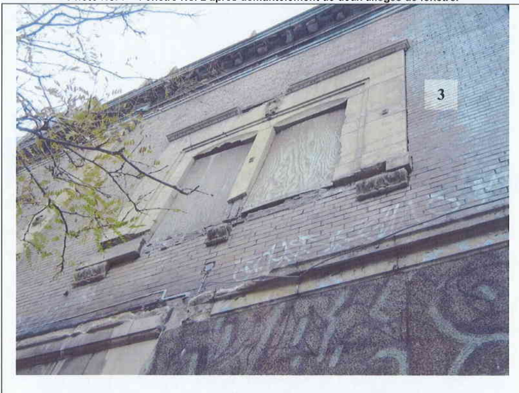
Photo No. 8 – Fenêtre No. 3 après démantèlement des allèges de fenêtre.
