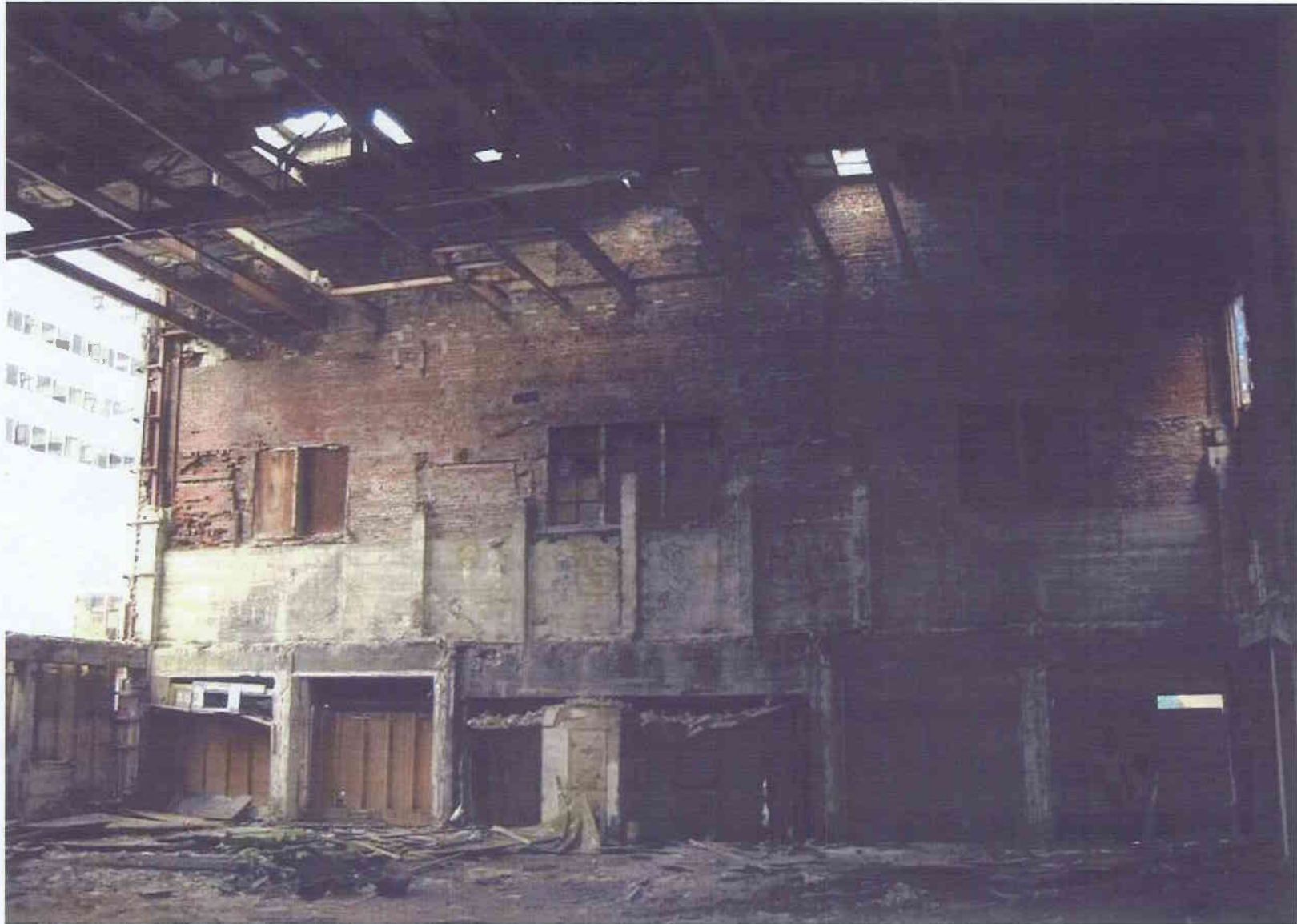
Photo No. 9 – Vue d'ensemble de la façade principale, depuis l'intérieur du bâtiment.
