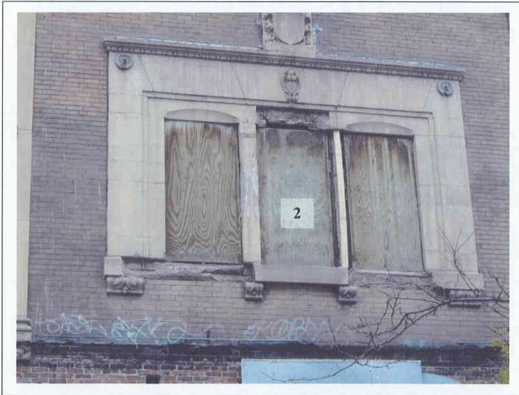
Photo No. 7 – Fenêtre No. 2 après démantèlement de deux allèges de fenêtre.
