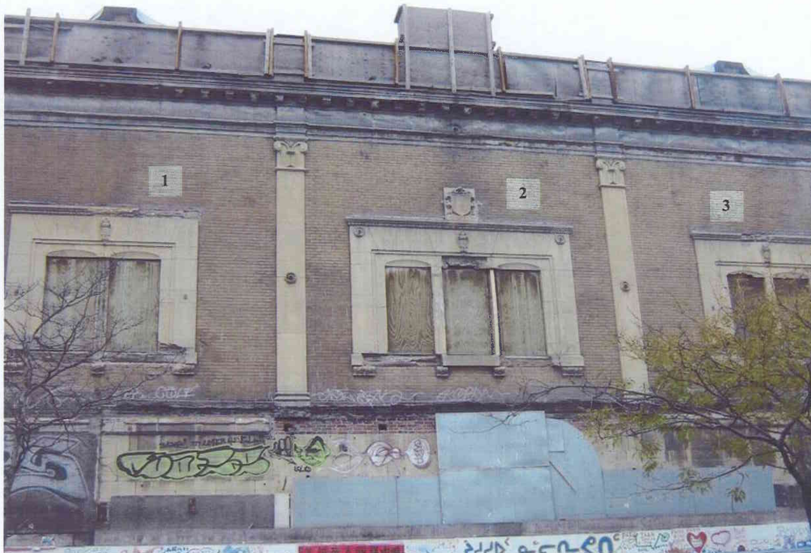
Photo No. 3: Vue d'ensemble de la façade principale, en l'état actuel.
