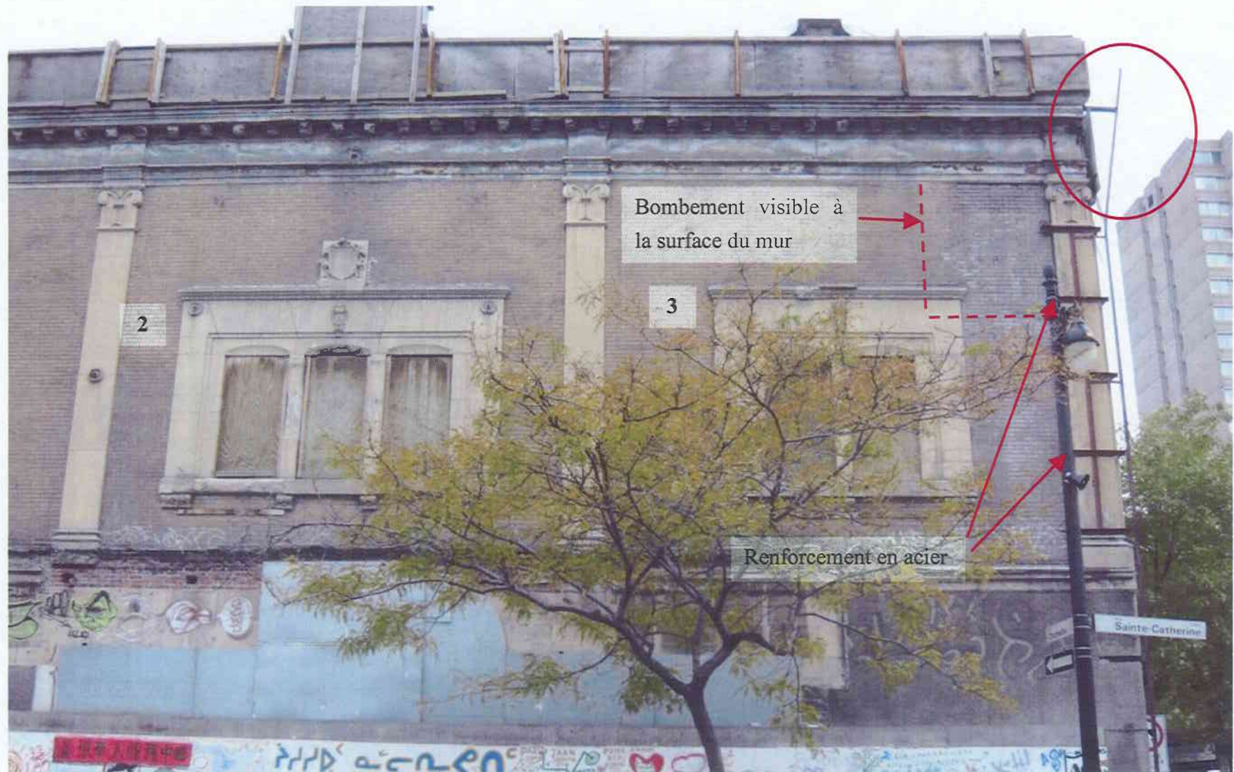
Photo No. 6: Vue d'ensemble de la façade principale, avant intervention sur les fenêtres No. 2 et 3. La colonne sur le bord de droite (de même que celle sur le bord de gauche) est encadrée par des pièces de renforcement d'angle, en acier. La partie supérieure du montage s'est détachée pour une raison inconnue.
