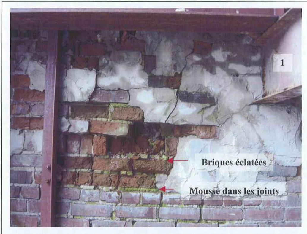
Photo No. 13 – Zoom sur la zone B : dommages sévères liés à une sursaturation à l'eau de la maçonnerie pendant de nombreuses années.
