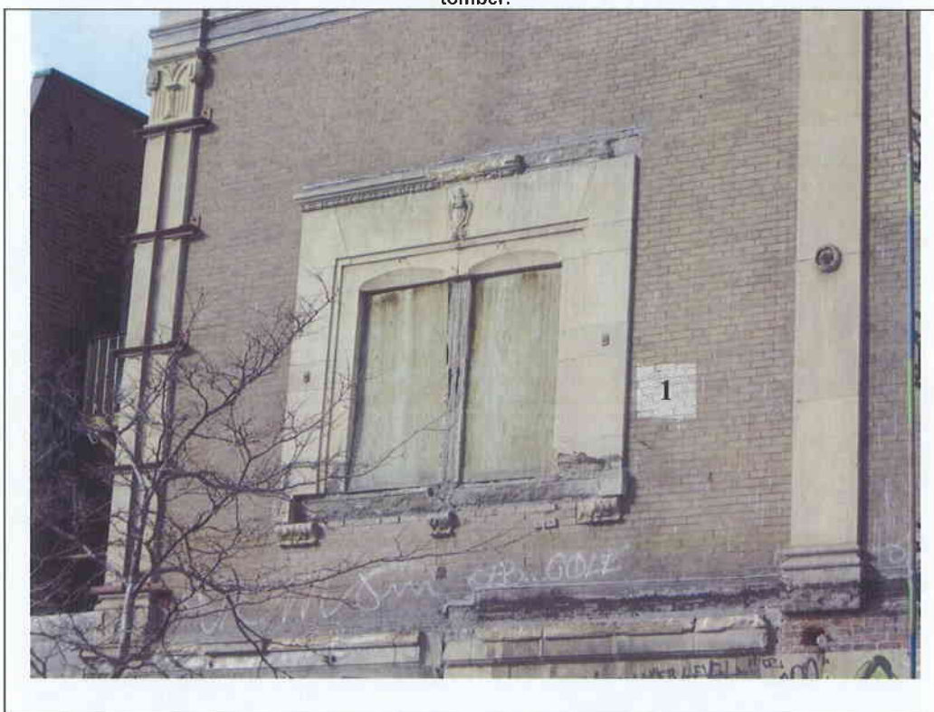
Photo No. 5 – Fenêtre No. 1 après démantèlement des allèges de béton dangereuses.
