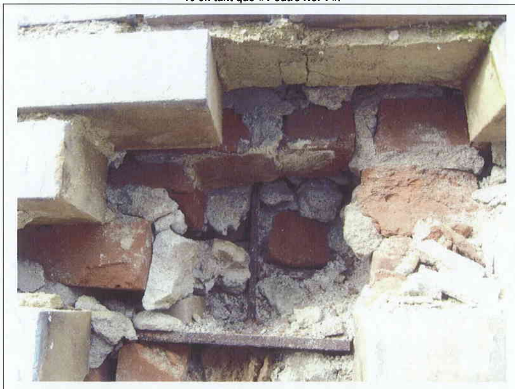
Photo No. 16 – Visualisation, par cette ouverture, de l'extrémité de la poutre No. 1
