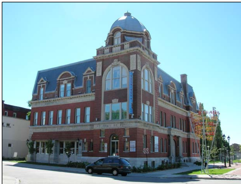
FIG 36 : Ancien hôtel de ville de Sainte-Cunégonde, actuellement le poste incendie no 22 de la Ville de Montréal (Source : http://www.imtl.org )
