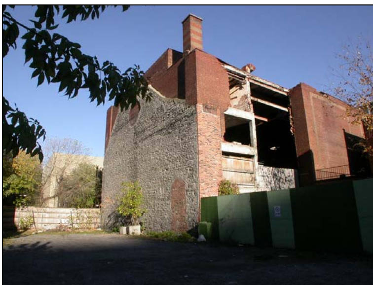
FIG 18 : L'ancien mur de pierre de l'église Douglas construite en 1878 a été intégré au théâtre Séville lors de sa construction (C. Tanguay, 2007)
