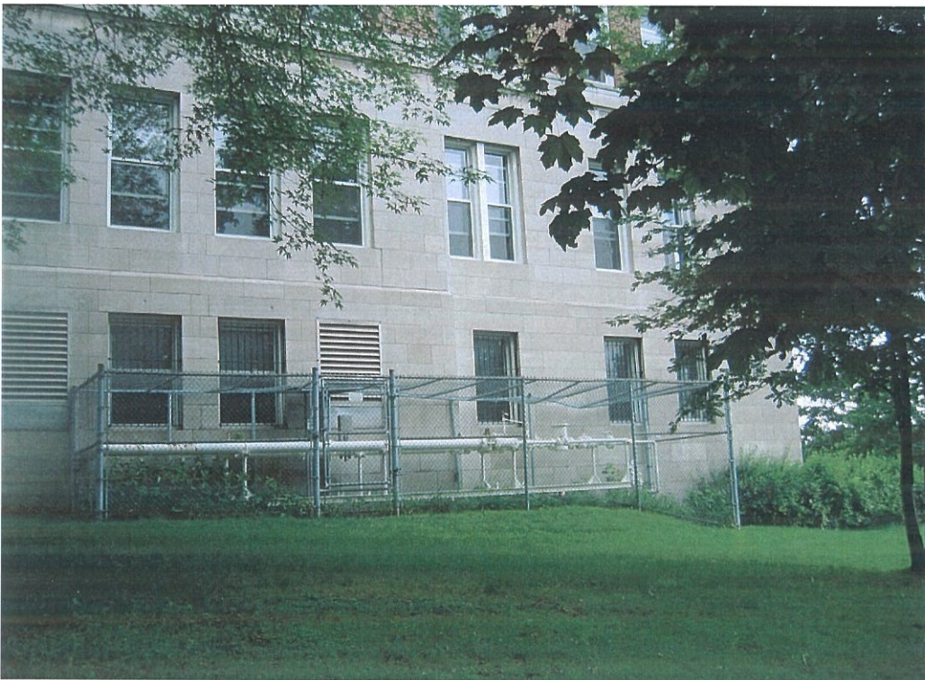
Ajout en façade est
