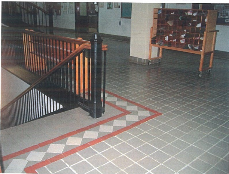
Détails soignés des planchers dans la partie centrale.
