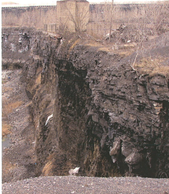
Photo 15 : Section 2, vue de côté
