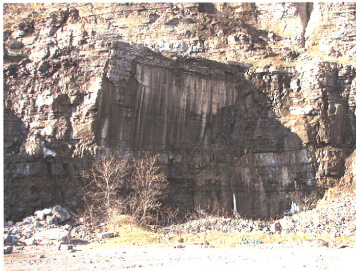
Photo 16 : Section 3, zone de paroi très lisse
