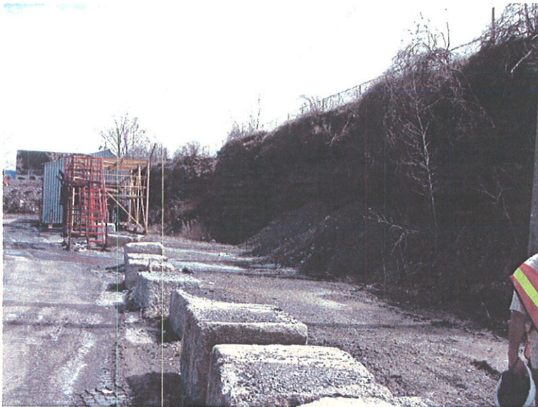
Photo 5 : Vue d'une partie de la paroi du palier 1
