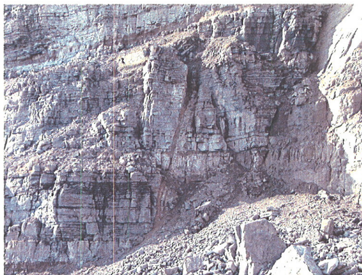
Photo 22 : Section 4, fracture avec remplissage d'argile
