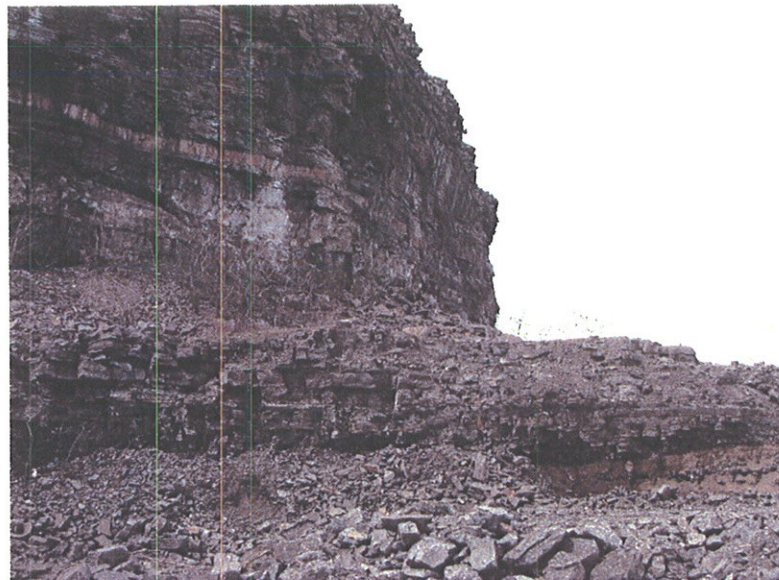
Photo 26 : Section 6, zone de débris
