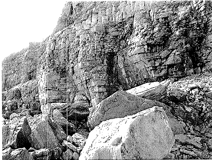
Photo 19 : Section 3, vue d'ensemble d'un talus d'effondrement
