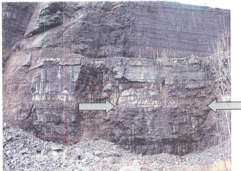
Photo 28 : Partie de la section 4 montrant une zone plus stable que l'ensemble.
