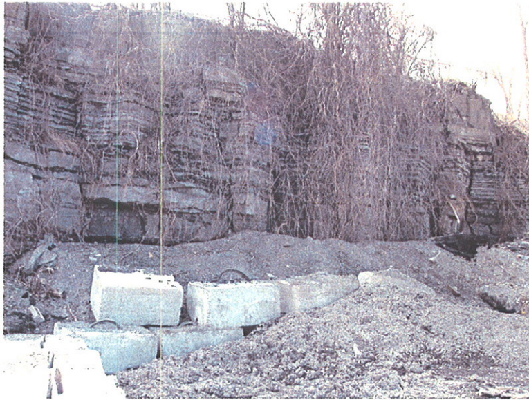
Photo 4 : Présence de fissures et d'instabilité dans la paroi du palier 1
