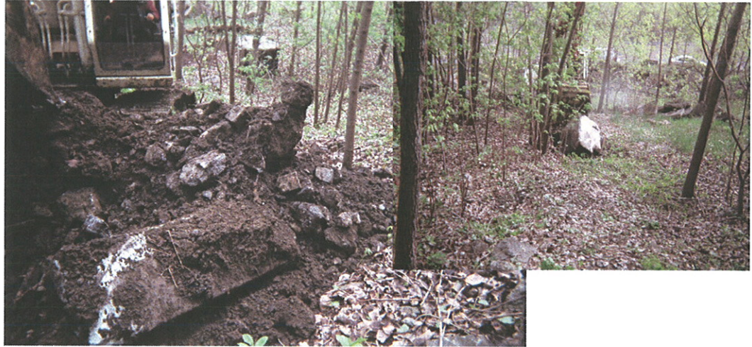
Figure 1 : Réalisation de la tranchée d'exploration PU-01-07 et vue des remblais
