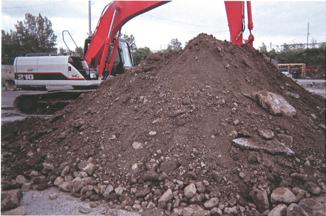
PHOTO N° 5 PU-13-07 : Vue des matériaux excavés
