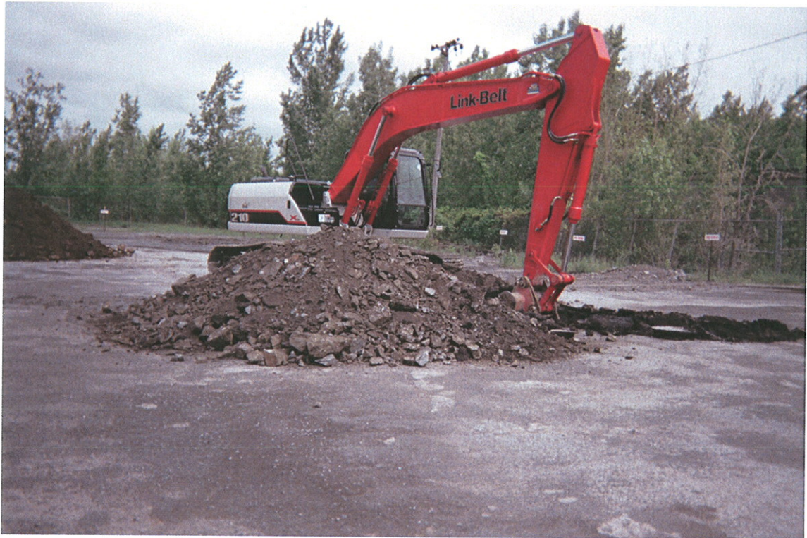
PHOTO N° 9 PU-16-07 : Vue des matériaux excavés
