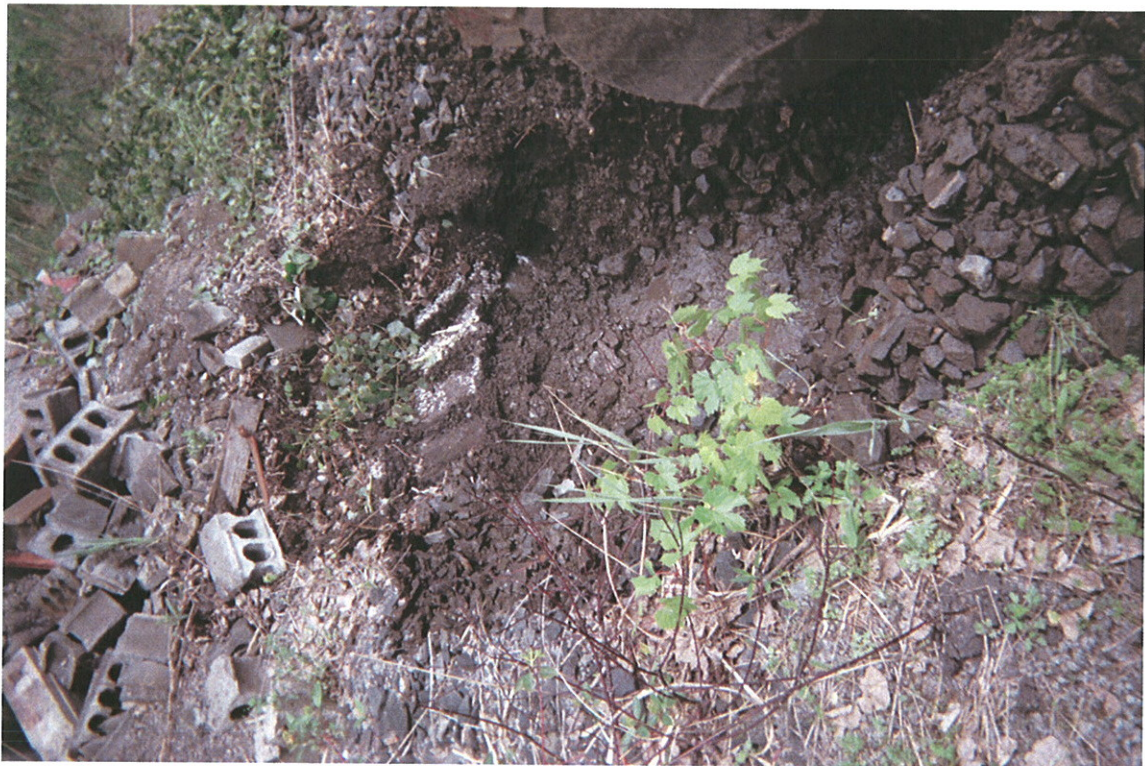
PHOTO N° 10 PU-17-07 : Vue des matériaux excavés
