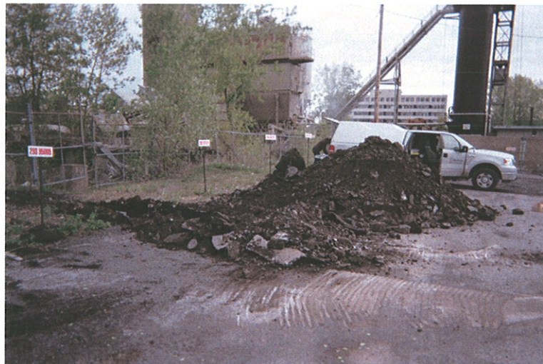
Figure 7 : Tranchée d'exploration PU-11-07 entre 0 et 2 m
