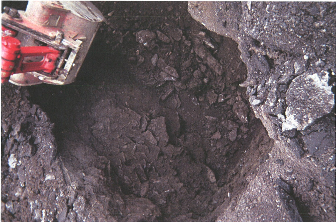
PHOTO N° 6 PU-14-07 : Vue des matériaux excavés
