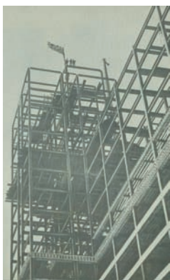
L'hôpital en construction
