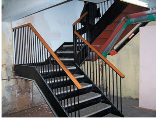
L'escalier central au sous-sol
