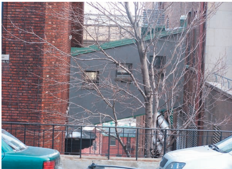
Lien aérien entre l'hôpital et le Travancore
