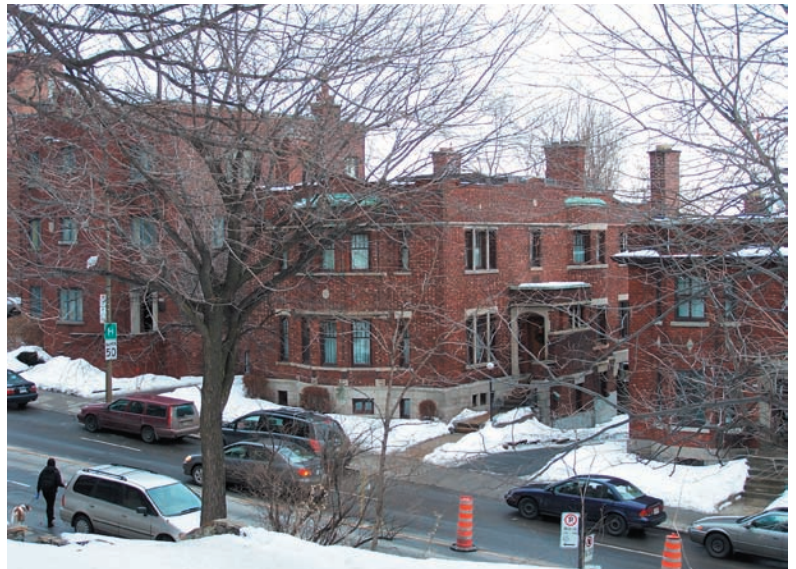
Maison sise sur l'avenue Cedar, à l'ouest de l'hôpital
