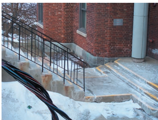
L'entrée du Travancore
