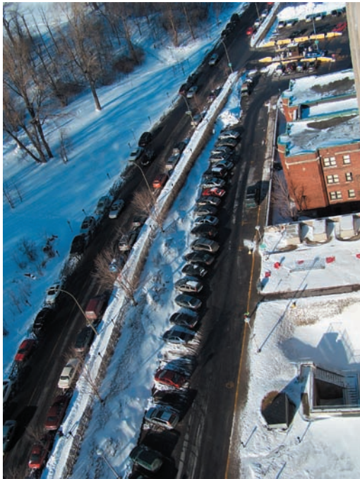
L'avenue Cedar et la voie de service qui lui est parallèle
