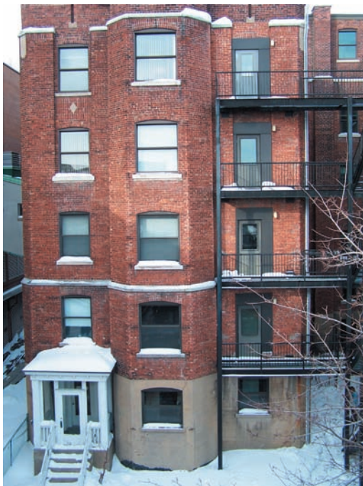
Façade arrière de l'immeuble
