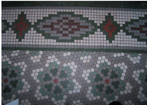
Détail des céramiques aux paliers de l'escalier
