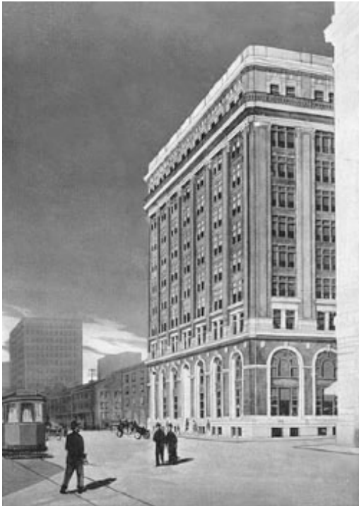
L'édifice Shaughnessy, Hutchison Wood Miller, 1912
