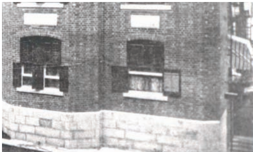
Photo d'origine des fenêtres avec volets
