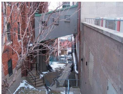
Marge latérale entre le Travancore et l'hôpital
