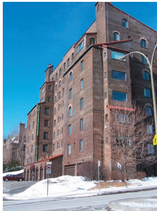
L'immeuble d'appartements Adams, avenue Docteur Penfield
