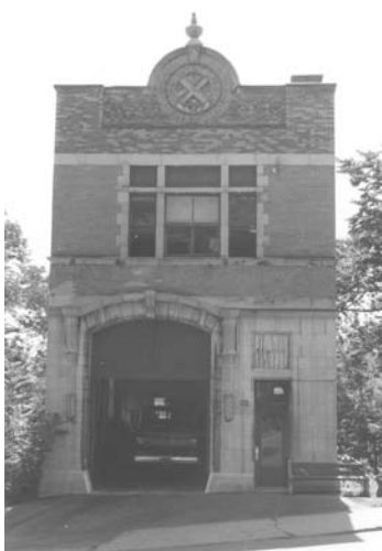
Le poste d'incendie n° 28
